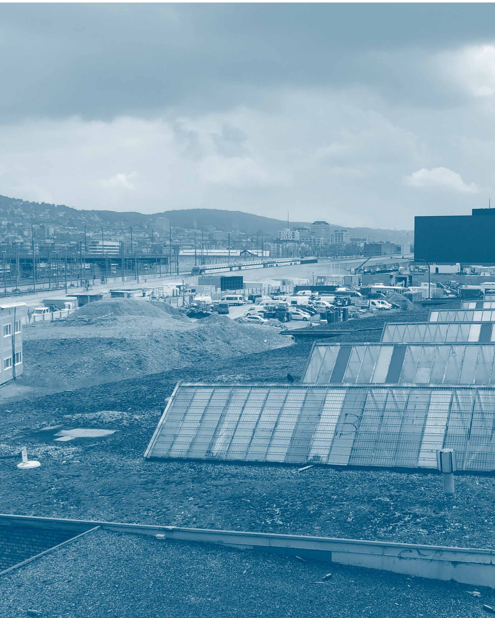
Baubereich II, Areal Polizei- und Justizzentrum (PJZ), Zürich
