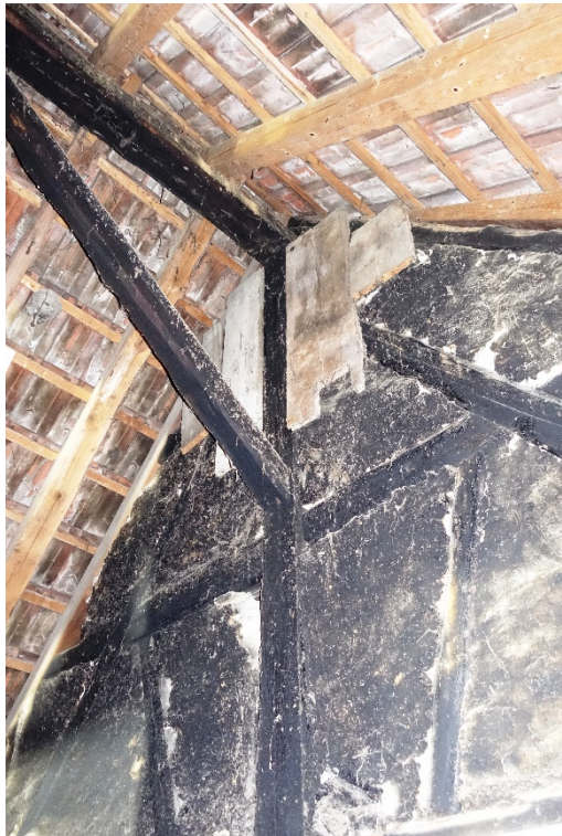
Ehem. Vielzweckbauernhaus, Wohnteil, rauchgeschwärzte, nordöstliche Giebelfassade, Ansicht von SW, 16.11.2016 (Bild Nr. D100560_26).
