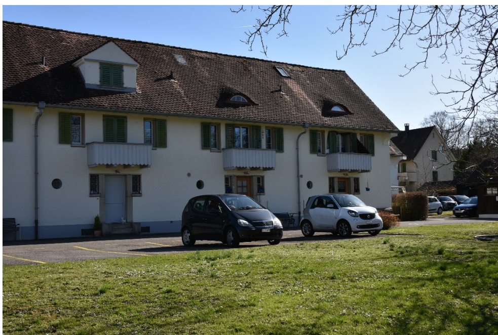
Kraftwerk Eglisau, Wohnkolonie für Angestellte, Reihenwohnhaus 3 (Vers. Nr. 01621), im Hintergrund Betriebsleiterwohnhaus (Vers. Nr. 01615), Ansicht von N, 13.03.2020 (Bild Nr. D100575_52).
