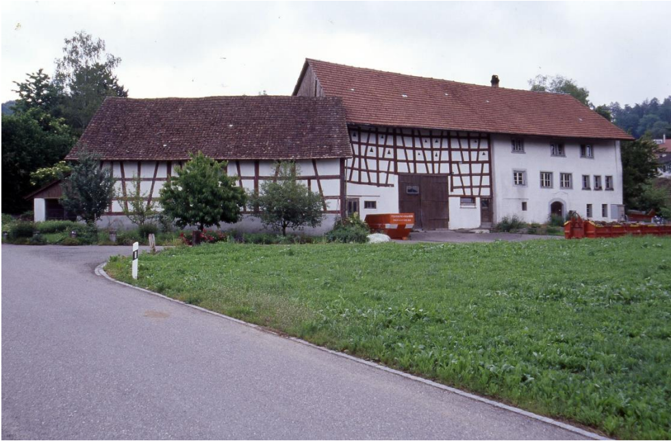
Hof Gstein, Doppelbauernhaus mit Trotte (Vers. Nr. 00110), Ansicht von SW, 28.05.2004, (Bild Nr. L49362_09).
