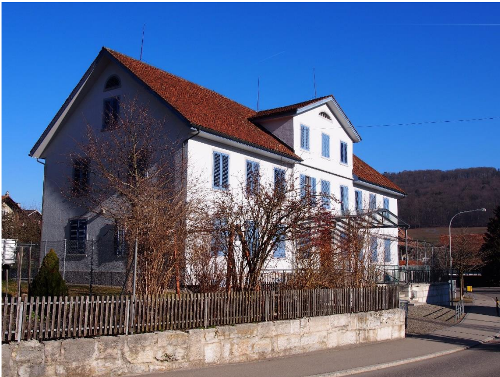
Primarschulhaus, Ansicht von SW, 18.02.2019 (Bild Nr. D100572_50).
