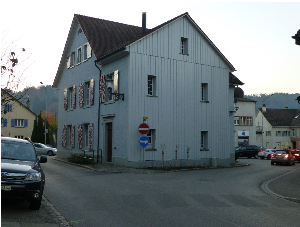
Ehem. Gemeinde- und Schulhaus, Ansicht von O, 31.10.2013 (Bild Nr. D100563_55).
