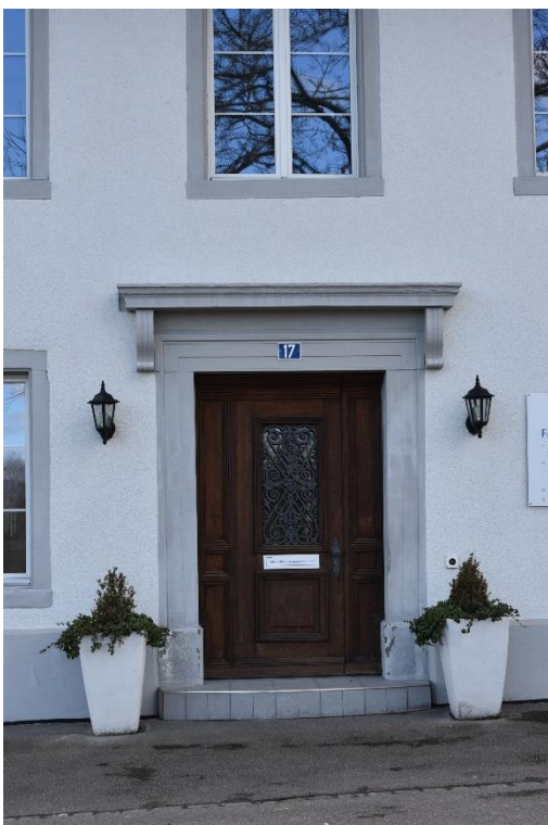
Schulhausensemble, altes Schulhaus (Vers. Nr. 00140), Haupteingang, Ansicht von NO, 11.03.2020 (Bild Nr. D100600_12).
