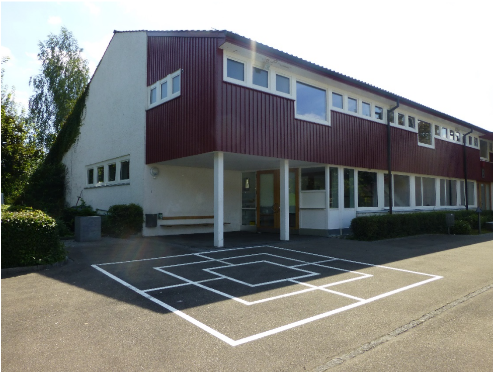
Schulanlage Schmittenwis, Trakt B (Vers. Nr. 00068), nördlicher Gebäudeteil mit Haupteingang, Ansicht von NW, 22.08.2014 (Bild Nr. D100570_53).
