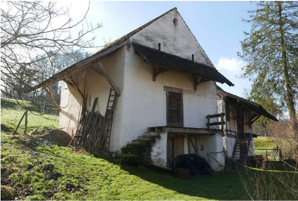
Speicherensemble, im Vordergrund Speicher «Utzing» (Vers. Nr. 00087), Ansicht von NO, 10.03.2017 (Bild Nr. D100570_72).
