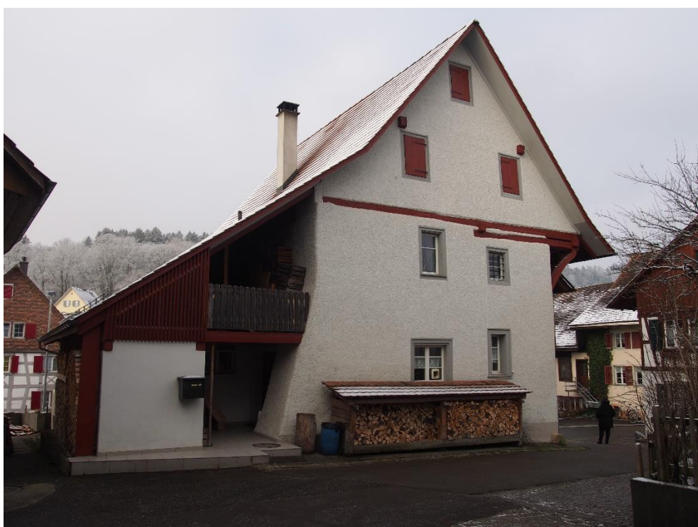
«Landvogthaus», ehem. Weinbauernhaus, Ansicht von NO, 01.02.2019 (Bild Nr. D101397_76).
