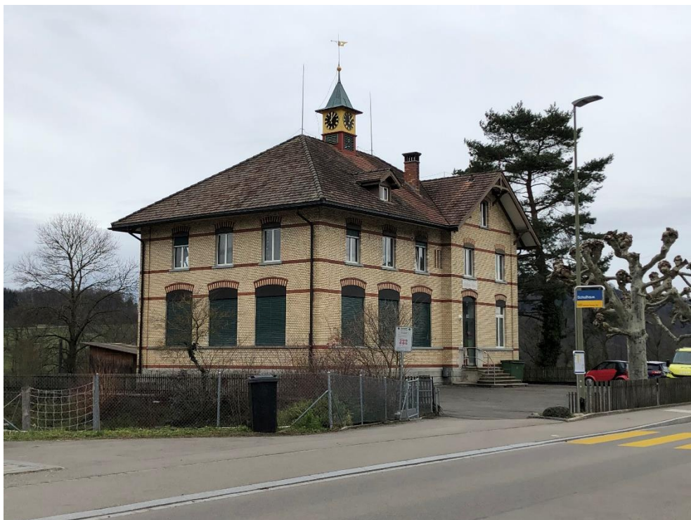
Ehem. Schulhaus Teufen, Ansicht von SO, 23.02.2020 (Bild Nr. D100566_80).
