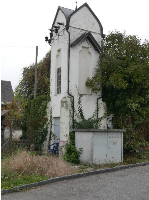
Transformatorstation Oberhasli, Ansicht von W, 31.10.2016 (Bild Nr. D100562_02).
