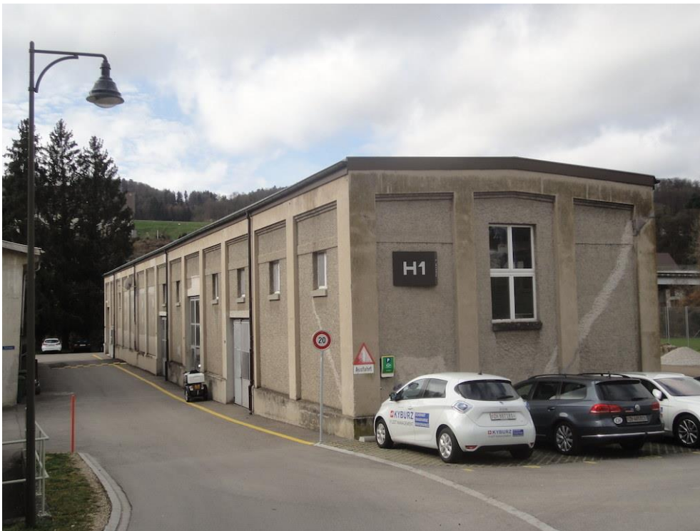
Ehem. Spinnerei Blumer, Fabrikanlage, Altes Baumwollmagazin (Vers. Nr. 00040), Ansicht von NO, 12.03.2020 (Bild Nr. D100681_48).
