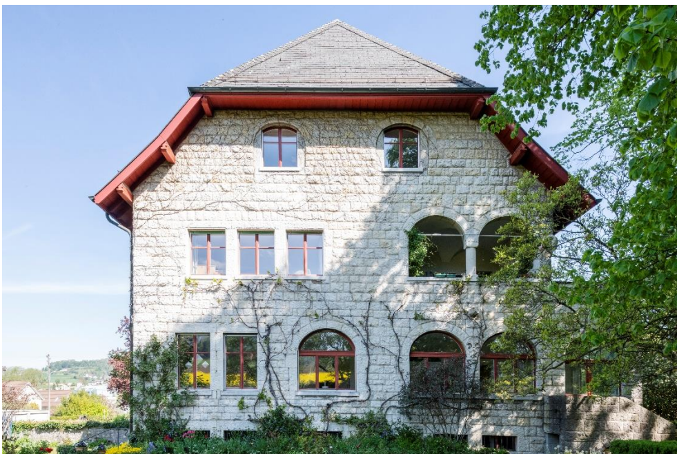
Villa Bucher-Guyer mit Gartenanlage, Südfassade, Ansicht von S, 24.04.2020 (Bild Nr. D101099_61).
