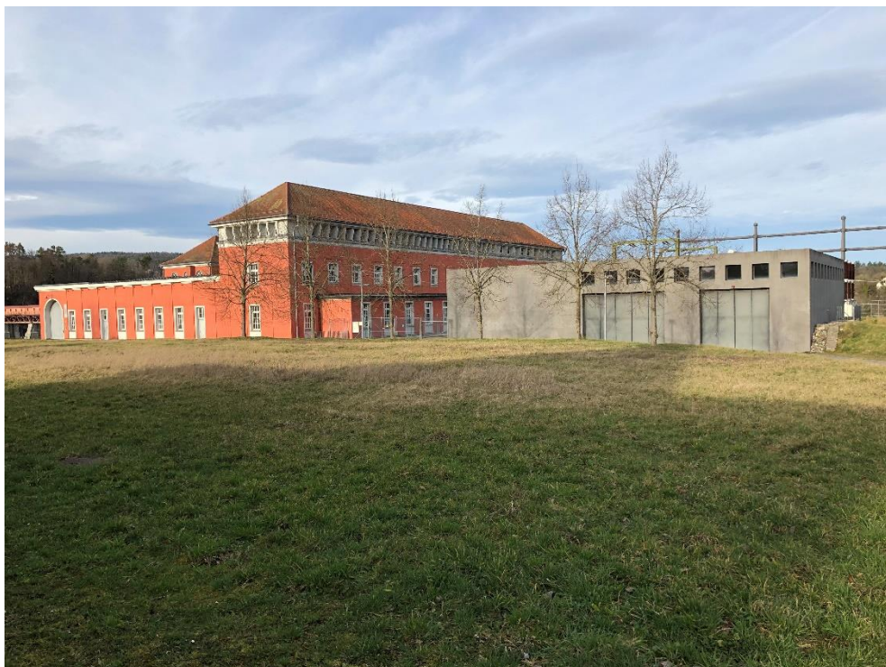
Kraftwerk Eglisau, Schaltheus (Vers. Nr. 01655) mit Unterwerk, Ansicht von W, 22.02.2020 (Bild Nr. D100567_20).
