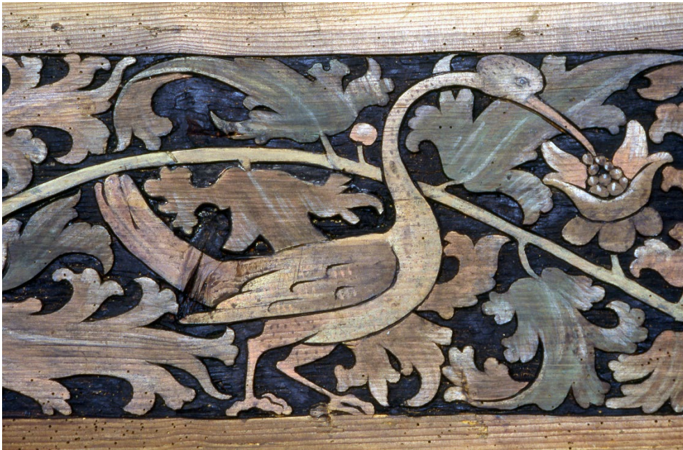
Ehem. Gemeinde- und Schulhaus, 1. OG, Decke mit spätgotischen Flachschnitzereien, Zustand 1994 (Bild Nr. L36359_22).
