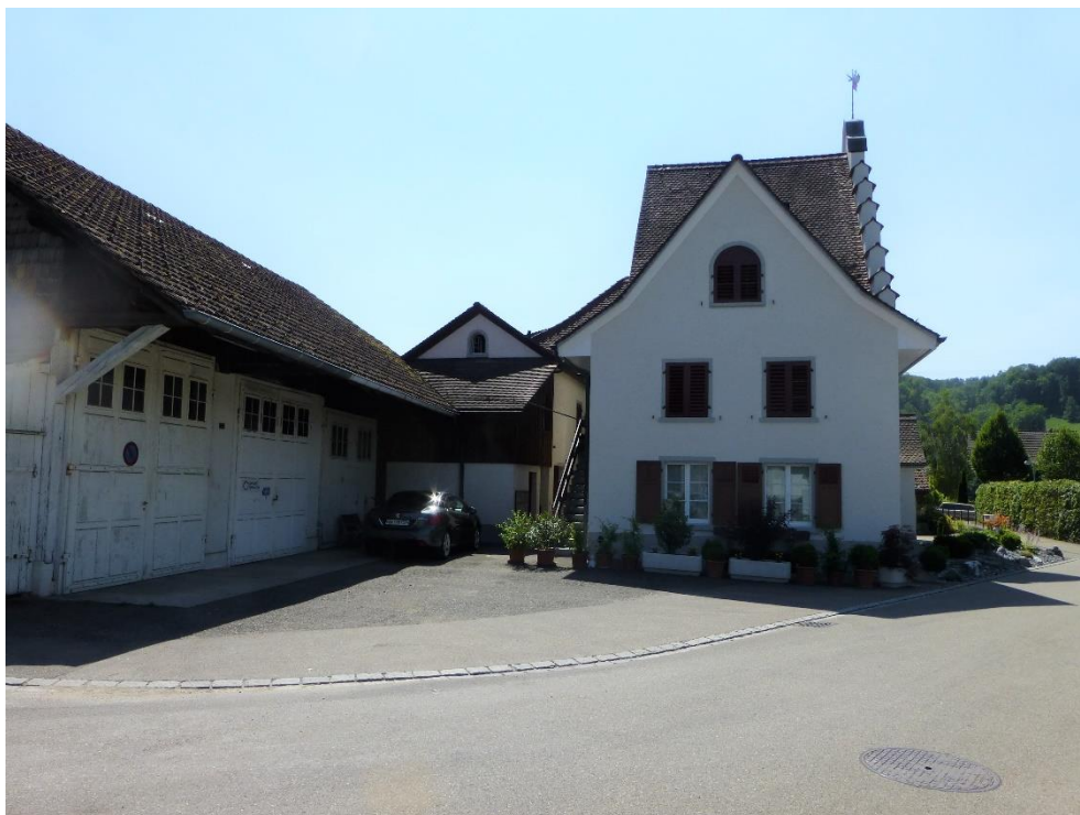
Wohn- und Geschäftshaus «Zum Staffelhof», Ansicht von O, 17.02.2014 (Bild Nr. D100563_23).
