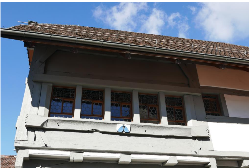
Sog. «Klingelehäus», Reihenfenster der Bohlenbretter-Stube, Ansicht von SO, 10.03.2017 (Bild Nr. D100576_23).
