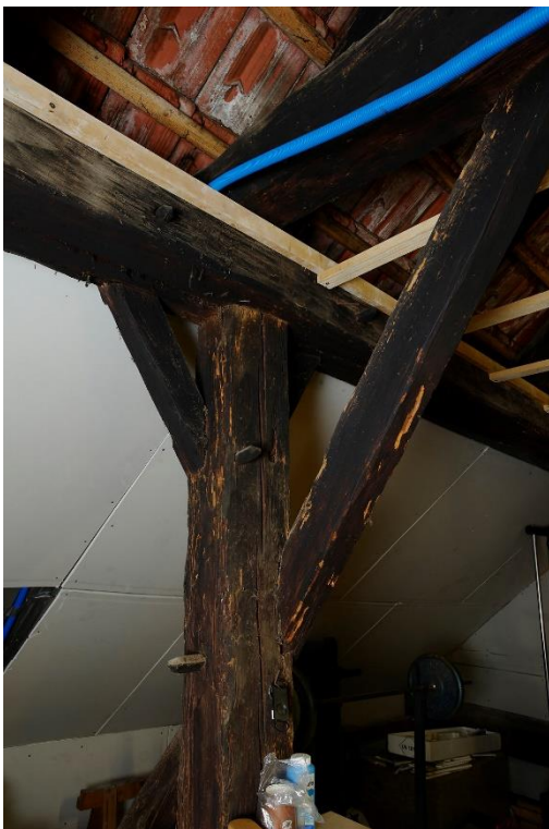
Ehem. Zehntenscheune, Hausteil NO (Vers. Nr. 01242), Wohnteil, Hochständer mit eingezäpften Kopfhölzern, Ansicht von W, 27.11.2015 (Bild Nr. D100587_40).
