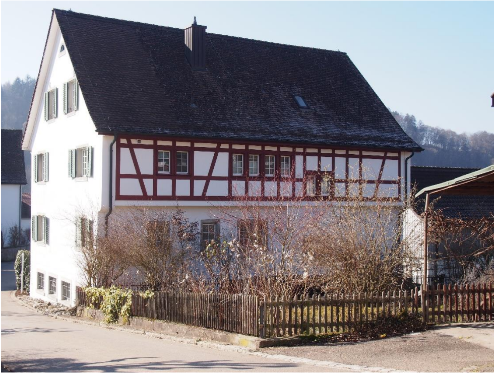
Ref. Pfarrhaus, Ansicht von NO, 15.02.2019 (Bild Nr. D101366_67).
