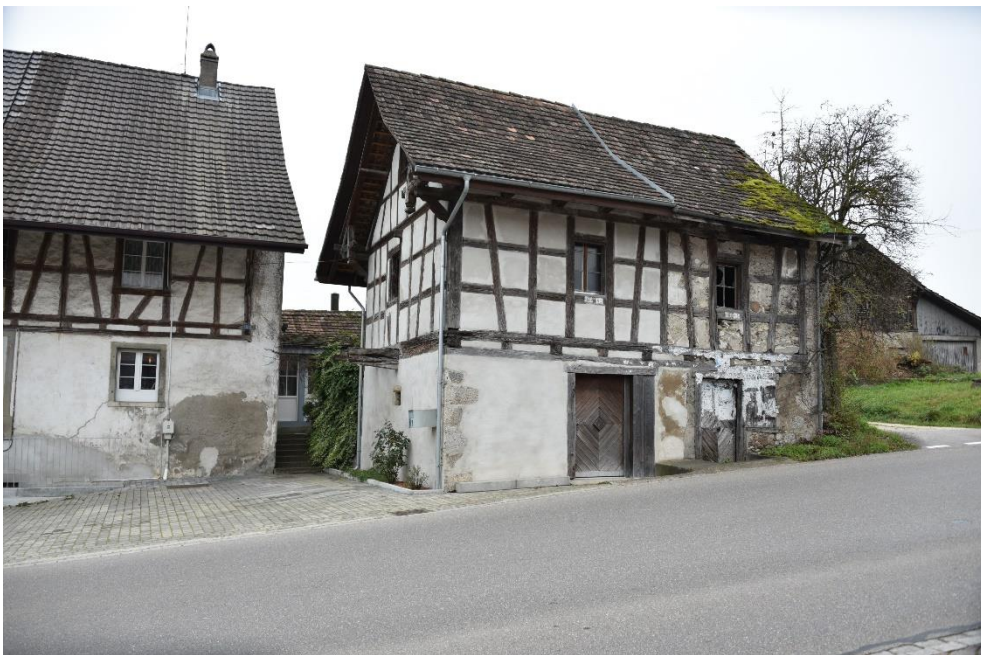
Speicher, Ansicht von NW, 25.11.2020 (Bild Nr. D100560_58).
