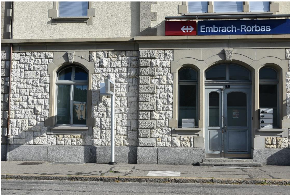
Bahnhof Embrach-Rorbas, Aufnahmegebäude (Vers. Nr. 01351), Ansicht von S, 24.08.2020 (Bild Nr. D100553_50).
