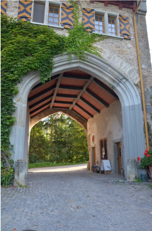
Schloss Teufen, Ostflügel (Vers. Nr. 00371), Durchfahrt mit Holzgewölbe, Ansicht von S, 12.08.2020 (Bild Nr. D100598_14).
