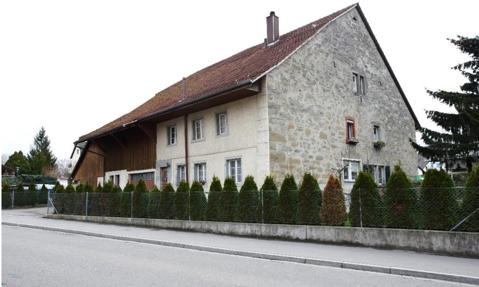
Ehem. Zehntenscheune, Hausteil NO (Vers. Nr. 01242), Giebelfassade aus Sandsteinquadern und Bruchsteinen, Ansicht von NW, 27.11.2015 (Bild Nr. D100587_37).
