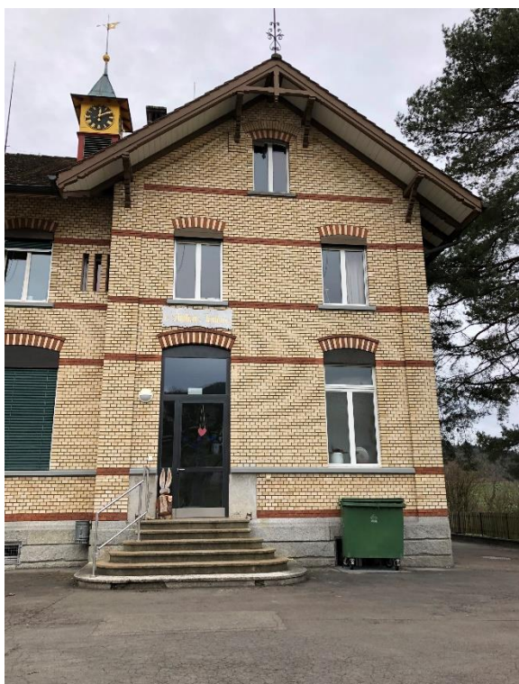
Ehem. Schulhaus Teufen, Nordostfassade mit Haupteingang, Ansicht von NO, 23.02.2020 (Bild Nr. D100566_81).
