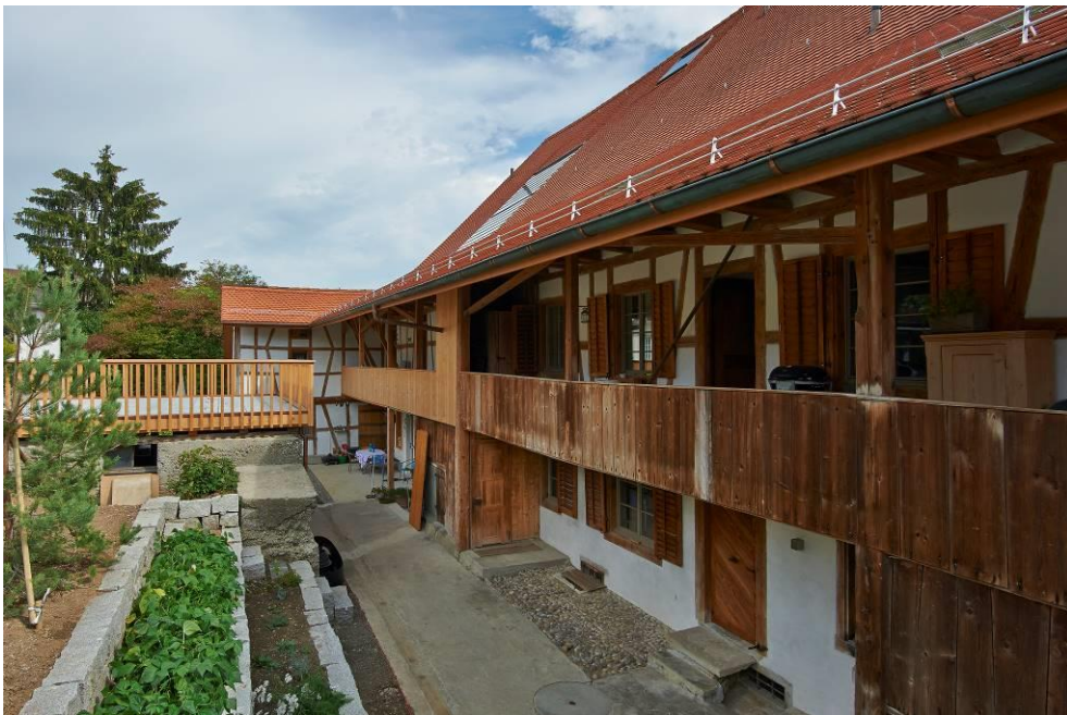
Vielweckbauernhaus, Ansicht von SW, 22.09.2018 (Bild Nr. D101791_62).
