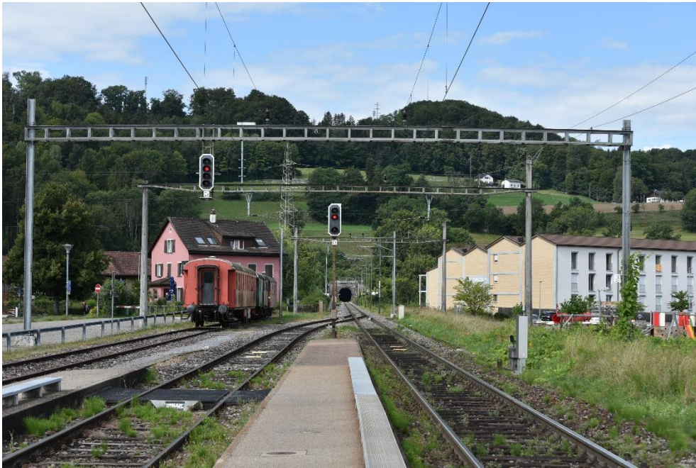
Bahnhof Embrach-Rorbas, Blick vom Bahnhof zum Tunnelportal Dettenberg Ost (068TUNNEL00001), Ansicht von O, 24.08.2020 (Bild Nr. D100553_53).
