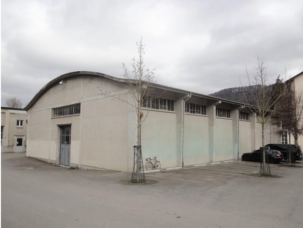
Ehem. Spinnerei Blumer, Fabrikanlage, Neues Baumwollmagazin (Vers. Nr. 00042), Ansicht von S, 12.03.2020 (Bild Nr. D100681_47).
