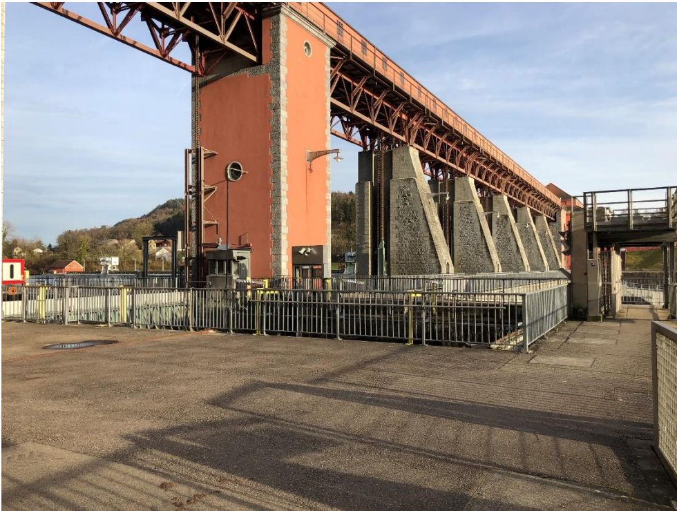
Kraftwerk Eglisau, Stauwehr (058STAUWEHR01656), Windwerkbrücke mit Wehrantrieb (Vers. Nr. 01558), Schiffsschleuse (058SCHLEUSE01656), Blick nach SO, 22.02.2020 (Bild Nr. D100567_30).
