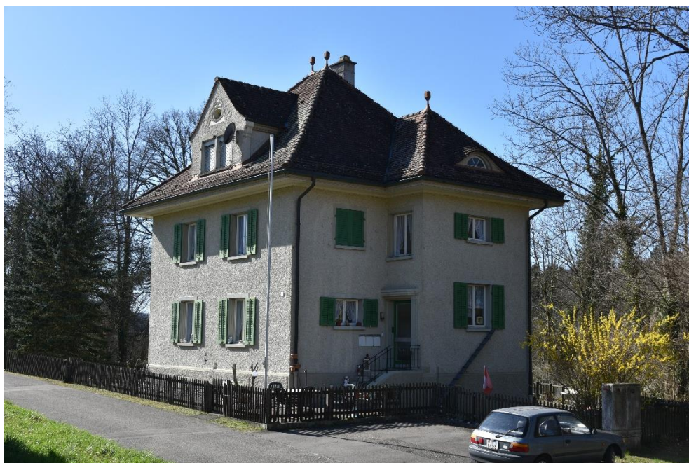
Ehem. Grenzwächterwohnhaus mit Holzschuppen, ehem. Grenzwächterwohnhaus (Vers. Nr. 01650), Ansicht von SO, 13.03.2020 (Bild Nr. D100575_29).
