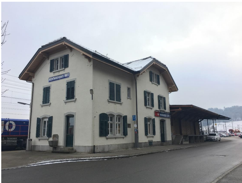
Bahnhof Hüntwangen-Wil, Aufnahmegebäude mit Güterschuppen, Ansicht von NW, 07.02.2019 (Bild Nr. D100573_86).
