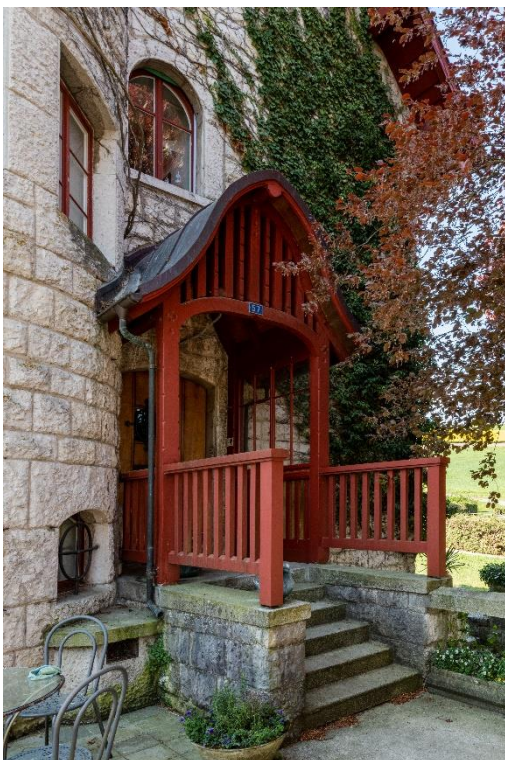
Villa Bucher-Guyer mit Gartenanlage, Nordfassade, Haupteingang mit geschwungenem Vordach, Ansicht von NO, 24.04.2020 (Bild Nr. D101099_55).
