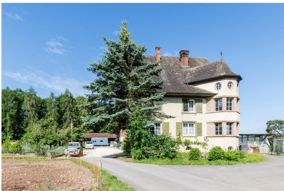
Aussiedlerhof «Rhihof», rechts im Vordergrund das Bauernwohnhaus (Vers. Nr. 01607), links im Hintergrund der Schopf (Vers. Nr. 01606), Ansicht von O, 28.05.2020 (Bild Nr. D100561_86).
