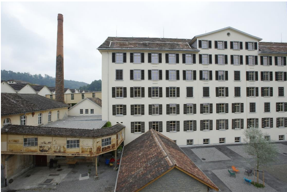
Ehem. Spinnerei Blumer, Fabrikanlage, in der Mitte die Spinnerei (057SPINNEREI00027), links die Passerelle Nordwest (057PASSNW00027), dahinter das Vorwerk II (057VORWII00027), weiter hinten die Spinnereizentrale mit Hochkamin (057SPINNZEN00027), die Passerelle Südost (057PASSO00027), ganz links die Weberei (057WEBEREI00027), Ansicht von NW, 10.09.2014 (Bild Nr. D100836_60)
