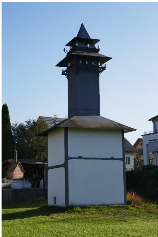
Transformatorstation «Bächli-Unterdorf, Ansicht von W, 06.12.2019 (Bild Nr. D100564_72).
