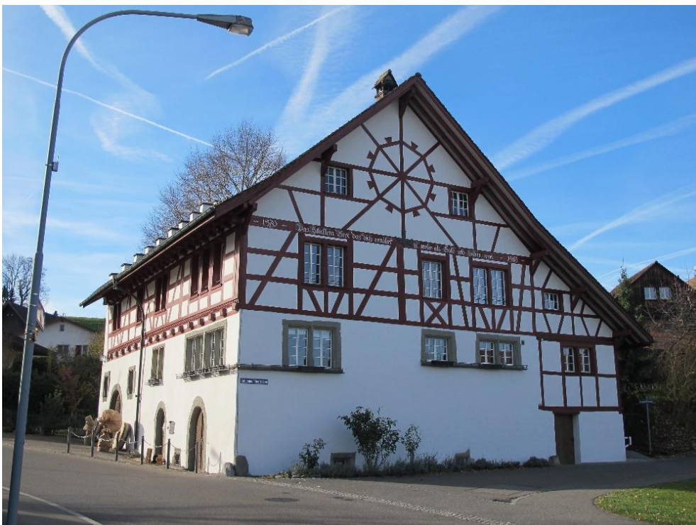
Geigenmühle, Mühlegebäude (Vers. Nr. 00406), Ansicht von NO, 24.11.2017 (Bild Nr. D100596_22).
