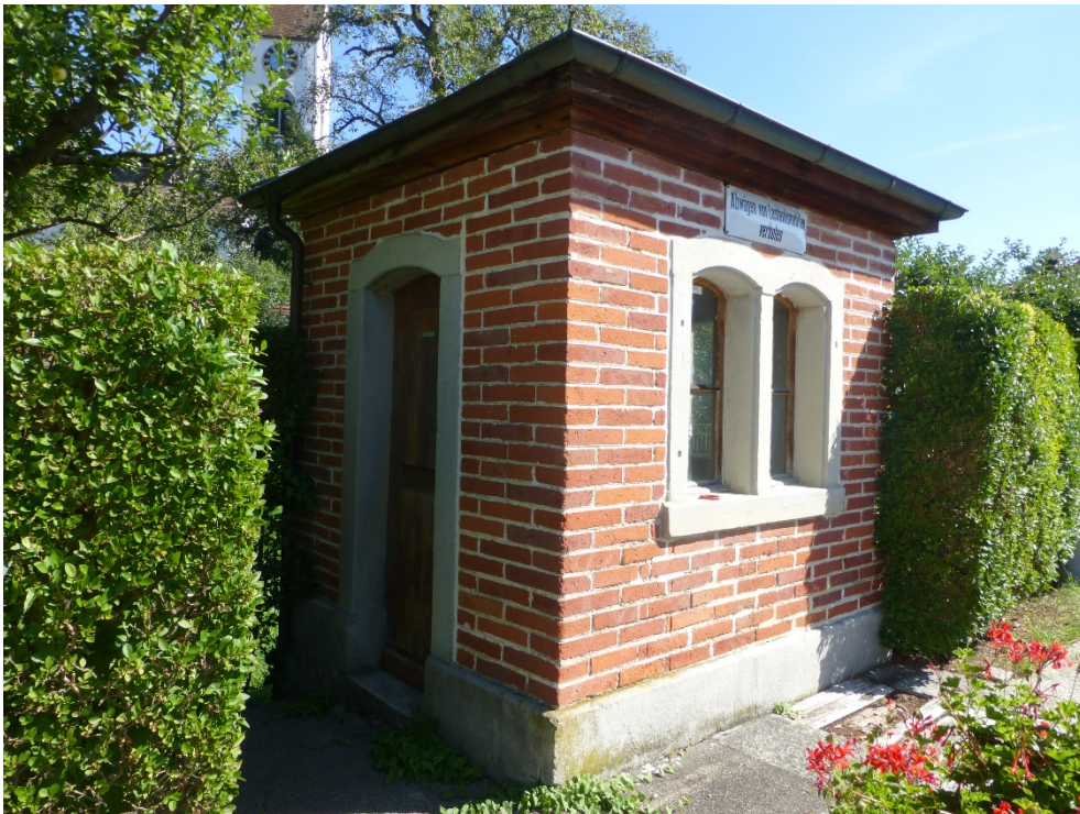
Brückenwaage, Ansicht von SW, 27.08.2015 (Bild Nr. D100576_06).
