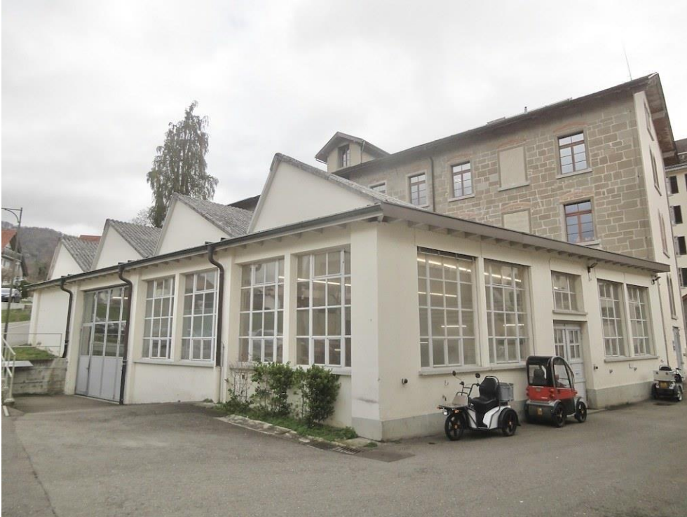
Ehem. Spinnerei Blumer, Fabrikanlage, Shedanbau (057SHED00027), dahinter Vorwerk I (057VORWI00027), Ansicht von SW, 12.03.2020 (Bild Nr. D100681_37).
