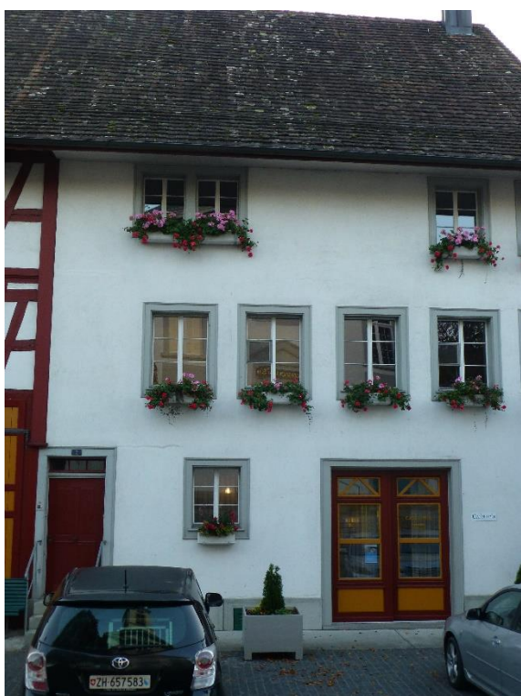
Ref. Kirchgemeindehaus, Ehem. Wohnteil, Ansicht von O, 17.02.2014 (Bild Nr. D100563_14).
