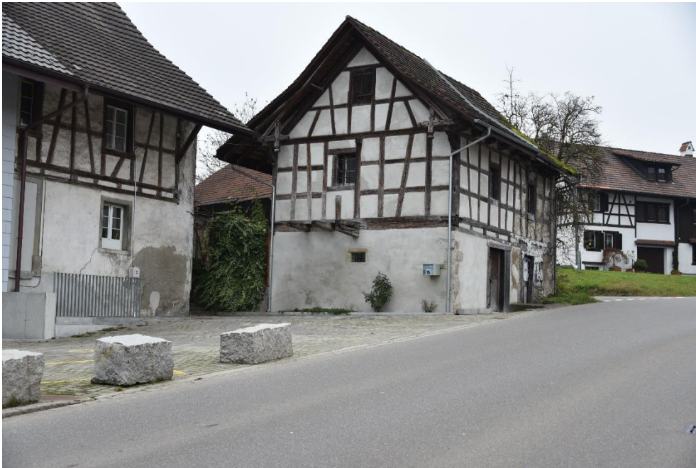
Speicher, Ansicht von NO, 25.11.2020 (Bild Nr. D100560_57).
