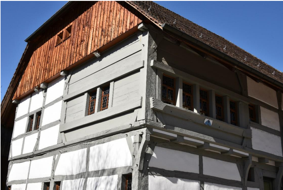
Sog. «Klingelehäus», Bohlenbretter-Stube im OG, Ansicht von S, 13.03.2020 (Bild Nr. D100576_30).
