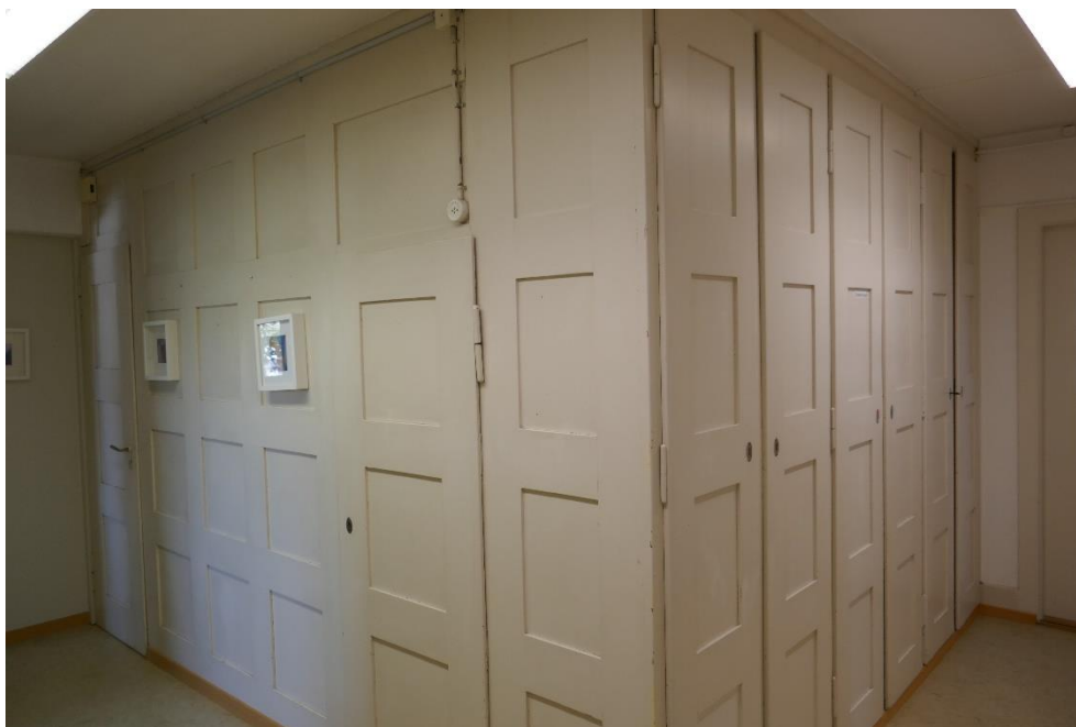
Schulhausensemble, Primarschulhaus (Vers. Nr. 00138), Einbauschränke vor der ehem. Abwartswohnung im OG, 17.09.2019 (Bild Nr. D100600_56).
