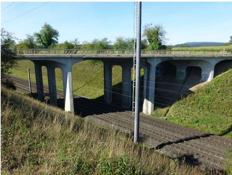
Bahnüberführung, Ansicht von NO, 28.08.2015 (Bild Nr. D100576_12).
