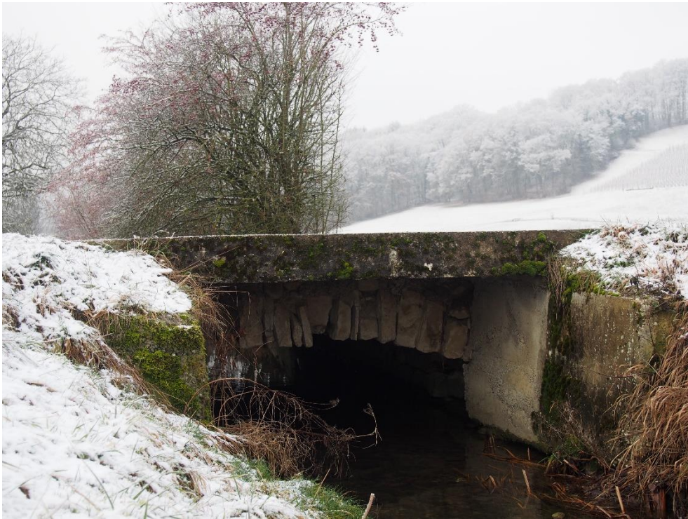
Brückenensemble am ehem. Kirchweg, Brücke West (061BRUECKE00001), Ansicht von O, 04.02.2019 (Bild Nr. D101096_74).
