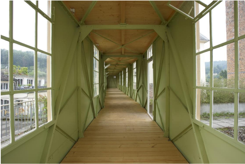
Ehem. Spinnerei Blumer, Fabrikanlage, Inneres Passerelle Südost (057PASSO00027), Blick nach SW, 10.09.2014 (Bild Nr. D100836_54).
