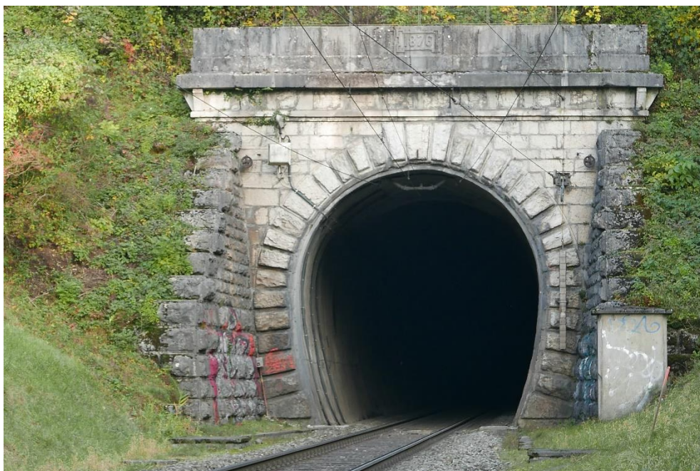
Bahnhof Embrach-Rorbas, Tunnelportal Dettenberg West mit Bauvollendungsjahr «1876», Gemeindegebiet Bülach (053TUNNEL00001), Ansicht von W, 31.10.2016 (Bild Nr. D100553_64).
