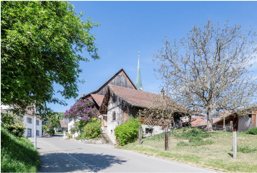
«Untervogthaus» mit Speicher, Ansicht von SO, 24.04.2020 (Bild Nr. D101099_05).
