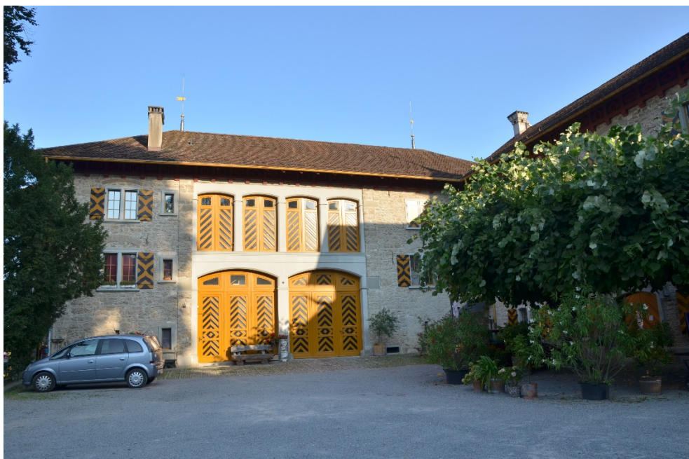
Schloss Teufen, Südflügel (Vers. Nr. 00372), Ostfassade mit Wohn- und Scheunenteil, Ansicht von O, 12.08.2020 (Bild Nr. D100598_10).
