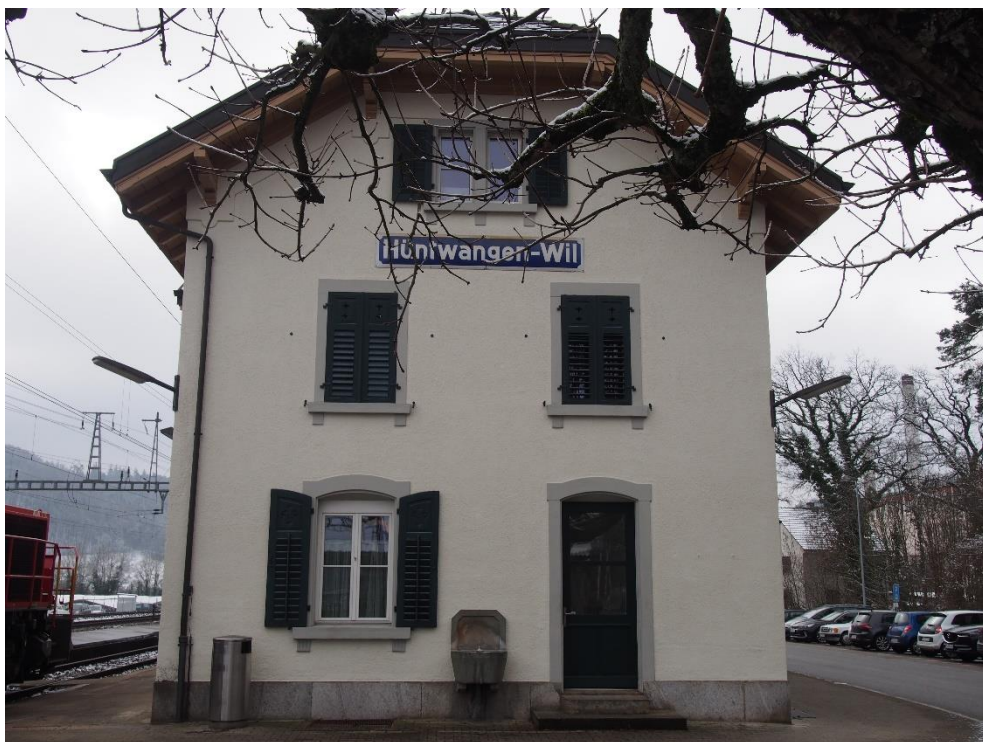
Bahnhof Hüntwangen-Wil, Aufnahmegebäude, Ansicht von NO, 07.02.2019 (Bild Nr. D100573_87).
