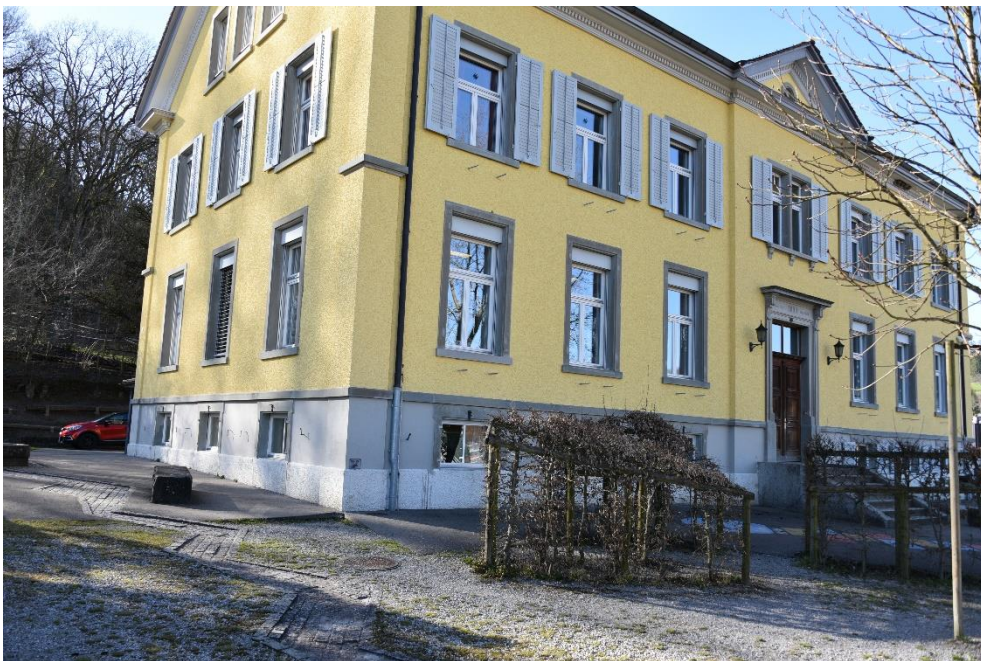
Primarschulhaus, Ansicht von SO, 13.03.2020 (Bild Nr. D100573_77).
