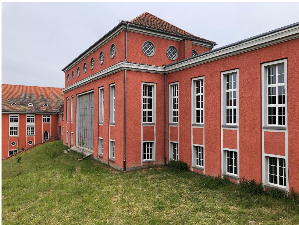
Kraftwerk Eglisau, Schaltheis (Vers. Nr. 01655) mit Bremsberg, Ansicht von W, 18.05.2019 (Bild Nr. D100567_17).
