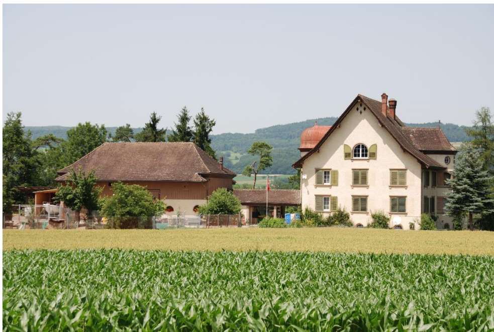
Aussiedlerhof «Rhihof», rechts das Bauernwohnhaus (Vers. Nr. 01607), links das Ökonomegebaude (058OEKO01607), Ansicht von S, 29.06.2012 (Bild Nr. D100069_39).
