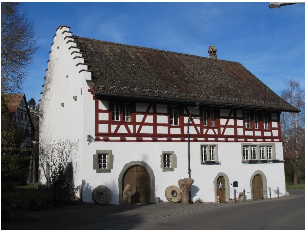
Geigenmühle, Mühlegebäude (Vers. Nr. 00406), Ansicht von SO, 24.11.2017 (Bild Nr. D100596_19).
