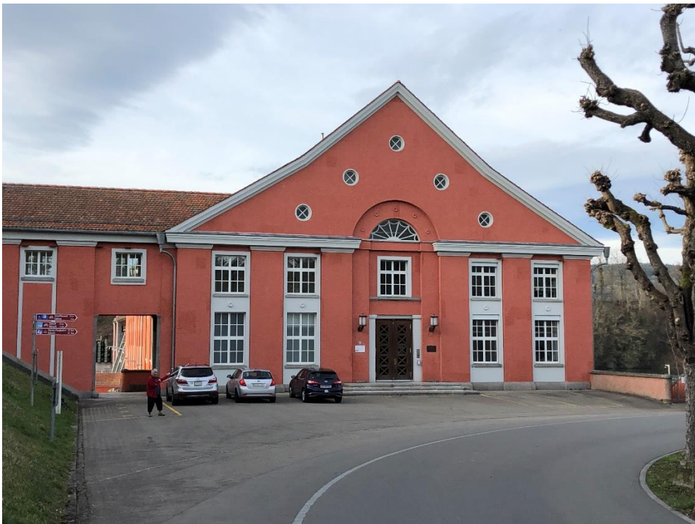
Kraftwerk Eglisau, Maschinenhaus (Vers. Nr. 01656), sog. Maschinenhauskopf mit Haupteingang, Ansicht von SO, 22.02.2020 (Bild Nr. D100567_13).
