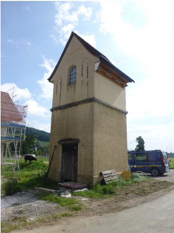
Transformatorstation «Dorf», Ansicht von W, 19.08.2014 (Bild Nr. D100570_03).
