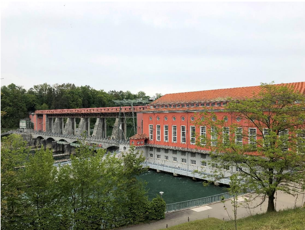
Kraftwerk Eglisau, Stauwehr (058STAUWEHR01656), Windwerkbrücke mit Wehrantrieb (Vers. Nr. 01658) und Maschinenhaus (Vers. Nr. 01656), Ansicht von S, 18.05.2019 (Bild Nr. D100567_02).
