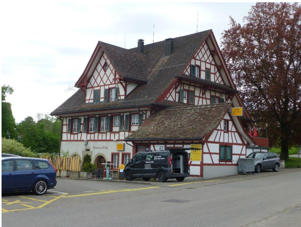
Ehem. Murzlenmühle, Ansicht von NW, 19.02.2019 (Bild Nr. D100596_28).
