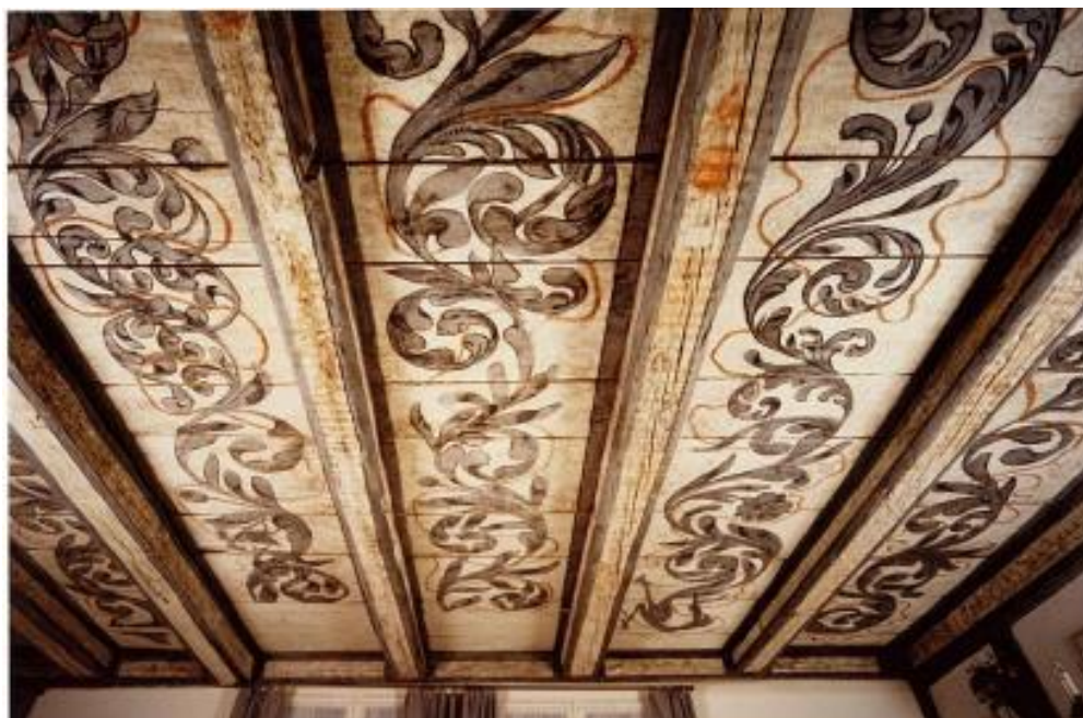
Gasthof «Zum Löwen», Holzbalkendecke mit Grisaillemalerei im 2. OG, 01.02.1987 (Bild Nr. D100565_46).
