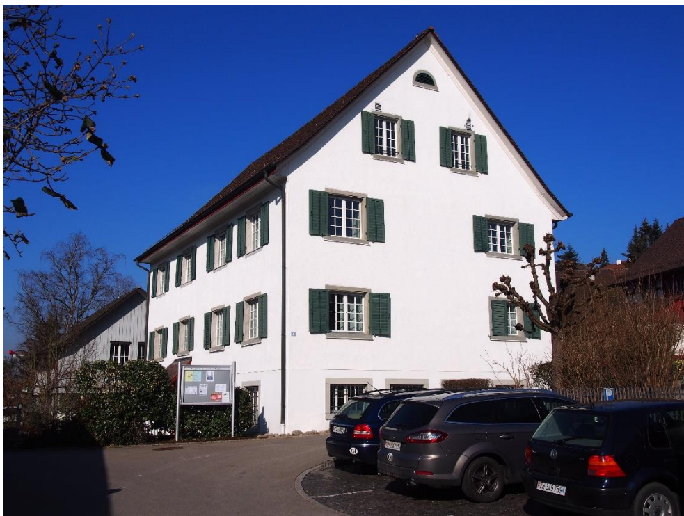
Ref. Pfarrhaus, Ansicht von SO, 15.02.2019 (Bild Nr. D101366_65).
