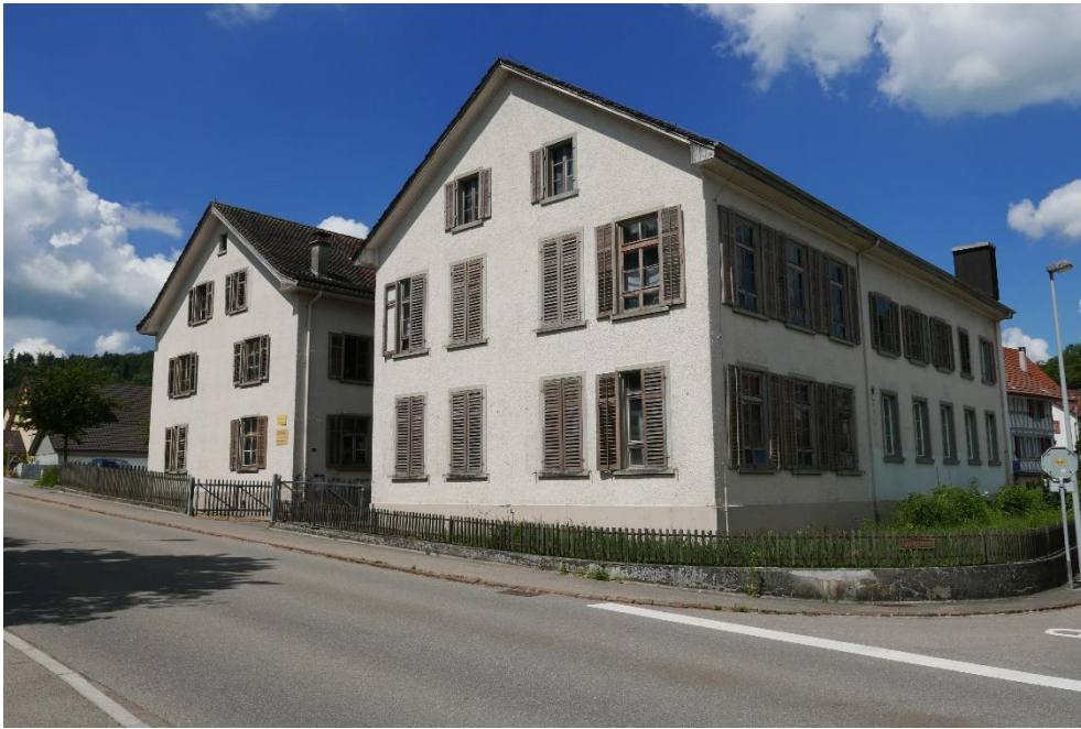
Ehem. Hutfabrik Ritz, Ansicht von S, 06.06.2016 (Bild Nr. D100573_26).
