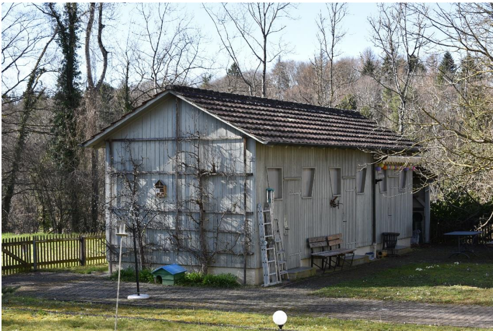
Ehem. Grenzwächterwohnhaus mit Holzschuppen, Holzschuppen (Vers. Nr. 01649), Ansicht von SO, 13.03.2020 (Bild Nr. D100575_31).
