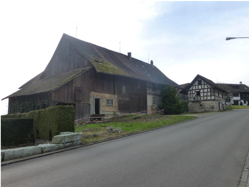
Speicher, Ansicht von NO, 16.01.2015 (Bild Nr. D100560_54).
