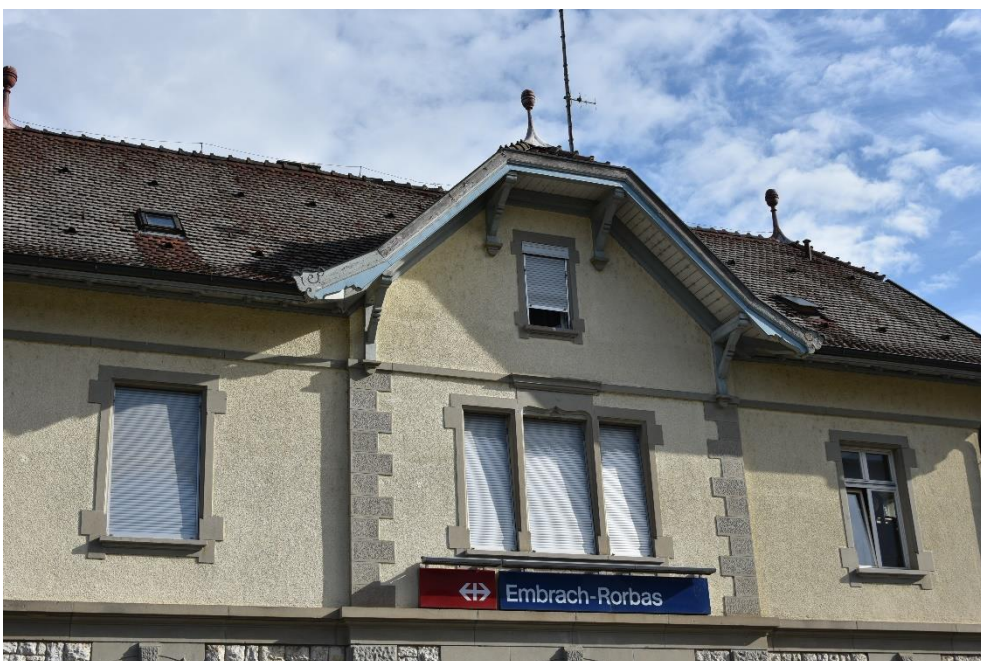
Bahnhof Embrach-Rorbas, Aufnahmegebäude (Vers. Nr. 01351), Ansicht von S, 24.08.2020 (Bild Nr. D100553_51).
