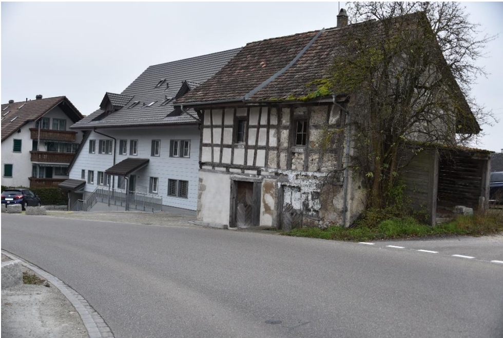
Speicher, Ansicht von NW, 25.11.2020 (Bild Nr. D100560_62).
