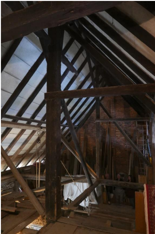
Ehem. Kleinbauernhaus, Dachraum mit Hochstudkonstruktion, Blick an die nordwestliche Giebelwand, 16.11.2016 (Bild Nr. D100560_36).
