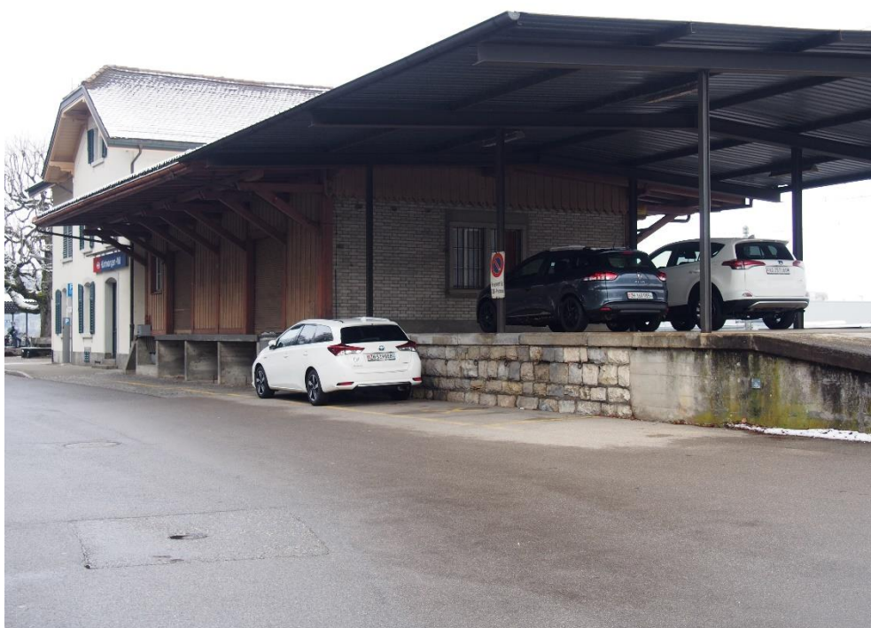
Bahnhof Hüntwangen-Wil, Ansicht von SW, 07.02.2019 (Bild Nr. D100573_88).
