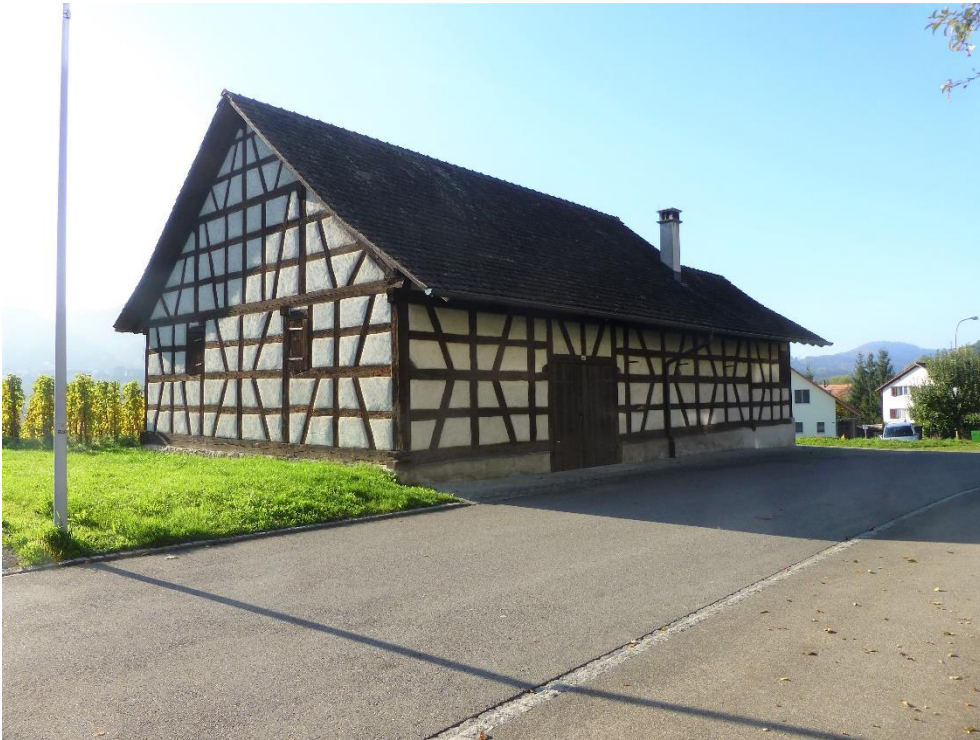
Ehem. Trotte, Ansicht von SO, 24.10.2013 (Bild Nr. D100566_01).
