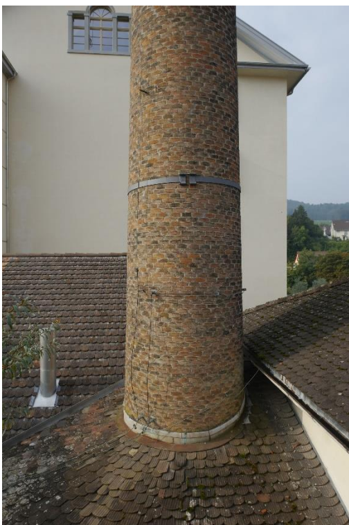
Ehem. Spinnerei Blumer, Fabrikanlage, Spinnereizentrale mit Hochkamin (057SPINNZEN00027), Ansicht von S, 10.09.2014 (Bild Nr. D100836_28).
