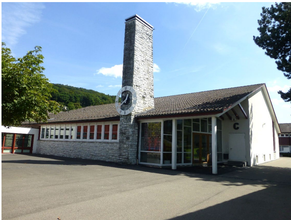
Schulanlage Schmittenwis, Trakt C / Turnhalle (Vers. Nr. 00217), Ansicht von W, 22.08.2014 (Bild Nr. D100570_59).
