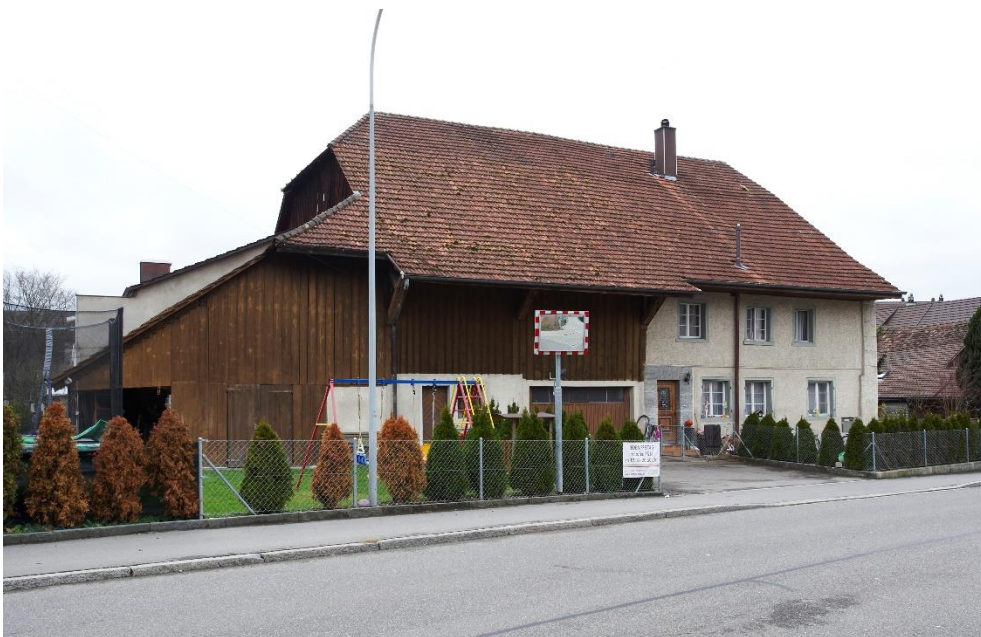
Ehem. Zehntenscheune, Hausteil NO (Vers. Nr. 01242) mit gut erkennbarer Aufgliederung Wohn- und Ökonomieteil, Ansicht von NO, 27.11.2015 (Bild Nr. D100587_21).
