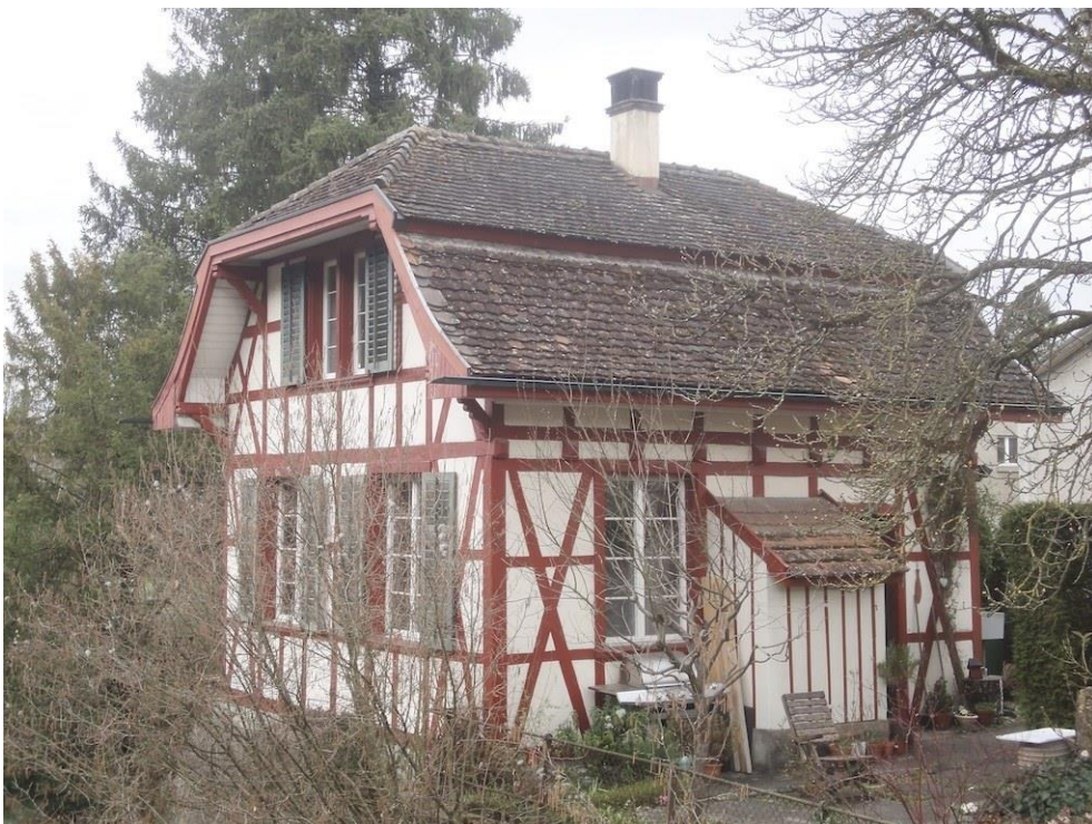
Ehem. Spinnerei Blumer, Fabrikanlage, Turbinenhaus (Vers. Nr. 00041), Ansicht von SO, 12.03.2020 (Bild Nr. D100681_46).
