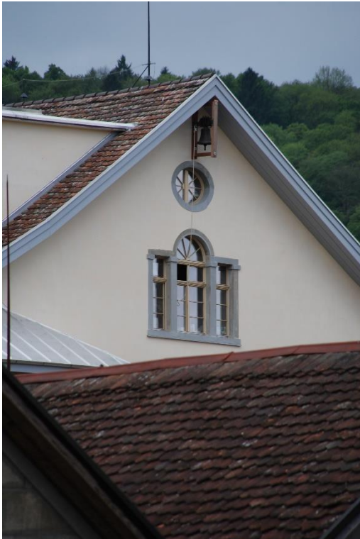
Ehem. Spinnerei Blumer, Fabrikanlage, Spinnerei (057SPINNEREI00027), Giebeldreieck, Fenster mit Palladio-Motiv, darüber Rundfenster und Fabrikglocke, Ansicht von NO, 09.05.2014 (Bild Nr. D100828_26).
