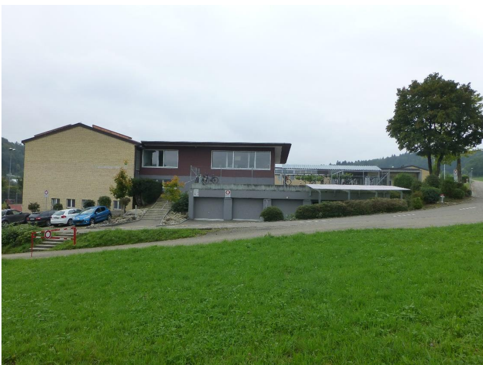
Schulanlage Im Gsteig, Turnhalle (063TURNHALLE00201), Schulzimmertrakt Birch (063ANBAU00201), Ansicht von N, 01.10.2013 (Bild Nr. D100554_22).
