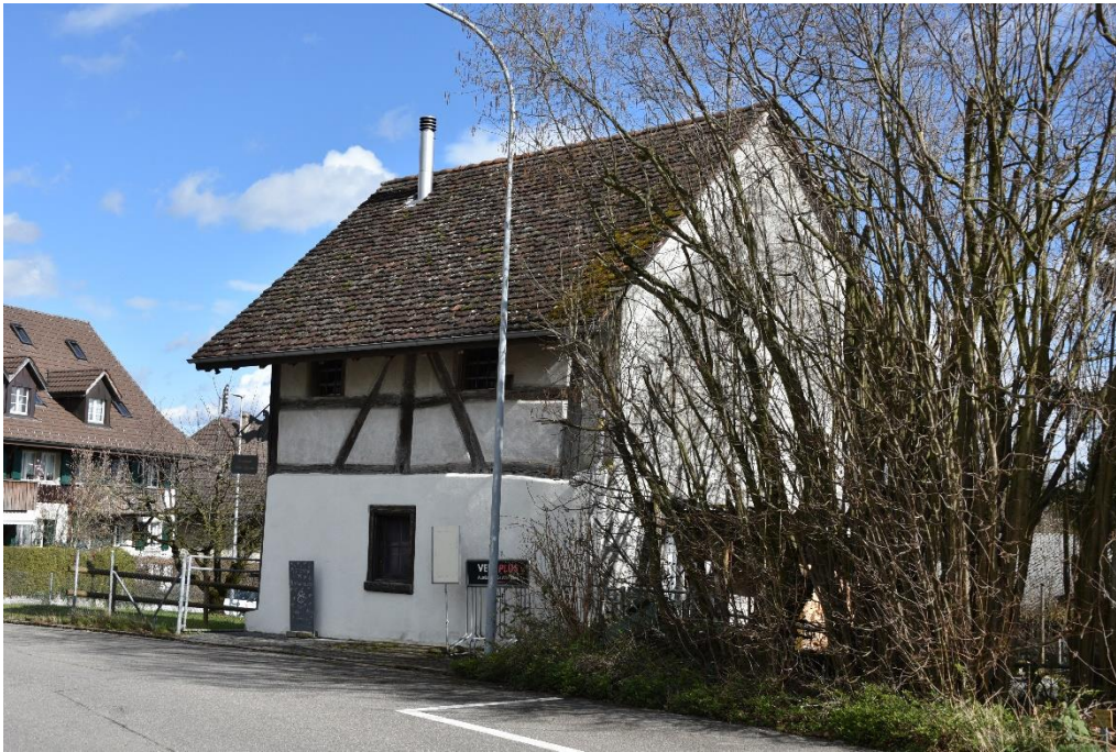
Speicher, Ansicht von SW, 11.03.2020 (Bild Nr. D100571_61).
