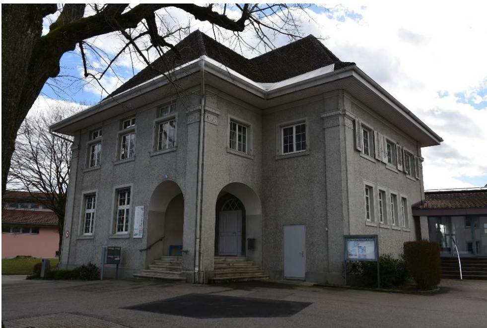
Schulhausensemble, Primarschulhaus (Vers. Nr. 00138), Ansicht von N, 11.03.2020 (Bild Nr. D100600_06).
