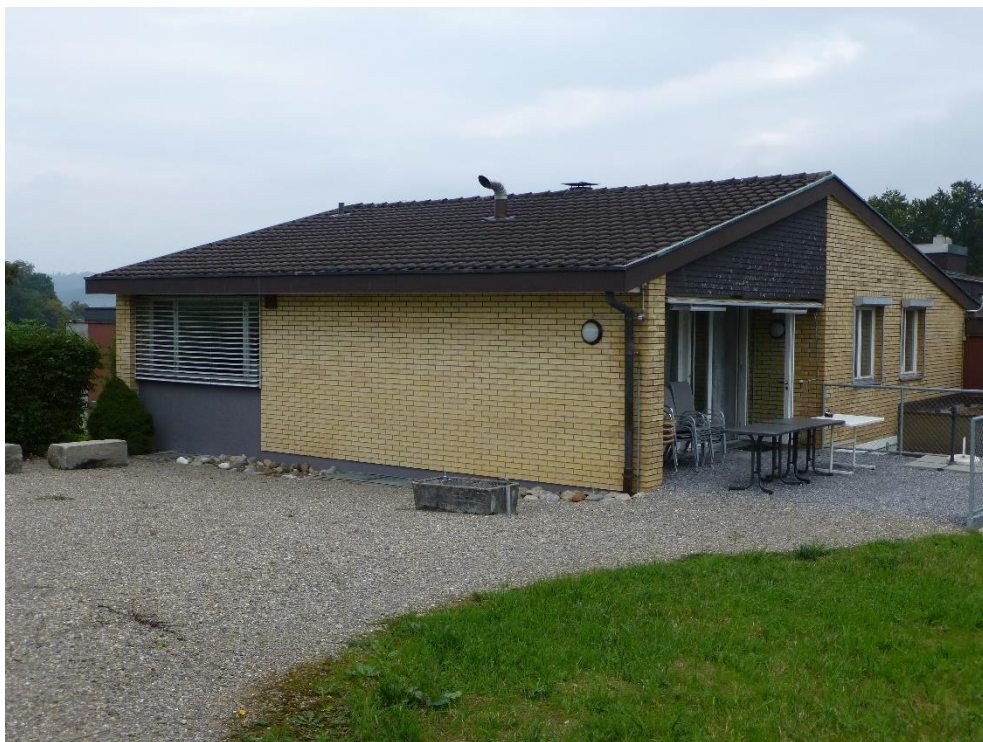
Schulanlage Im Gsteig, Abwartwohnhaus (063BEI00201), Ansicht von SW, 01.10.2013 (Bild Nr. D100554_02).
