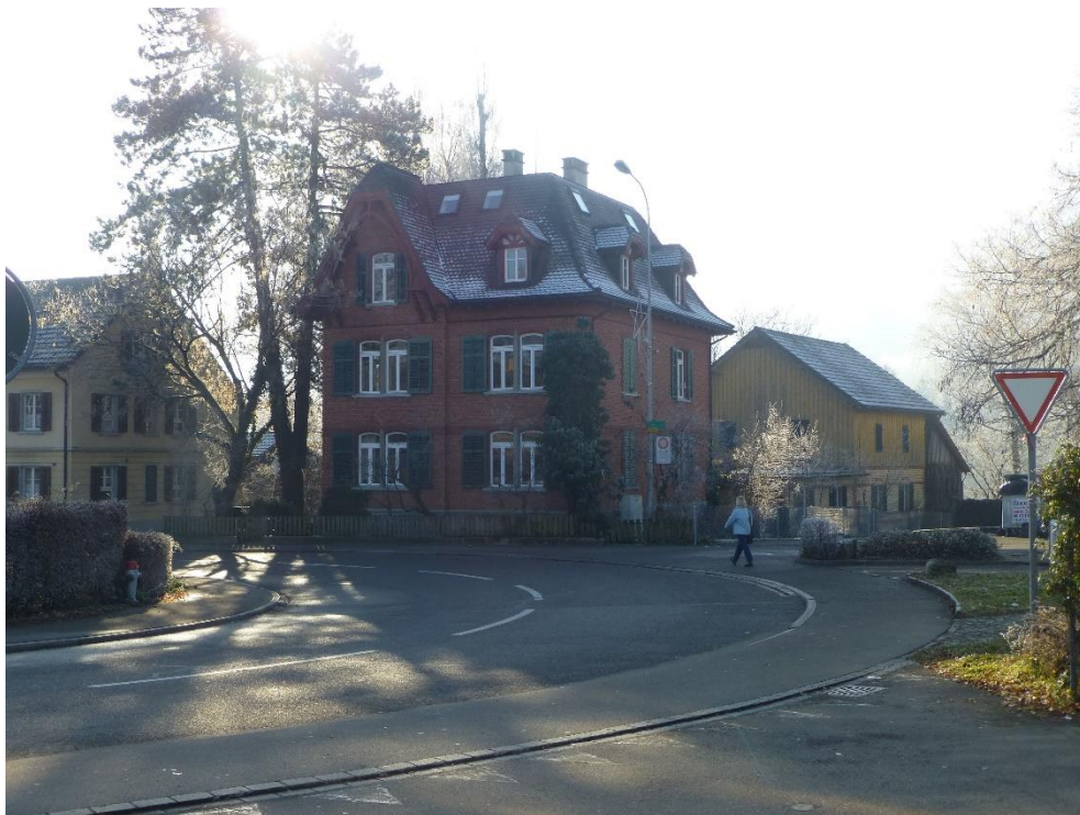
Wohnhaus Steiner mit Nebengebäude, Ansicht von NO, 17.12.2013 (Bild Nr. D100563_84).
