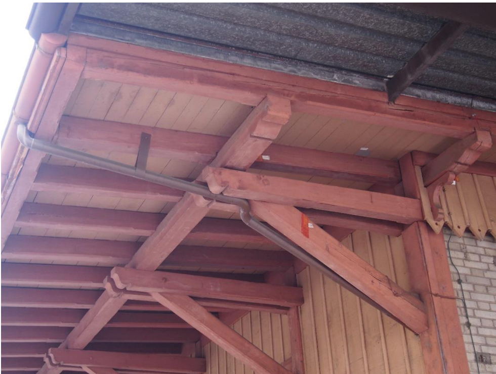
Bahnhof Hüntwangen-Wil, Güterschuppen, Ansicht von SW, 07.02.2019 (Bild Nr. D100573_92).
