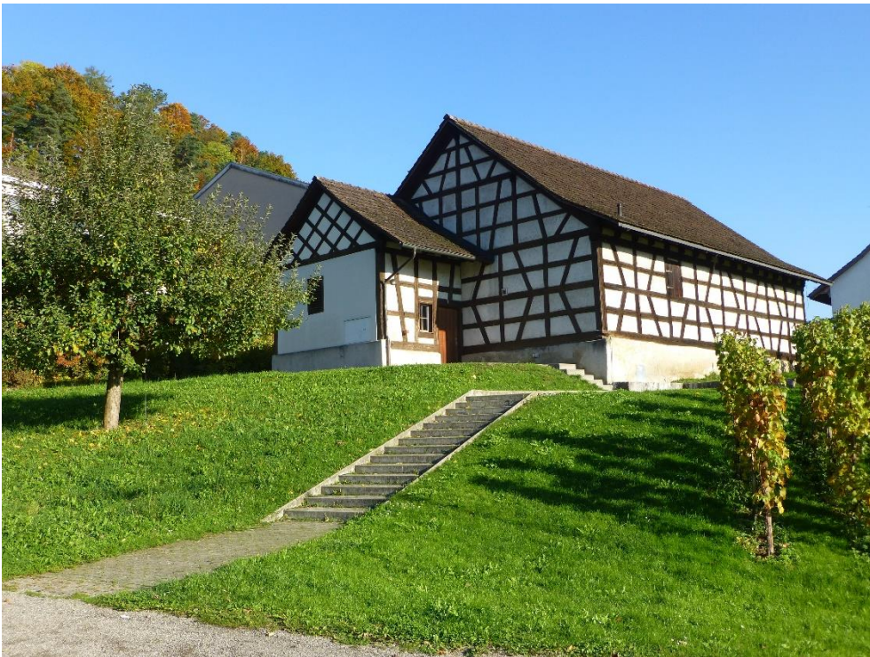
Ehem. Trotte, ehem. «Trottstübli» mit Eingang in die Trotte, Ansicht von SW, 24.10.2013 (Bild Nr. D100566_04).
