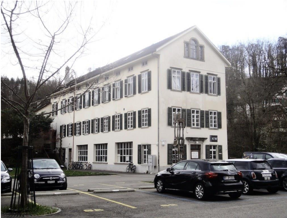
Ehem. Spinnerei Blumer, Fabrikanlage, Wohn- und Werkstattgebäude mit Schmiede (Vers. Nr. 00019), Ansicht von NW, 12.03.2020 (Bild Nr. D100681_33).
