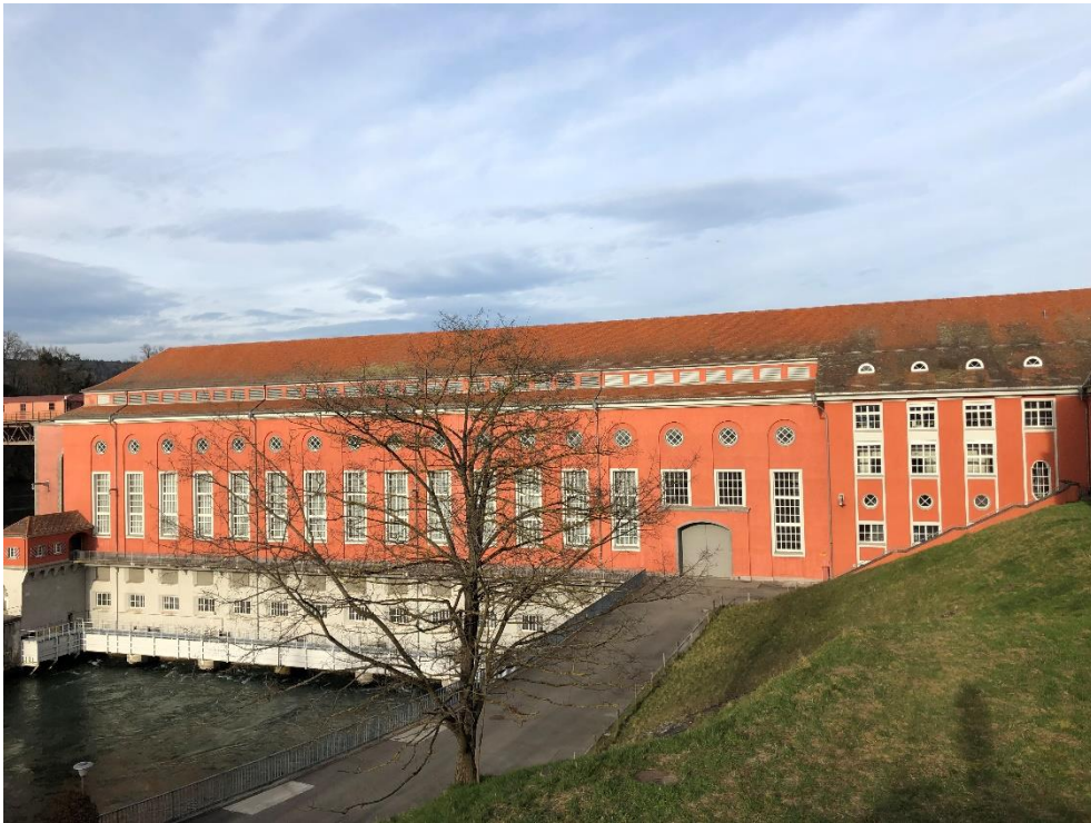
Kraftwerk Eglisau, Maschinenhaus (Vers. Nr. 01656), rechts sog. Maschinenhauskopf, Ansicht von SW, 22.02.2020 (Bild Nr. D100567_12).
