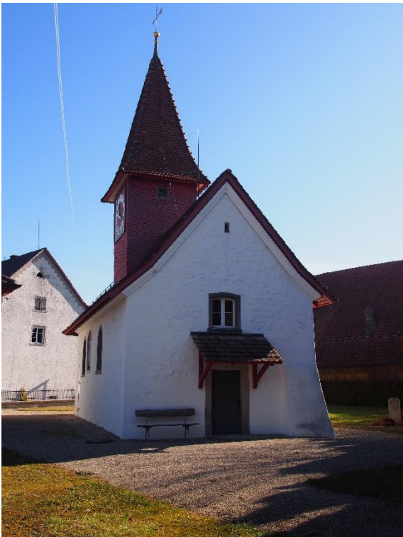
Ref. Filialkirche, Ansicht von NW, 01.03.2019 (Bild Nr. D101366_12).
