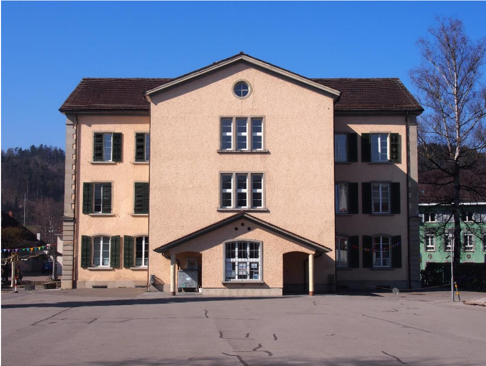
Schulhaus Dorf, Ansicht von O, 22.03.2019 (Bild Nr. D101367_27).
