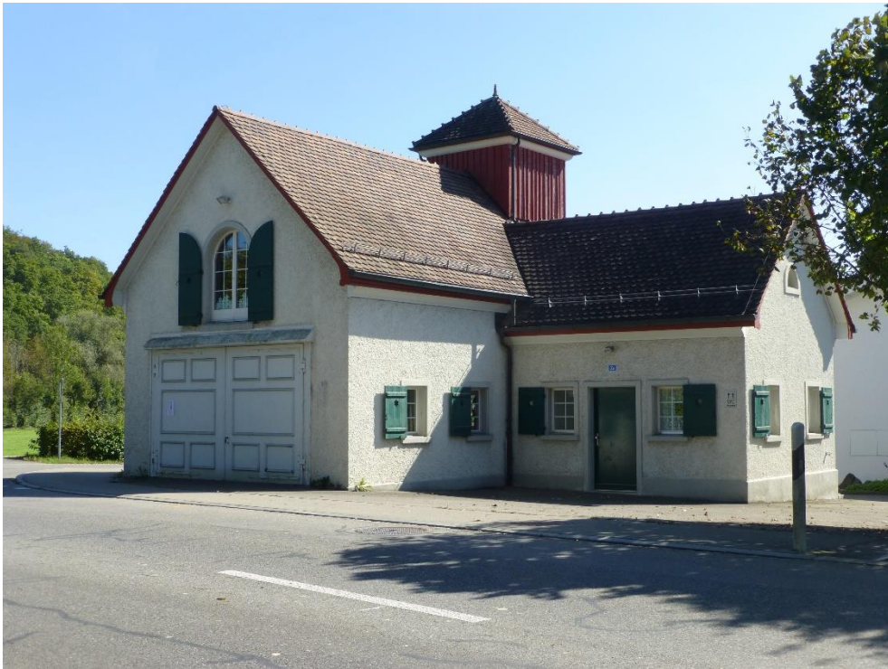
Ehem. Feuerwehrgeräte lokal mit Schlachthausanbau, Ansicht von NW, 23.09.2014 (Bild Nr. D100568_21).
