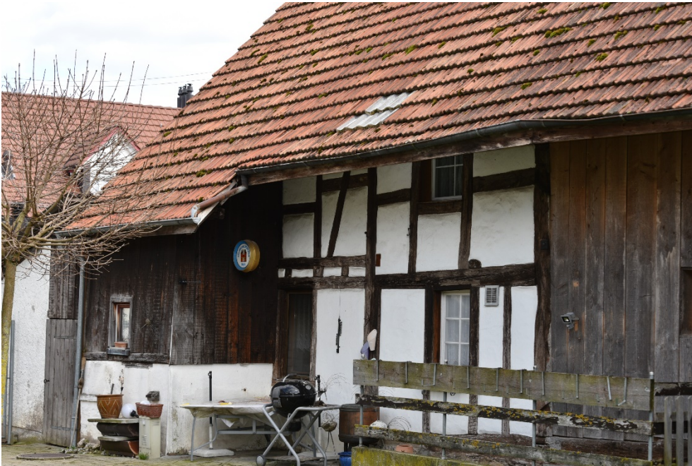
Ehem. Vielzweckbauernhaus, Wohnteil, Ansicht von NW, 11.03.2020 (Bild Nr. D100560_18).
