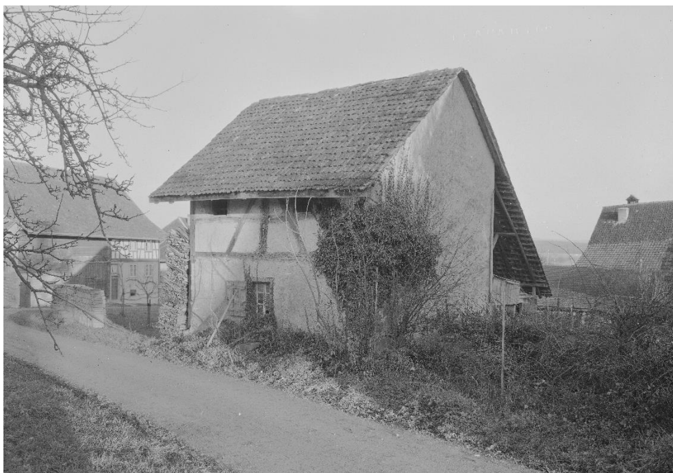
Speicher, Zustand vor Renovation 1961, Ansicht von SW, 28.11.1960 (Bild Nr. U19553).
