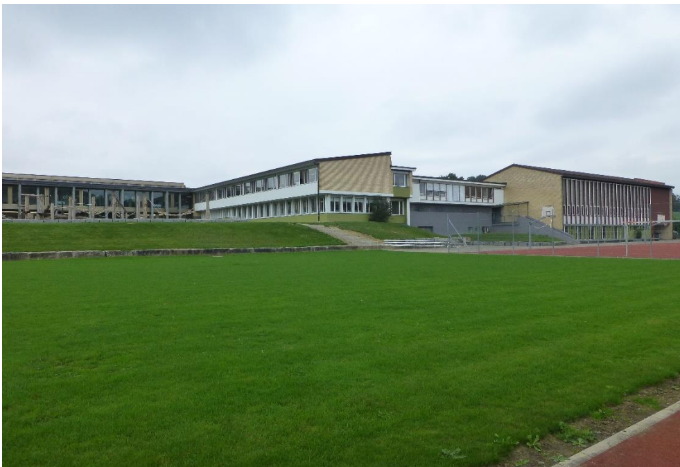
Schulanlage Im Gsteig, Erweiterungsbau Marchlen (063ERWEITERUNG00201), Klassentrakt (Vers. Nr. 00201), Zwischentrakt (063ZWISCHENTRAKT00201), Turnhalle (063TURNHALLE00201), Ansicht von SO, 01.10.2013 (Bild Nr. D100554_06).
