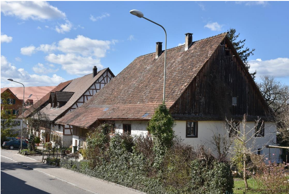
Ehem. Vielzweckbauernhaus, Ansicht von SO, 13.03.2020 (Bild Nr. D100562_21).
