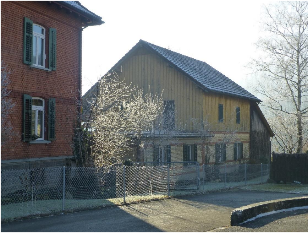
Wohnhaus Steiner mit Nebengebäude, Stall und Autoremise (Vers. Nr. 001433), Ansicht von NO, 17.12.2013 (Bild Nr. D100561_67).
