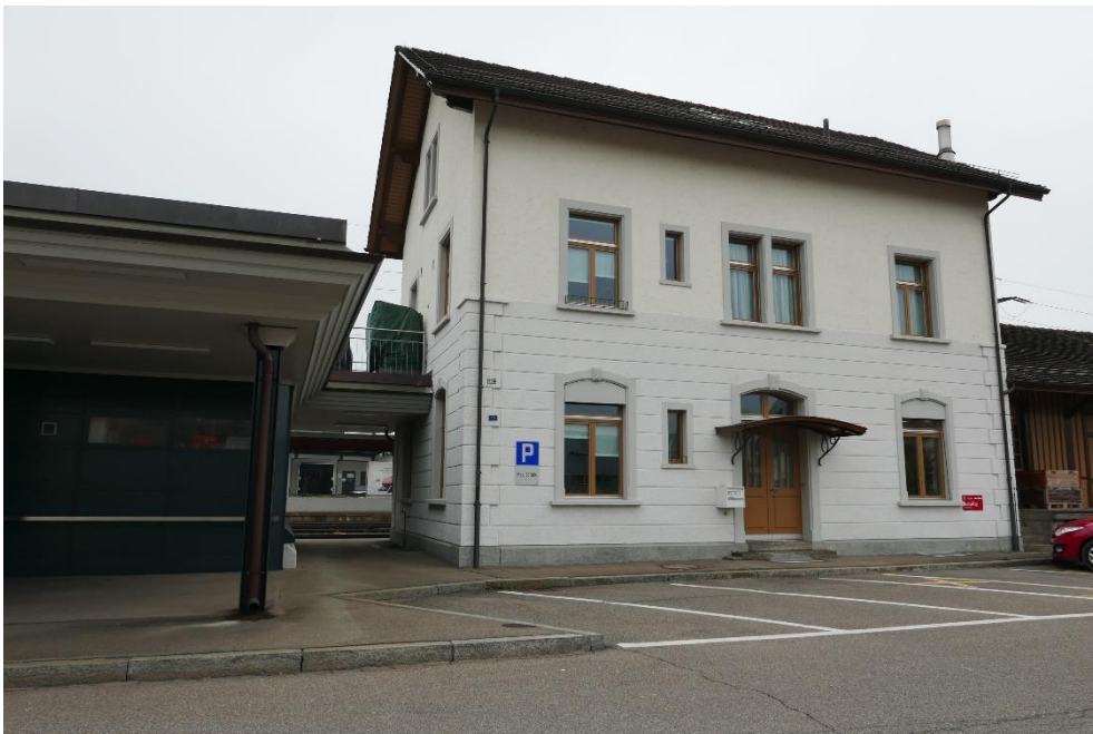
Bahnhof Niederglatt, Aufnahmegebäude (Vers. Nr. 00778), Ansicht von W, 31.10.2016 (Bild Nr. D100561_70).
