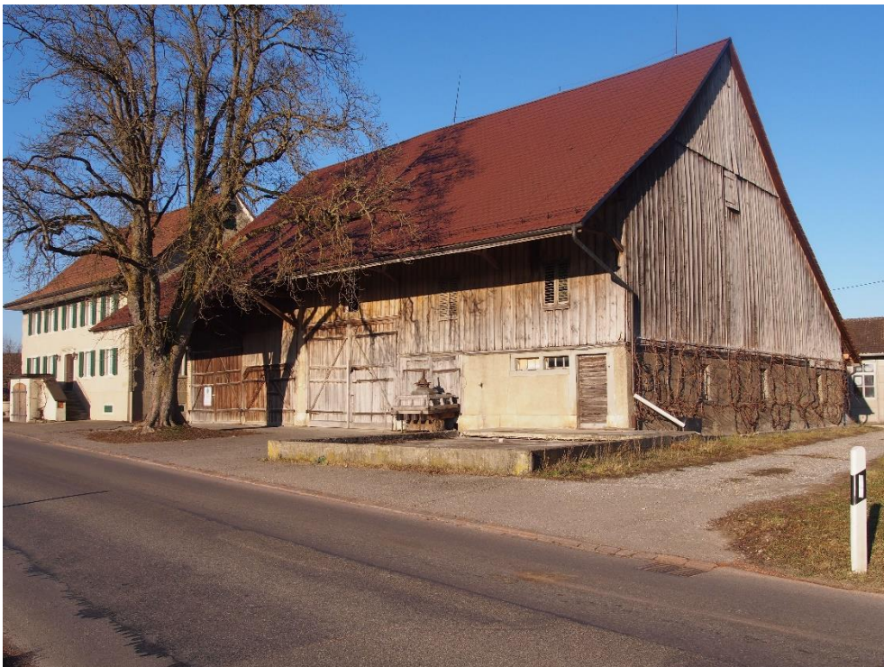
Bauernwohnhaus mit Scheune, Ansicht von SW, 18.02.2019 (Bild Nr. D101391_62).
