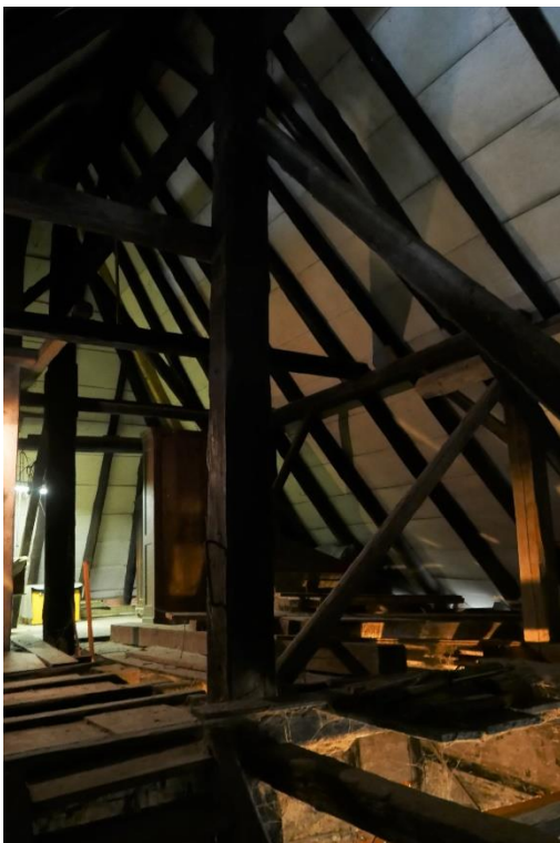
Ehem. Kleinbauernhaus, Dachraum mit Hochstudkonstruktion, Blick gegen S, 16.11.2016 (Bild Nr. D100560_38).
