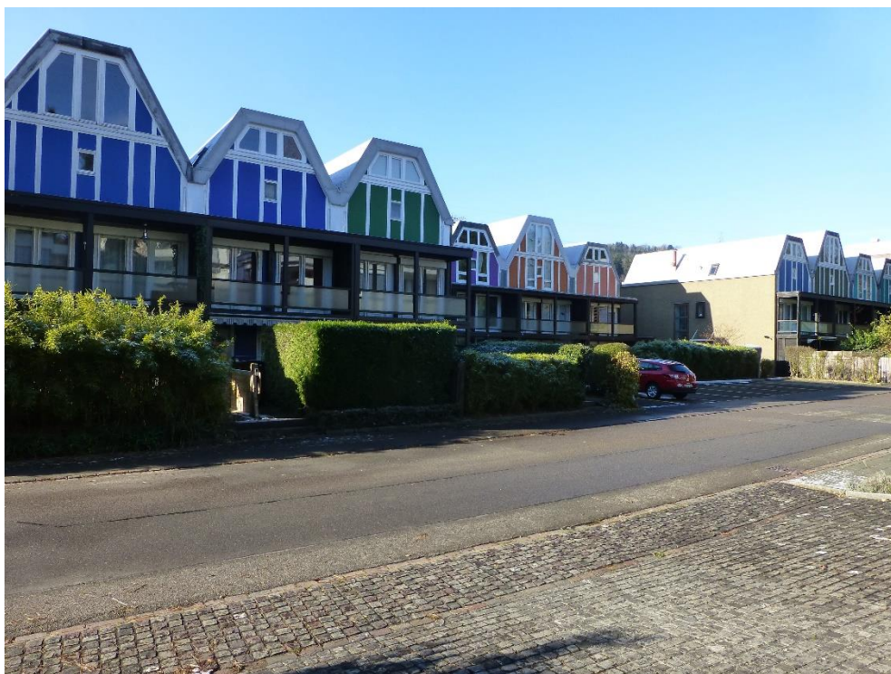
Wohnsiedlung «Wyler am Teich», Häusergruppen im S, links Reihenhäuser Nr. 23, 25, 27, Mitte Reihenhäuser Nr. 31, 33, 35, rechts Reihenhäuser Nr. 37, 39, 41, 43, Ansicht von SO, 26.11.2013 (Bild Nr. D100564_51).
