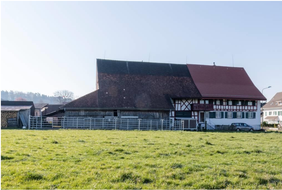
Vielzweckbauernhaus, Ansicht von NW, 13.05.2020 (Bild Nr. D101391_74).
