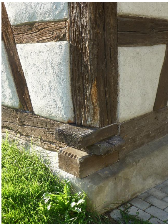
Ehem. Trotte, Schwellenschloss an der SO-Ecke, Ansicht von O, 24.10.2013 (Bild Nr. D100566_02).
