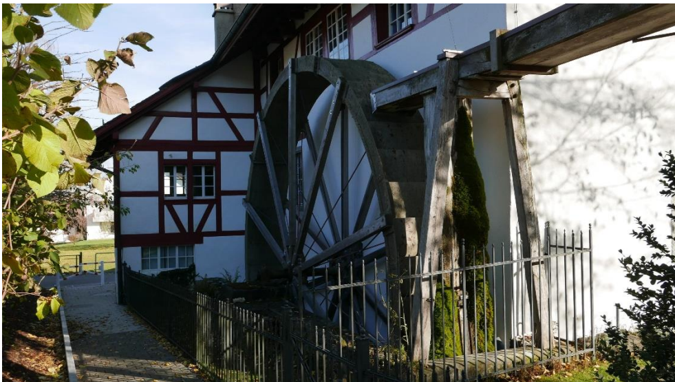
Geigenmühle, Wasserrad (088WASSERRAD00406) und Mühlenkanal (088WR-DIELSDORF00097), Ansicht von SW, 24.11.2017 (Bild Nr. D100596_20).
