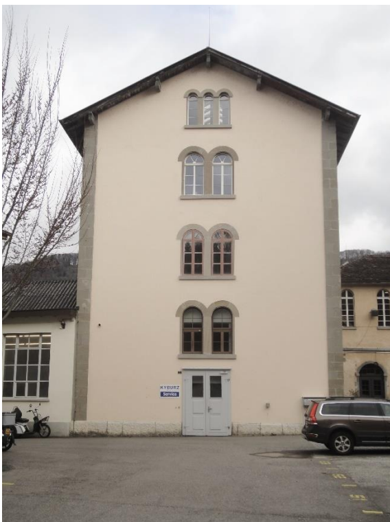
Ehem. Spinnerei Blumer, Fabrikanlage, Vorwerk I (057VORWI00027), Ansicht von S, 12.03.2020 (Bild Nr. D100681_39).
