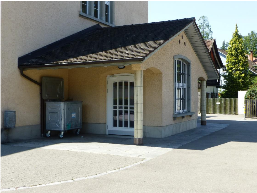
Schulhaus Dorf, Eingang mit Windfang, Ansicht von SO, 12.03.2013 (Bild Nr. D101367_28).
