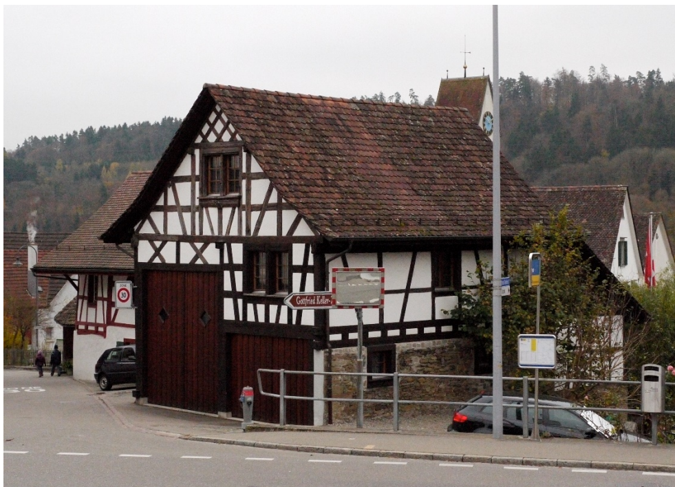
Wohnhaus und ehem. Scheune mit Speicher, ehem. Scheune mit Speicher (Vers. Nr. 00486), Ansicht von N, 18.11.2013 (Bild Nr. D100575_05).
