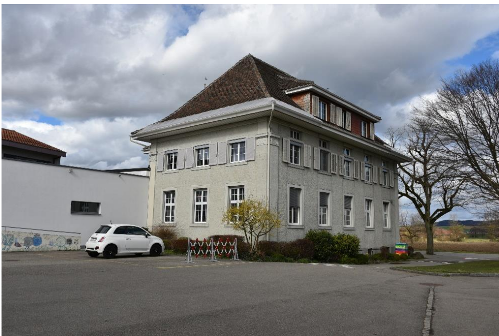
Schulhausensemble, Primarschulhaus (Vers. Nr. 00138), Ansicht von S, 11.03.2020 (Bild Nr. D100600_07).
