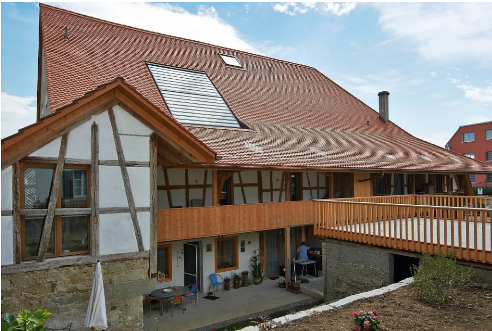
Vielzweckbauernhaus, Ansicht von N, 22.09.2018 (Bild Nr. D101791_60).
