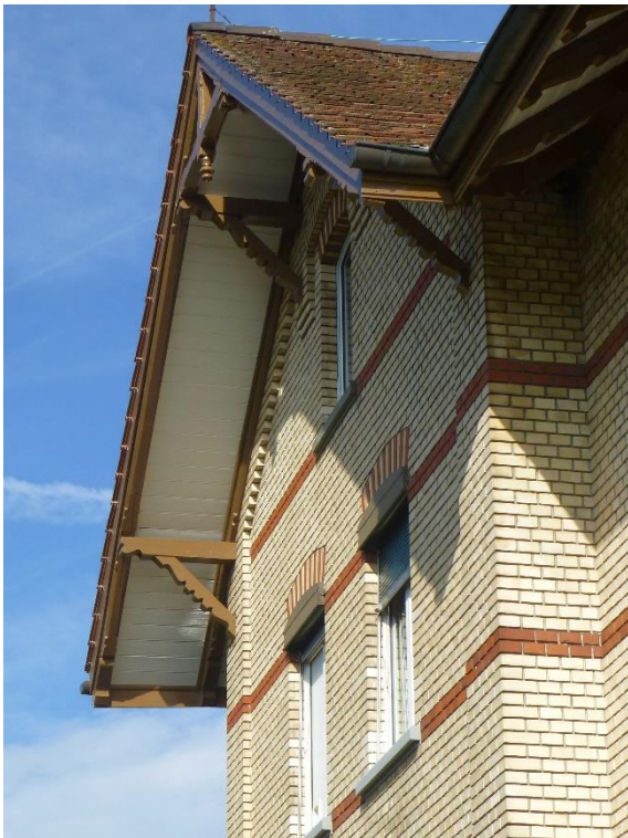
Ehem. Schulhaus Teufen, Kehrfirstanbau mit Flugsparrenkonstruktion, Ansicht von S, 22.10.2013 (Bild Nr. D100566_73).
