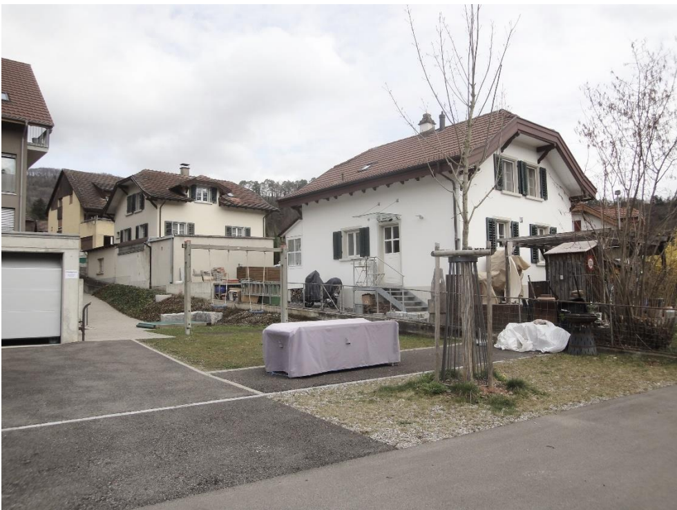
Ehem. Spinnerei Blumer, ehem. Kosthäuser und Wohnhäuser, Wohnhaus Giesserweg 4 (Vers. Nr. 00062), Ansicht von SW, 13.03.2020 (Bild Nr. D100681_65).
