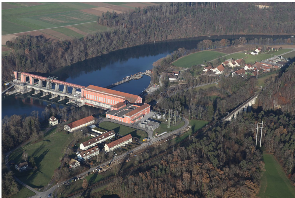
Kraftwerk Eglisau, im Vordergrund Wohnkolonie für Angestellte, Ansicht von SW, Flugaufnahme, 04.12.2013 (Bild Nr. D100567_39).
