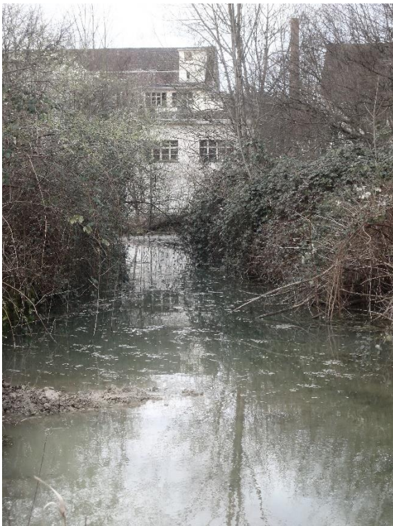
Ehem. Spinnerei Blumer, Fabrikanlage, Oberwasserkanal (057WR-BUELACH00205), im Hintergrund die Webereizentrale (057WEBZEN00027), dahinter die Spinnerei (057SPINNERE00027), Ansicht von O, 12.03.2020 (Bild Nr. D100681_49).
