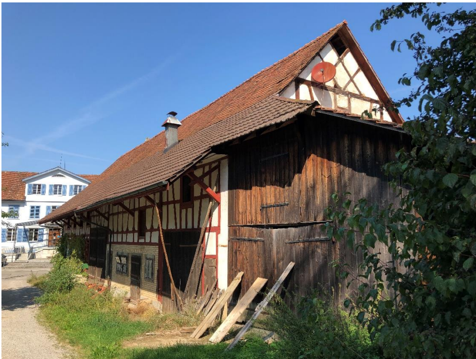
Bauernhaus «Scheibli», Mitte Stall (EG mit Sichtbackstein), rechts davon nachträglich errichtete Schopfanbauten, Ansicht von SO, 14.09.2020 (Bild Nr. D100570_19).
