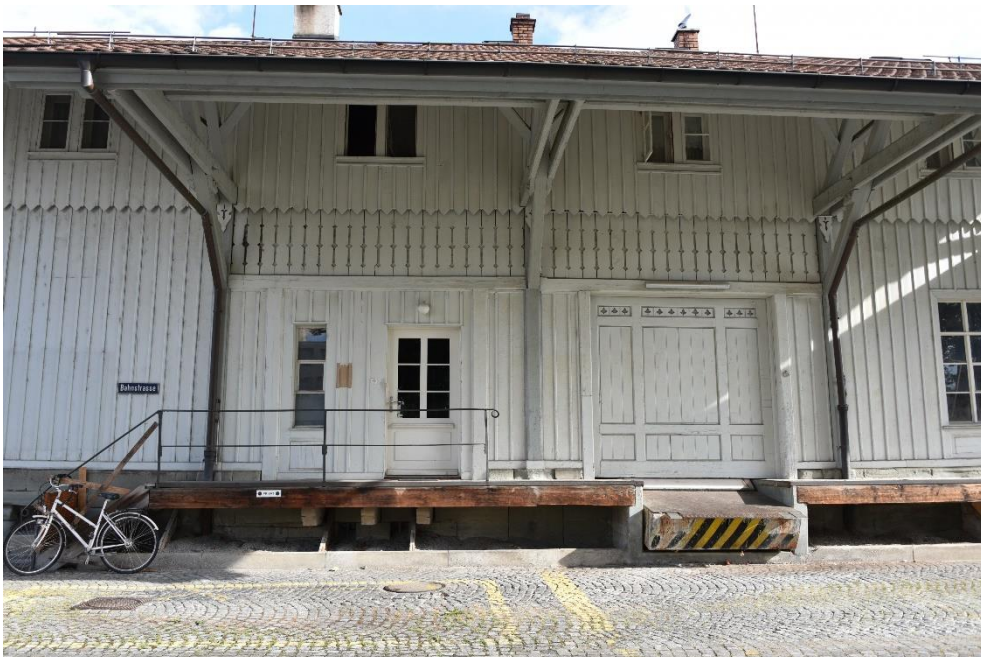
Bahnhof Embrach-Rorbas, Güterschuppen (Vers. Nr. 01355), Südfassade, Ansicht von S, 24.08.2020 (Bild Nr. D100553_73).
