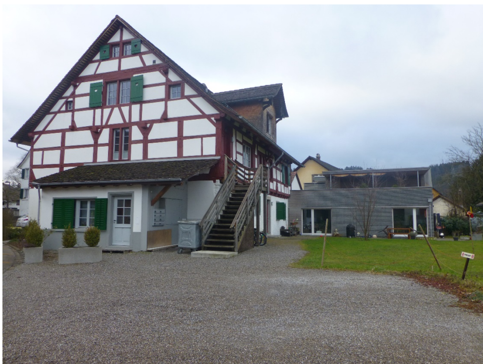
Altes Pfarrhaus, rechts Wohnbau anstelle des Waschhauses, Ansicht von NO, 12.02.2014 (Bild Nr. D101355_84).
