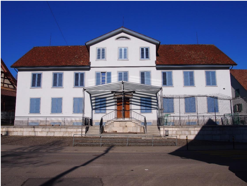
Primarschulhaus, Ansicht von SO, 18.02.2019 (Bild Nr. D100572_49).
