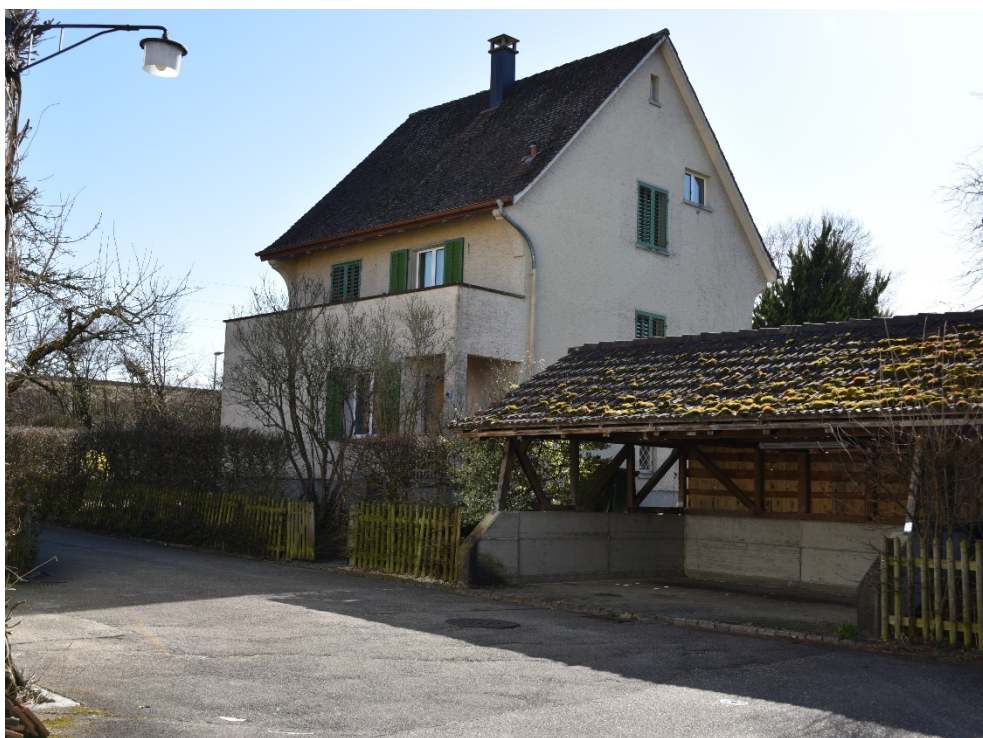
Kraftwerk Eglisau, Wohnkolonie für Angestellte, Betriebsleiterwohnhaus (Vers. Nr. 01615), Ansicht von NO, 13.03.2020 (Bild Nr. D100575_44).
