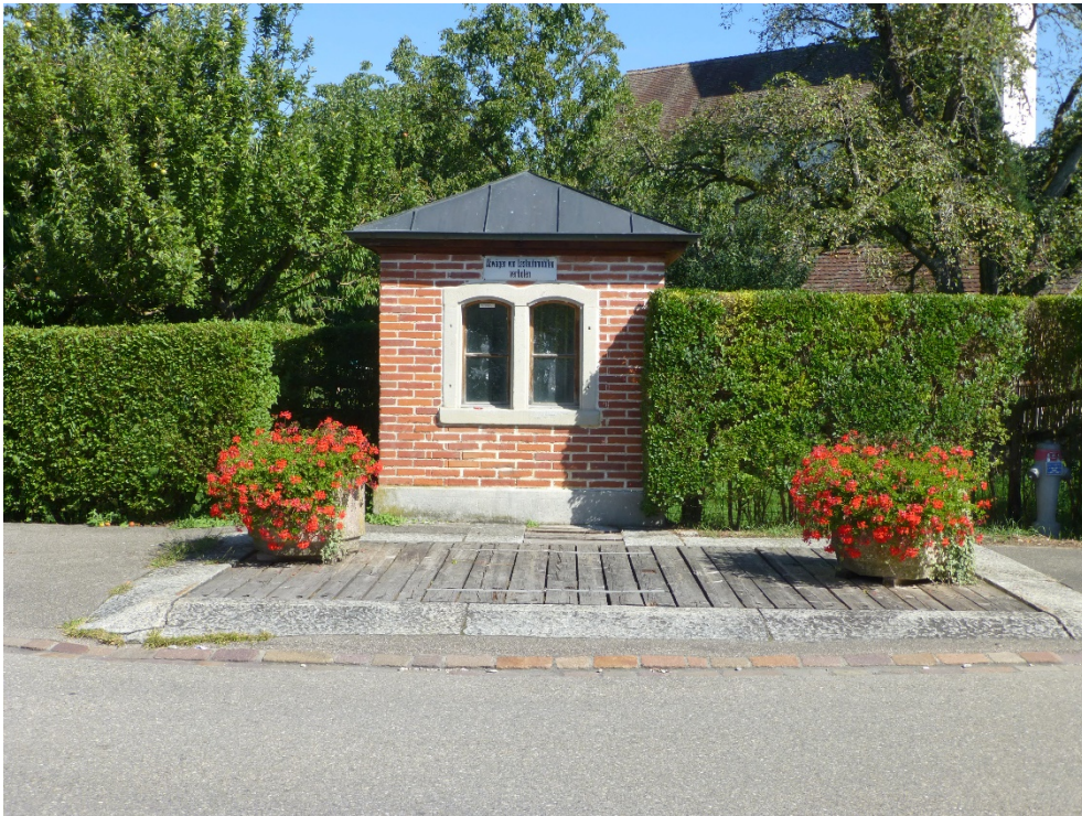
Brückenwaage, Ansicht von S, 27.08.2015 (Bild Nr. D100576_03).
