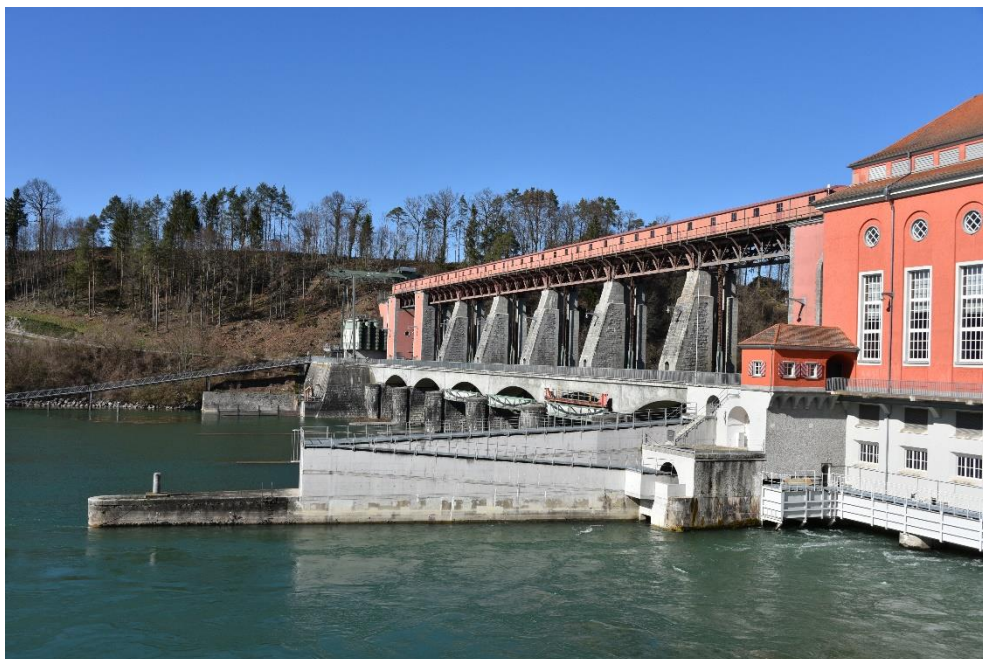
Kraftwerk Eglisau, Stauwehr (058STAUWEHR01656) und Windwerkbrücke mit Wehrantrieb (Vers. Nr. 01658), rechts Fischtreppe (058FISCHTREPPE01656), altes Zollhaus und Maschinenhaus (Vers. Nr. 01656), Ansicht von S, 13.03.2020 (Bild Nr. D100567_23).
