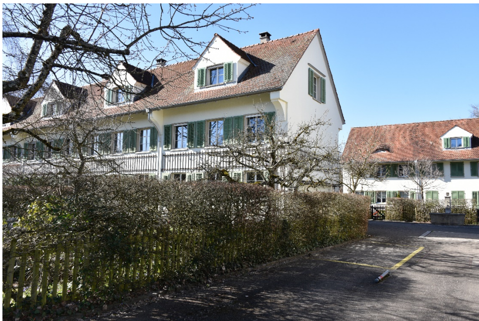
Kraftwerk Eglisau, Wohnkolonie für Angestellte, links Reihenwohnhaus 1 (Vers. Nr. 01618), rechts im Hintergrund Reihenwohnhaus 3 (Vers. Nr. 01621) und Hofbrunnen (058BRUNNEN00001), Ansicht von SO, 13.03.2020 (Bild Nr. D100575_46).
