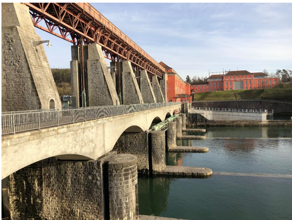
Kraftwerk Eglisau, Stauwehr (058STAUWEHR01656), Windwerkbrücke mit Wehrantrieb (Vers. Nr. 01558), Schalthaus (Vers. Nr. 01655), Ansicht von NW, 22.02.2020 (Bild Nr. D100567_25).
