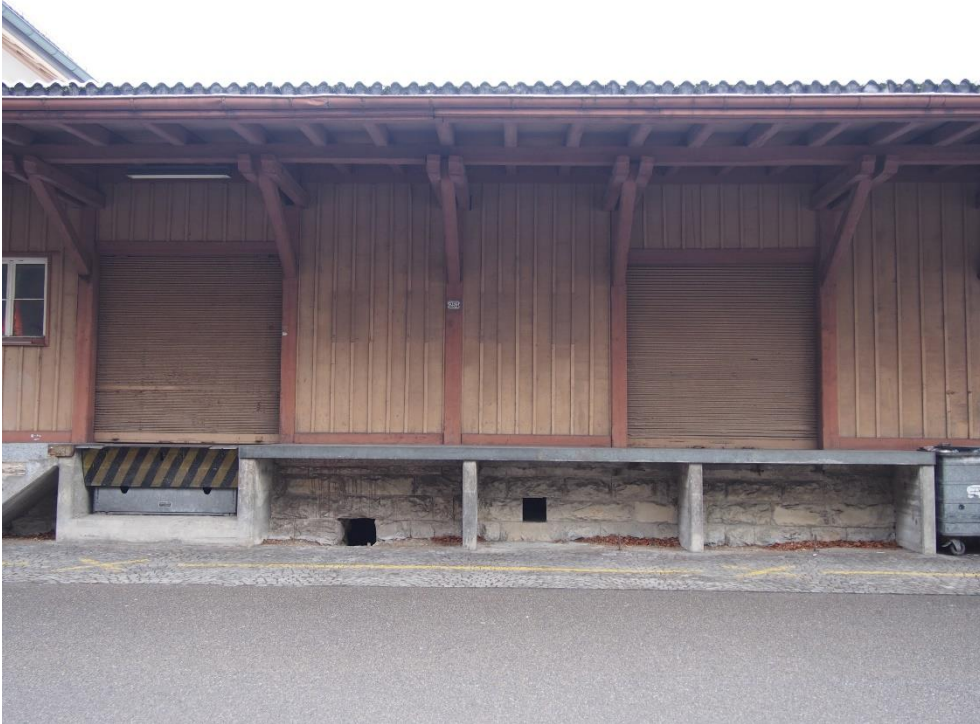
Bahnhof Hüntwangen-Wil, Güterschuppen, Teilansicht von NW, 07.02.2019 (Bild Nr. D100573_89).
