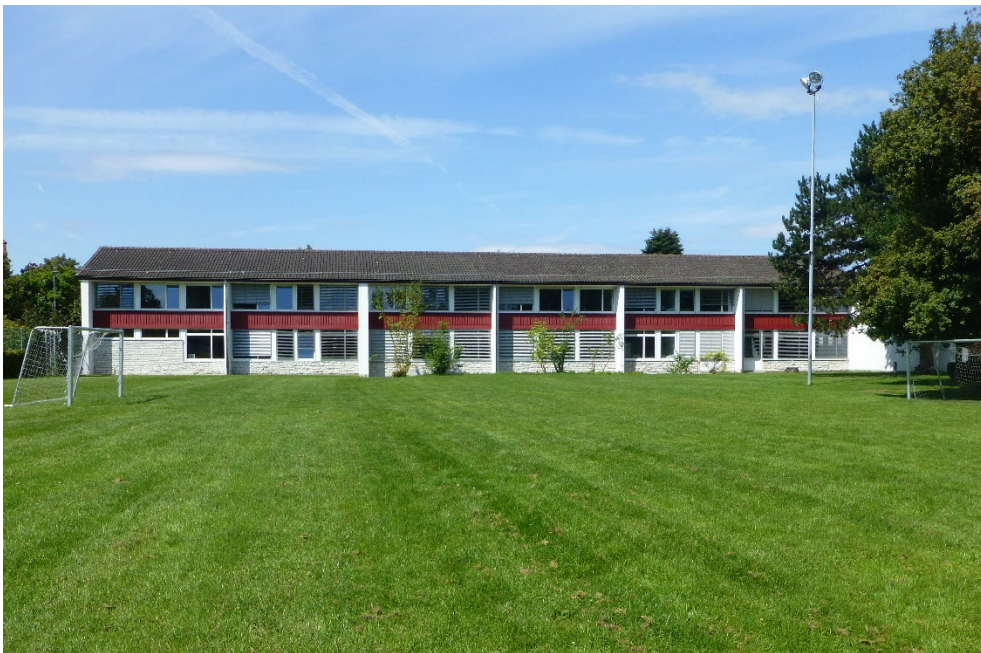
Schulanlage Schmittenwis, Trakt A (Vers. Nr. 00216), Ansicht von SO, 22.08.2014 (Bild Nr. D100570_55).
