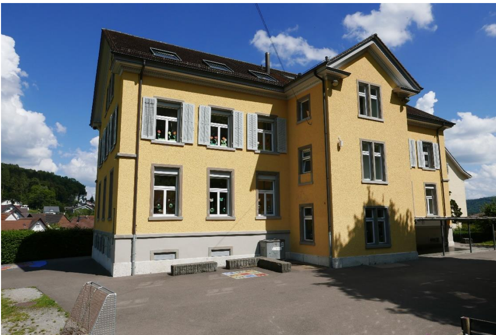
Primarschulhaus, Ansicht von NW, 06.06.2016 (Bild Nr. D100573_37).
