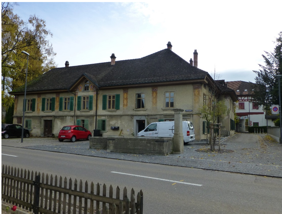
Ehem. Amtshaus mit Nebengebäude, Ehem. Amtshaus (Vers. Nr. 00614), Ansicht von NW, 31.10.2013 (Bild Nr. D100563_48).
