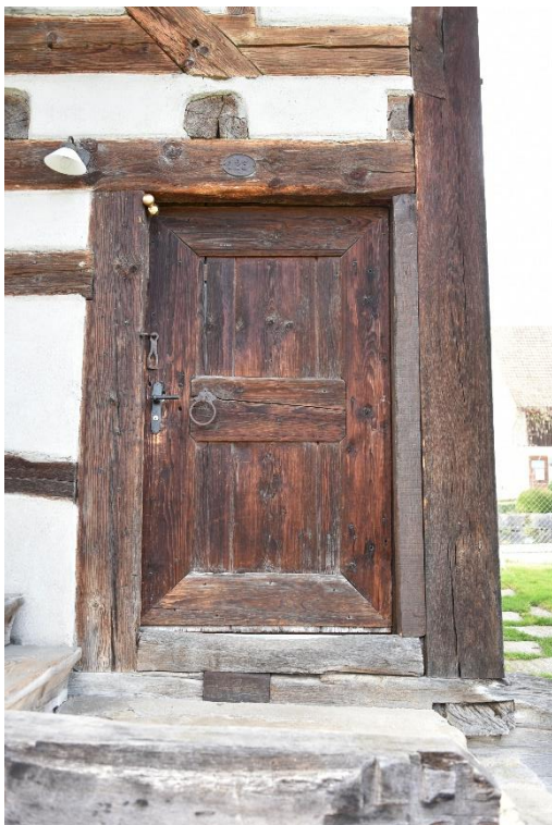
Speicher, Südostfassade, Eingang EG, Ansicht von SO, 11.03.2020 (Bild Nr. D100571_64).
