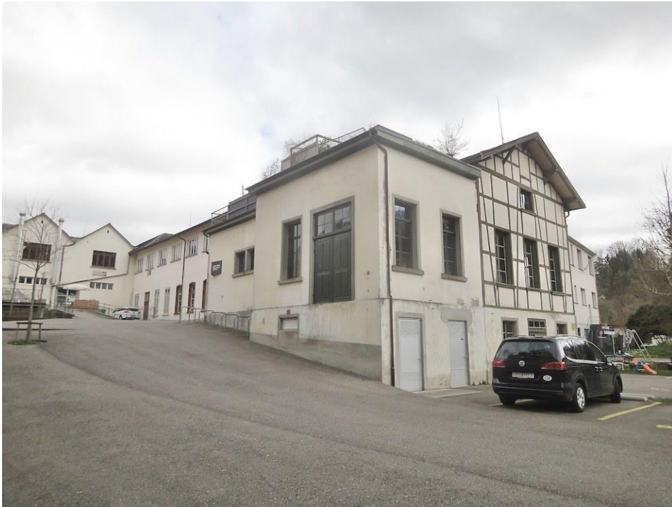
Ehem. Spinnerei Blumer, Fabrikanlage, Webereizentrale (057WEBZEN00027), links hinten die Weberei (057WEBEREI00027), Ansicht von SW, 12.03.2020 (Bild Nr. D100681_38).
