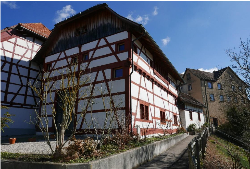
Bauernhaus mit Schopf, Ansicht von SW, 10.03.2017 (Bild Nr. D101097_22).
