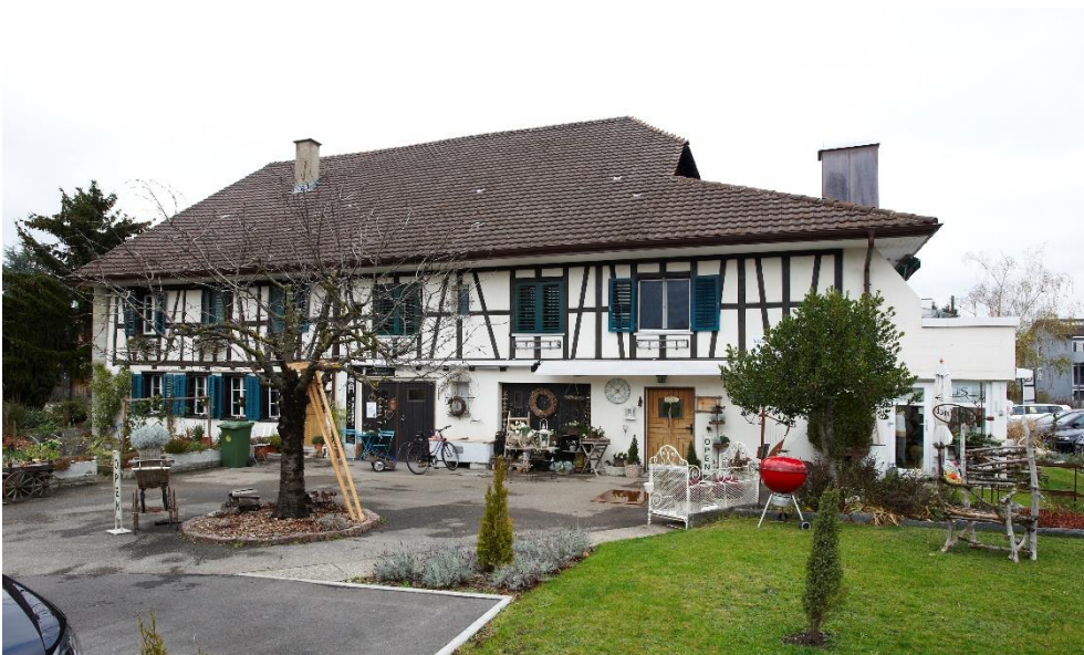
Ehem. Zehntenscheune, Hausteil SW (Vers. Nr. 01239), Ansicht von SW, 27.11.2015 (Bild Nr. D100587_35).
