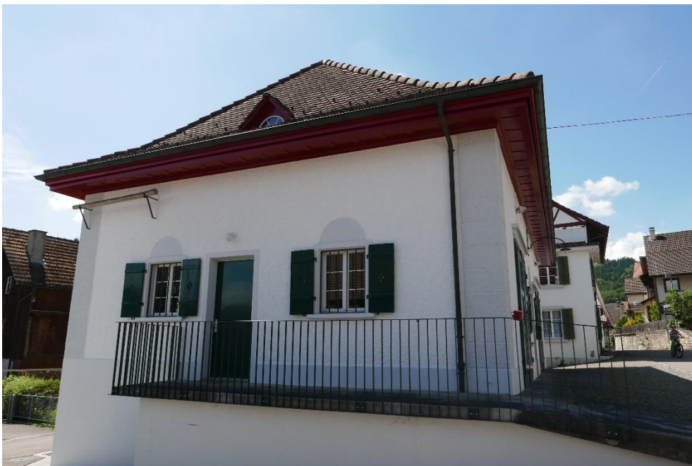
Mehrzweckgebäude Gemeindedienste, Ansicht von SO, 06.06.2016 (Bild Nr. D100573_47).
