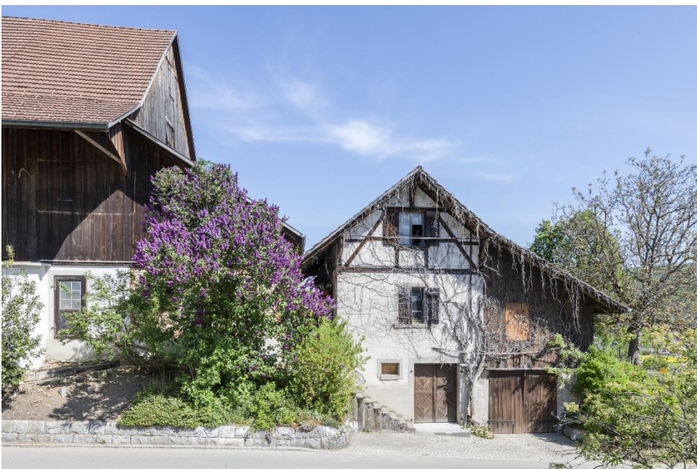
«Untervogthaus» mit Speicher, Speicher (Vers. Nr. 00127), Ansicht von S, 24.04.2020 (Bild Nr. D101367_38).
