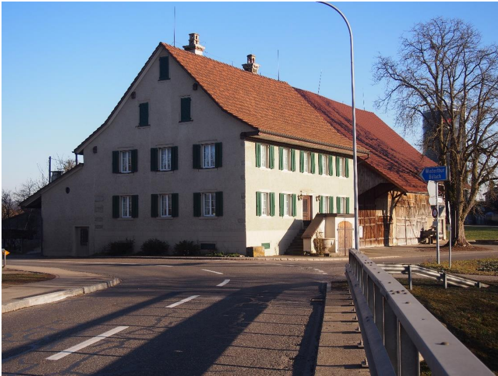
Bauernwohnhaus mit Scheune, Ansicht von NW, 18.02.2019 (Bild Nr. D101391_61).
