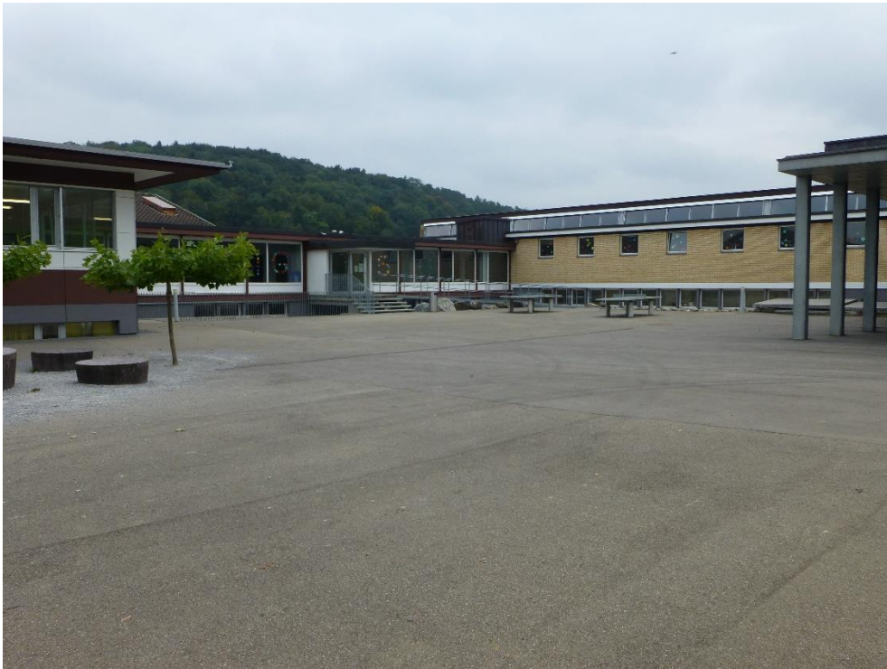
Schulanlage Im Gsteig, Zwischentrakt (063ZWISCHENTRAKT00201), Klassentrakt (Vers. Nr. 00201), Ansicht von NW, 01.10.2013 (Bild Nr. D100554_19).
