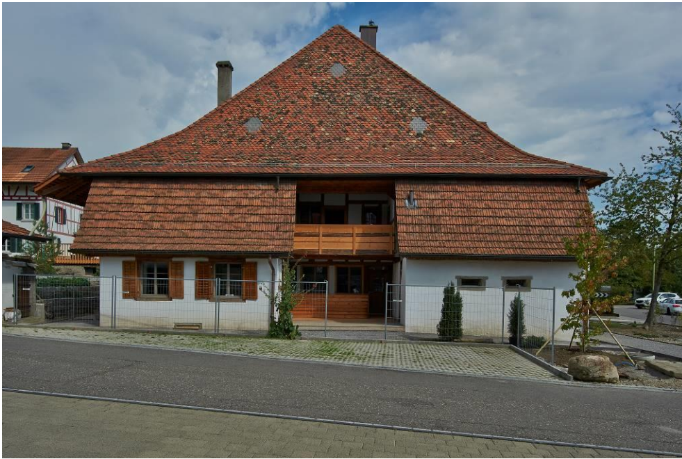
Vielweckbauernhaus, Ansicht von SW, 22.09.2018 (Bild Nr. D101791_56).
