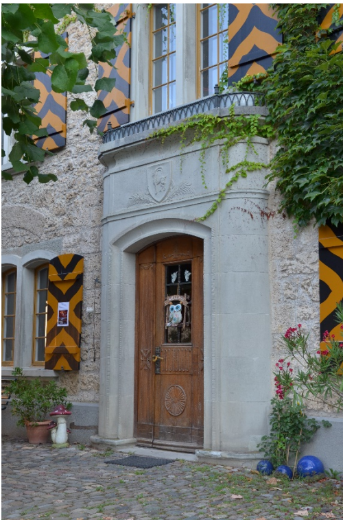
Schloss Teufen, Ostflügel (Vers. Nr. 00371), Eingangsportal in der Ostmauer der Durchfahrt, Ansicht von SW, 12.08.2020 (Bild Nr. D100598_15).
