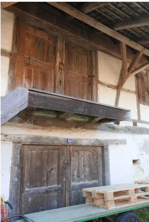
Speicherensemble, Speicher «Schütz» (Vers. Nr. 00088), Ansicht von NO, 10.03.2017 (Bild Nr. D100570_83)
