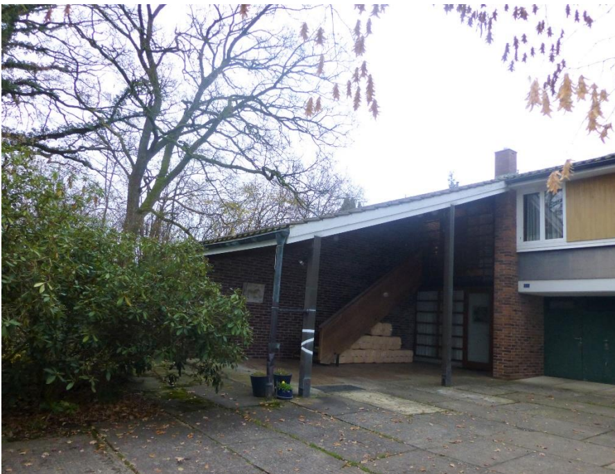
Landhaus Hauser-Bucher mit Wohngarten, Landhaus (Vers. Nr. 00298), Osttrakt mit gedeckter Eingangshalle, Ansicht von NW, 28.11.2014 (Bild Nr. D100570_32).
