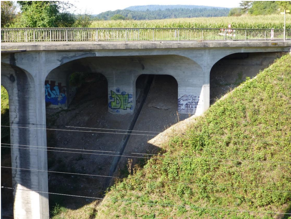
Bahnüberführung, Ansicht von NO, 28.08.2015 (Bild Nr. D100576_13).
