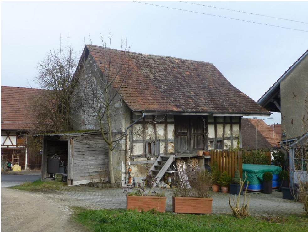
Speicher, Ansicht von SW, 16.01.2015 (Bild Nr. D100560_53).
