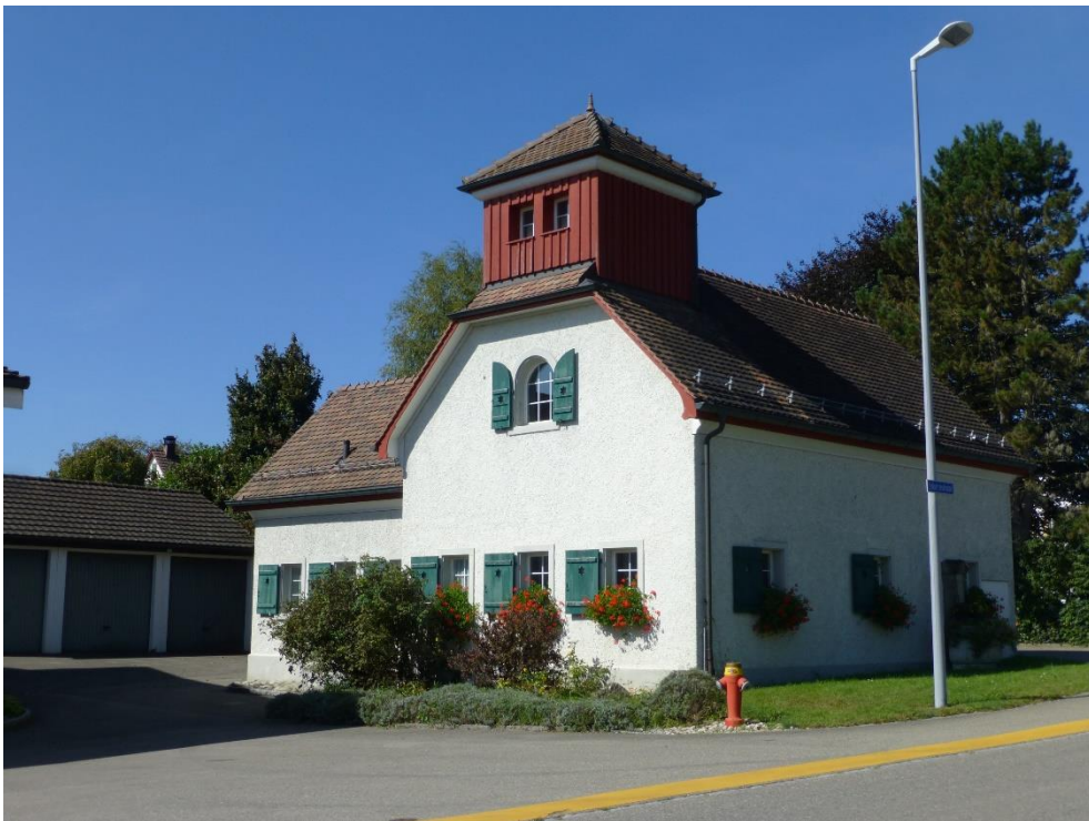
Ehem. Feuerwehrgeräte lokal mit Schlachthausanbau, Ansicht von SO, 23.09.2014 (Bild Nr. D100568_23).
