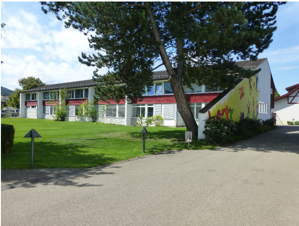
Schulanlage Schmittenwis, Trakt A (Vers. Nr. 00216), Ansicht von NO, 22.08.2014 (Bild Nr. D100570_58).
