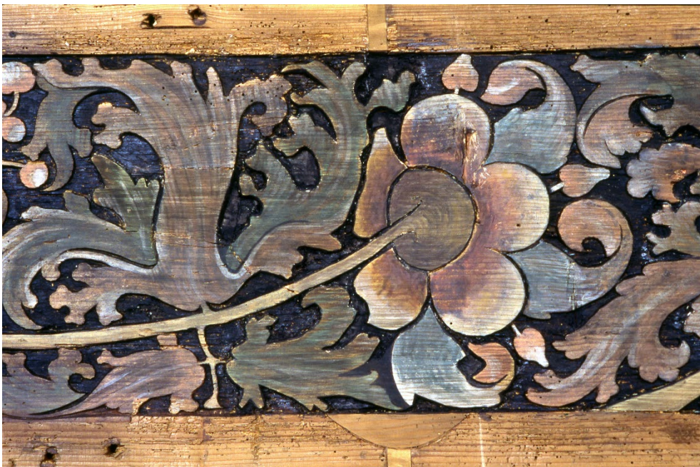
Ehem. Gemeinde- und Schulhaus, 1. OG, Decke mit spätgotischen Flachschnitzereien, Zustand 1994 (Bild Nr. L36359_17).
