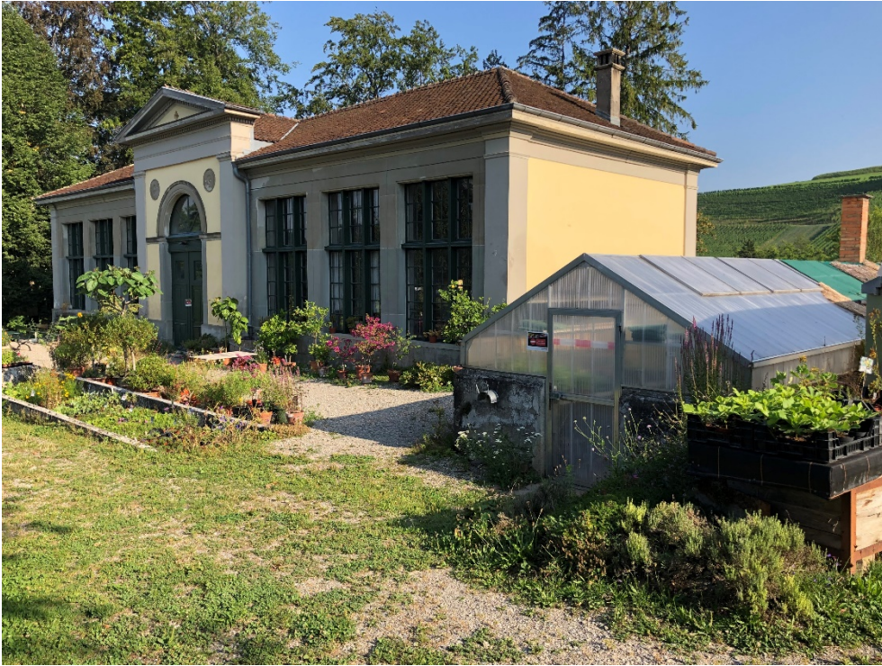
Schloss Teufen, Orangerie (Vers. Nr. 00379), Ansicht von SO, 12.08.2020 (Bild Nr. D100598_45).
