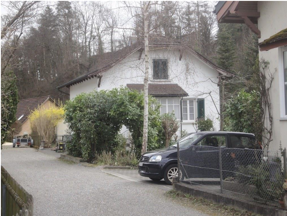
Ehem. Spinnerei Blumer, ehem. Kosthäuser und Wohnhäuser, Wohnhaus Giesserweg 8 (Vers. Nr. 00066), Ansicht von NW, 27.03.2020 (Bild Nr. D100681_64).
