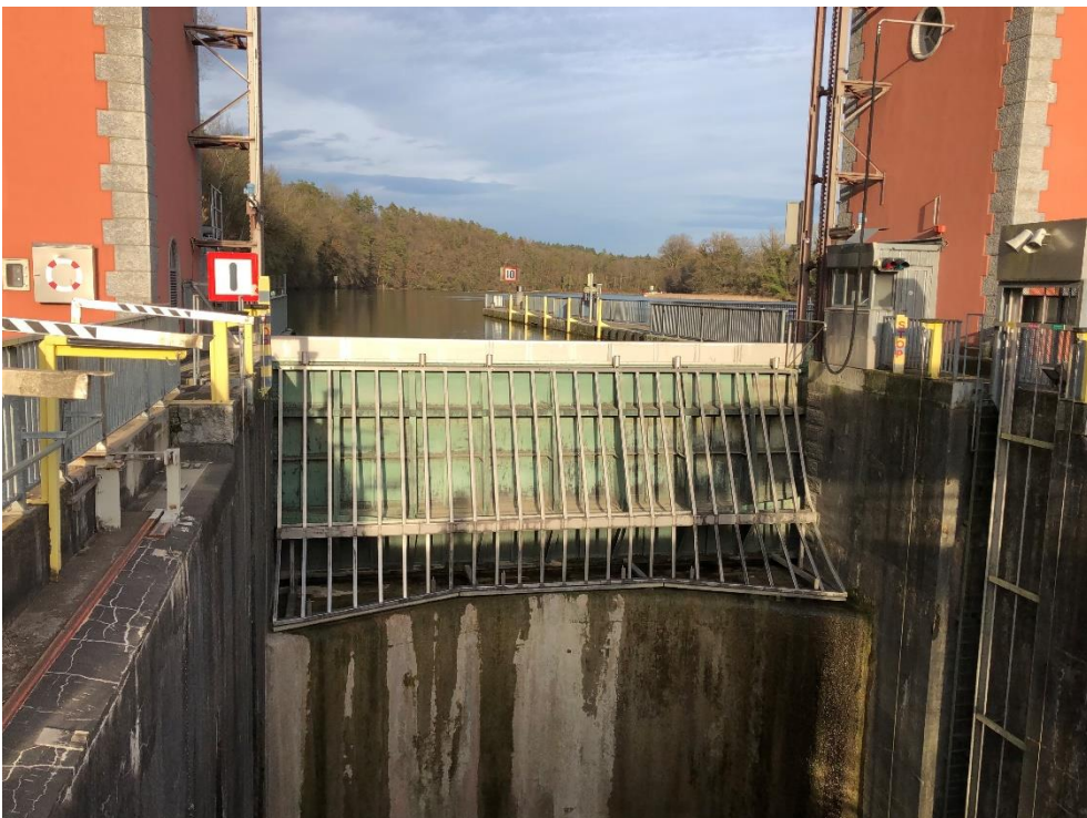
Kraftwerk Eglisau, Schiffsschleuse (058SCHLEUSE01656), Ansicht von SW, 22.02.2020 (Bild Nr. D100567_10).
