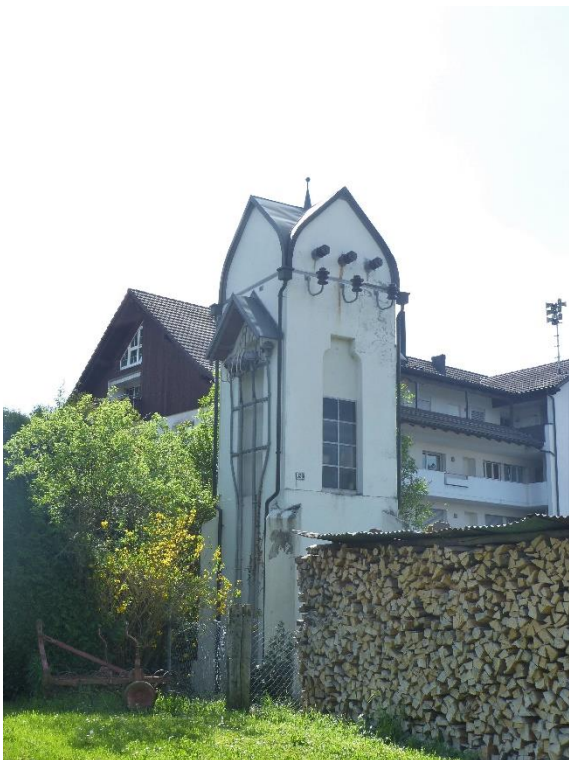
Transformatorstation Oberhasli, Ansicht von NO, 09.04.2014 (Bild Nr. D100562_03).
