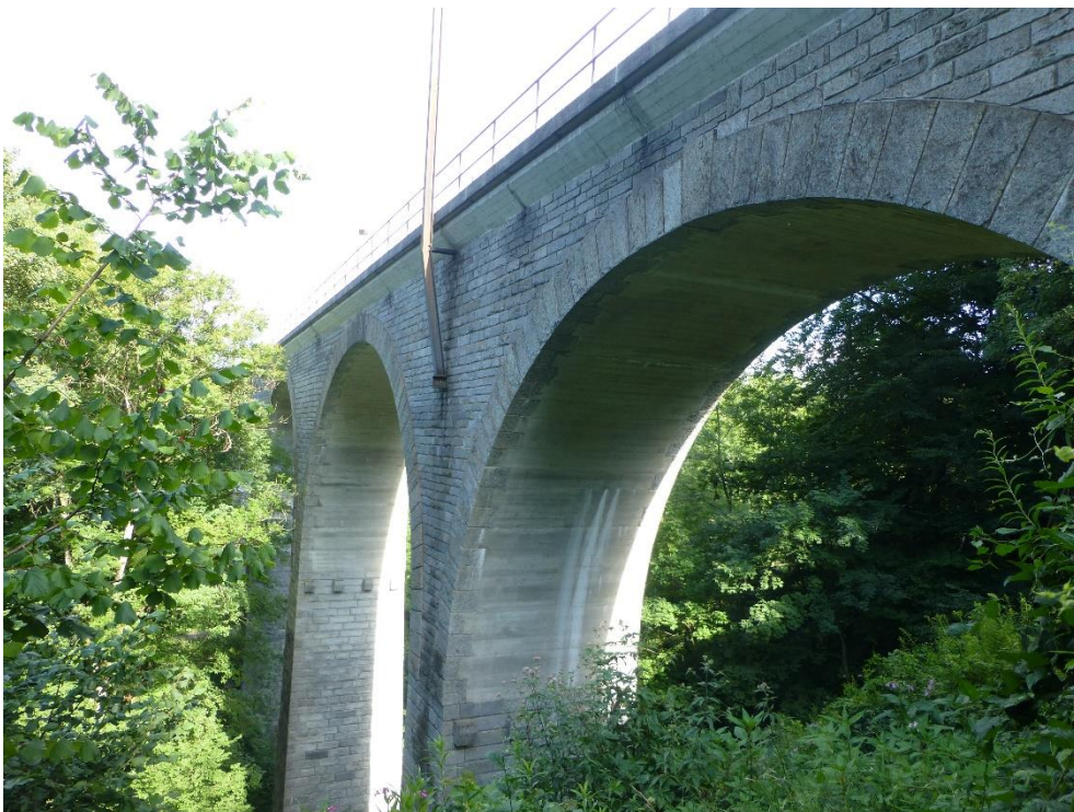
Bahnhof Embrach-Rorbas, Eisenbahnbrücke Wildbach (056BRUECKE00001, 068BRUECKE00003), Ansicht von NW, 30.07.2013 (Bild Nr. D100553_57).
