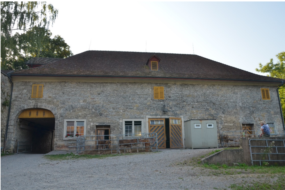
Schloss Teufen, Schlossscheune (Vers. Nr. 00374), Ansicht von NW, 12.08.2020 (Bild Nr. D100598_24).
