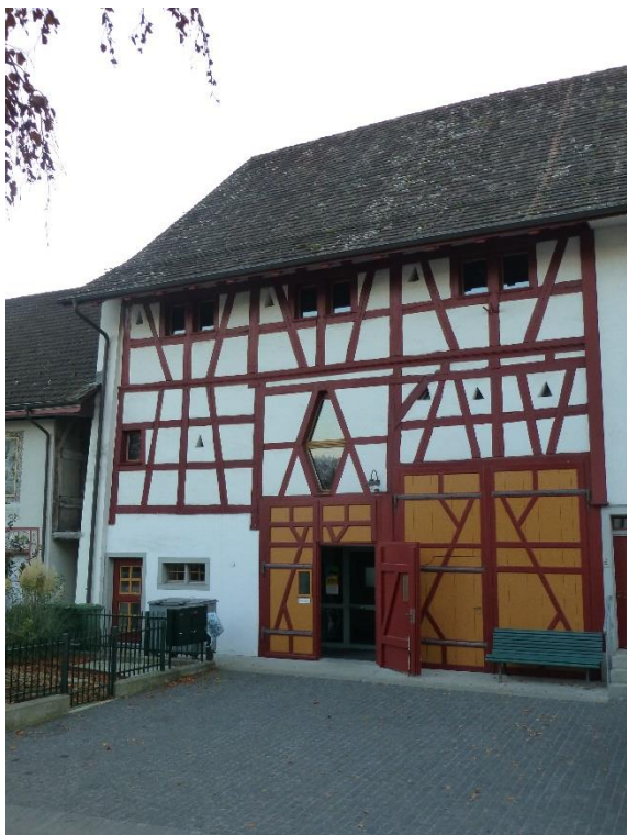
Ref. Kirchgemeindehaus, Ehem. Ökonomieteil, Ansicht von O, 17.02.2014 (Bild Nr. D100563_13).
