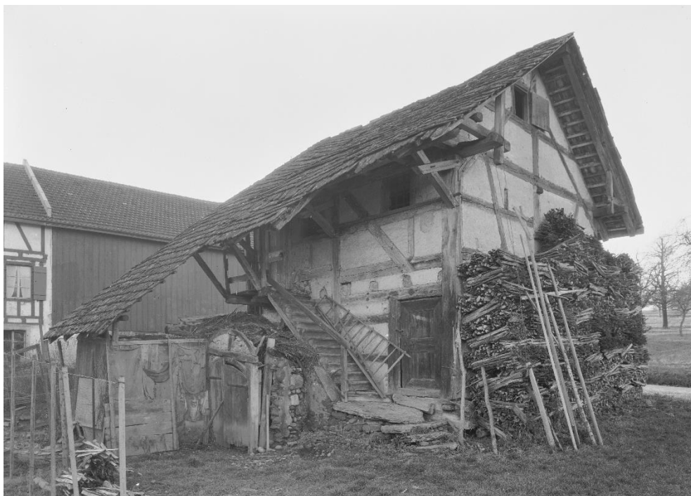
Speicher, Zustand vor Renovation 1961, Ansicht von O, 28.11.1960 (Bild Nr. U19552).
