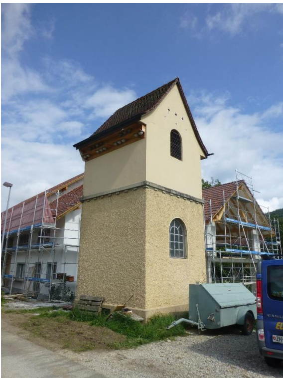
Transformatorstation «Dorf», Ansicht von SO, 19.08.2014 (Bild Nr. D100570_02).
