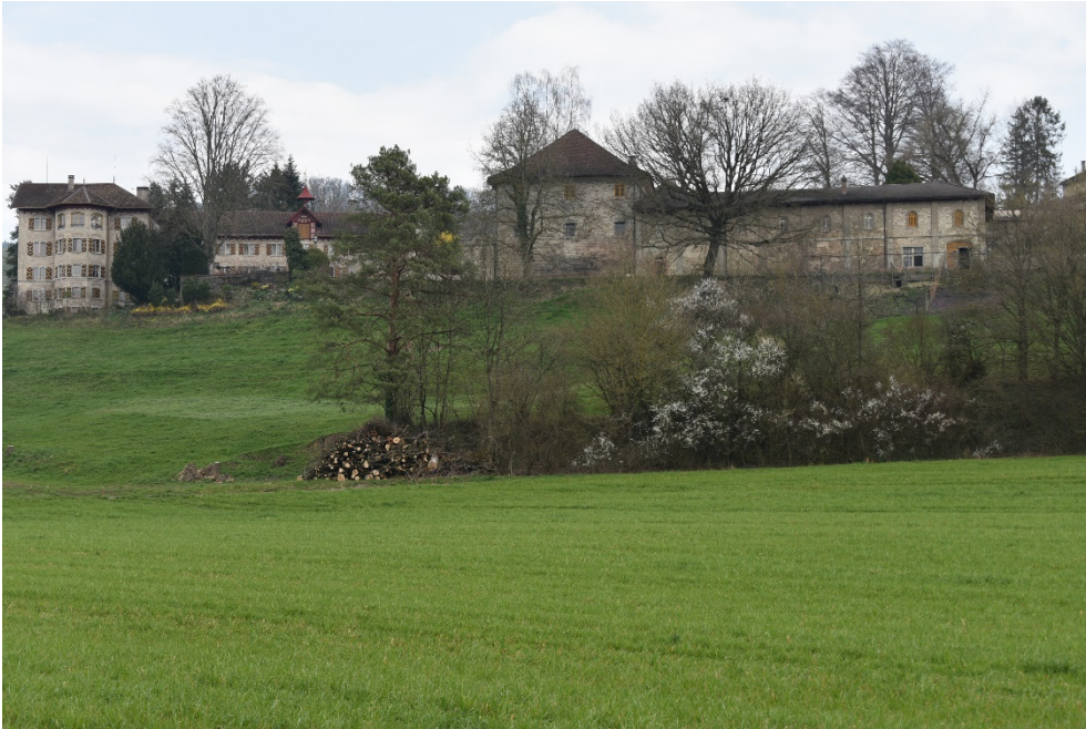
Schloss Teufen, Altes Schloss mit Südflügel (Vers. Nr. 00372), Ostflügel (Vers. Nr. 00371), Schlossscheune (Vers. Nr. 00374) und Geräte-/Holzschopf (Vers. Nr. 00375), Ansicht von SW, 20.03.2020 (Bild Nr. D100598_07).
