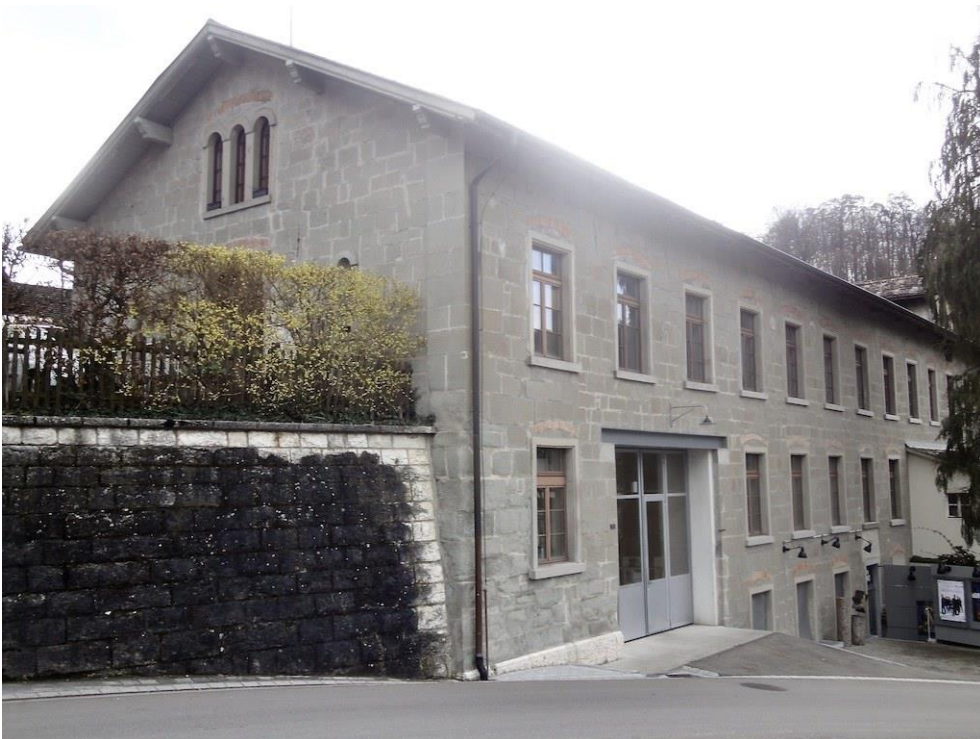
Ehem. Spinnerei Blumer, Fabrikanlage, Vorwerk I (057VORWI00027), Ansicht von NW, 12.03.2020 (Bild Nr. D100681_35).
