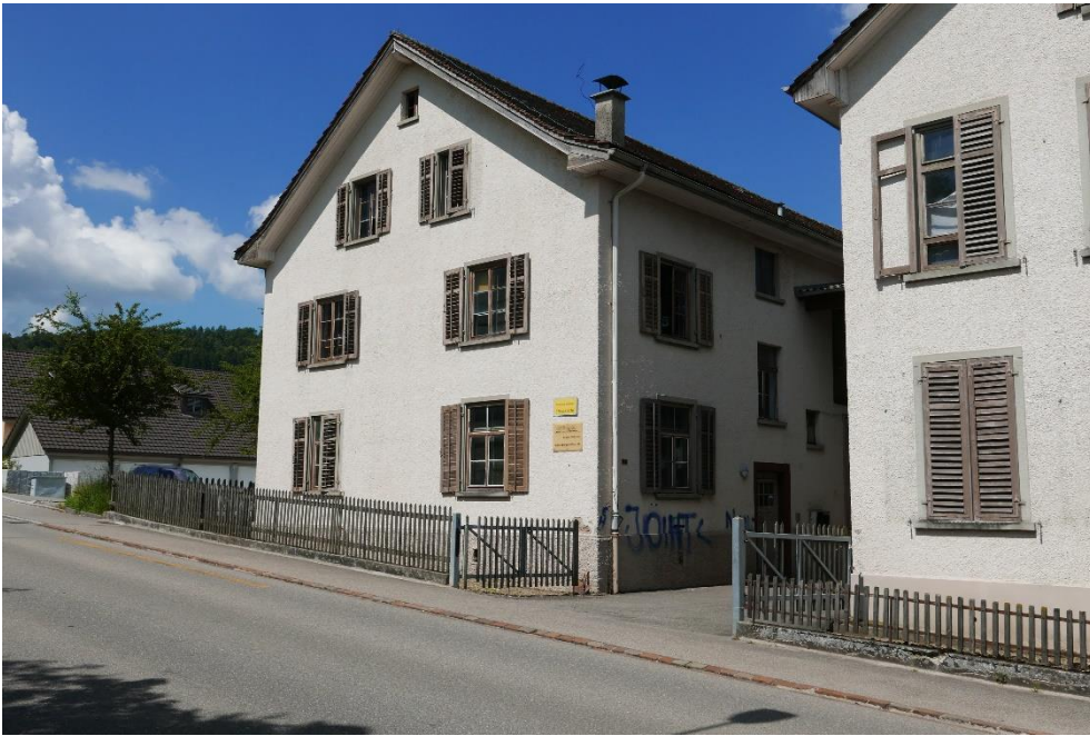
Ehem. Hutfabrik Ritz, Nordwesttrakt (061BEI00087), Ansicht von S, 06.06.2016 (Bild Nr. D100573_25).
