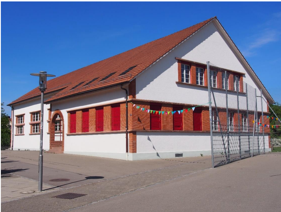
Ehem. Sekundarschulhaus mit Turnhalle, Ansicht von SW, 23.05.2019 (Bild Nr. D101364_02).
