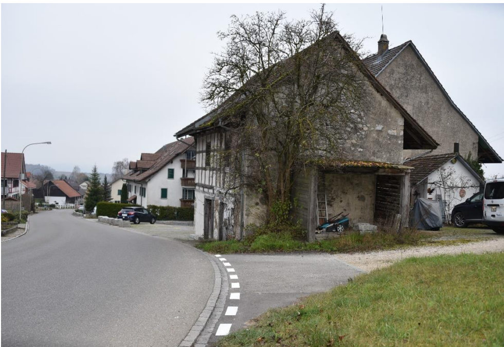
Speicher, Ansicht von W, 25.11.2020 (Bild Nr. D100560_63).
