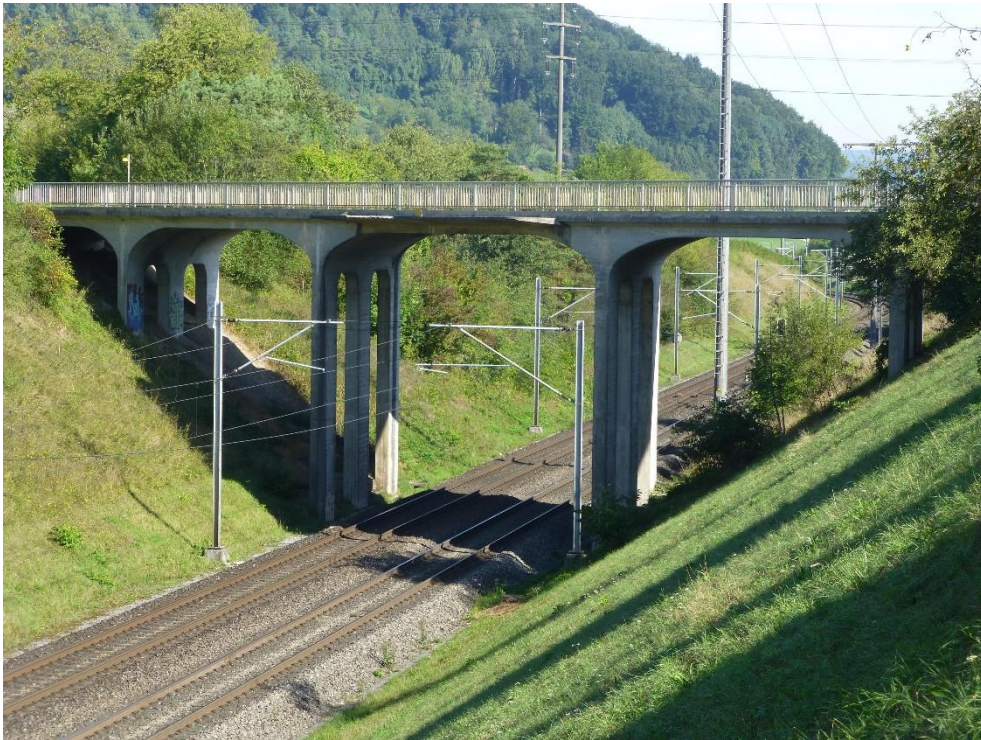
Bahnüberführung, Ansicht von SO, 28.08.2015 (Bild Nr. D100576_11).
