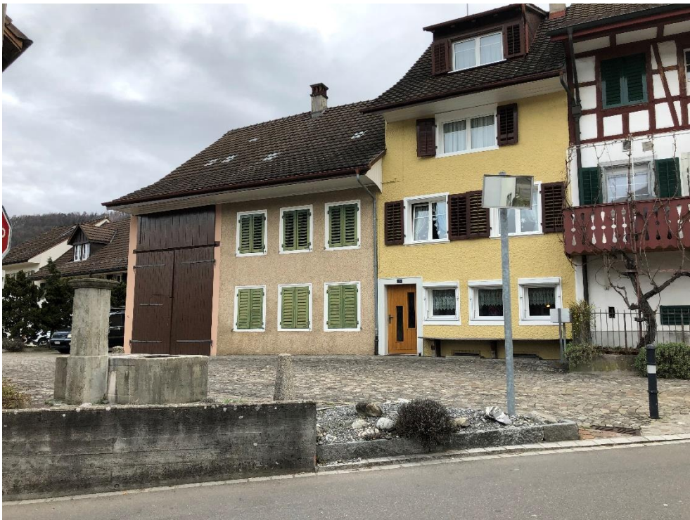
Wohnhaus mit Ökonomieteil, linkes Gebäude der Häuserzeile Gupfe, Ansicht von SW, 24.02.2020 (Bild Nr. D100566_36).
