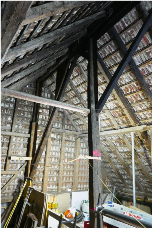
Ehem. Vielzweckbauernhaus, Ökonomieteil mit Hochstudkonstruktion, Ansicht von O, 16.11.2016 (Bild Nr. D100560_27).
