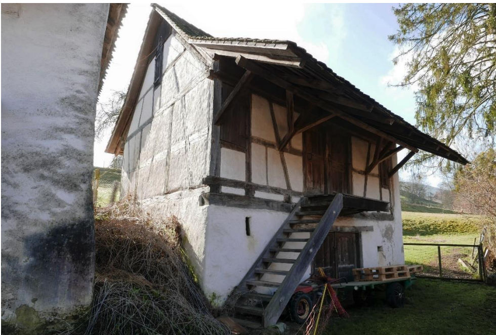
Speicherensemble, Speicher «Schütz» (Vers. Nr. 00088), Ansicht von NO, 10.03.2017 (Bild Nr. D100570_73)
