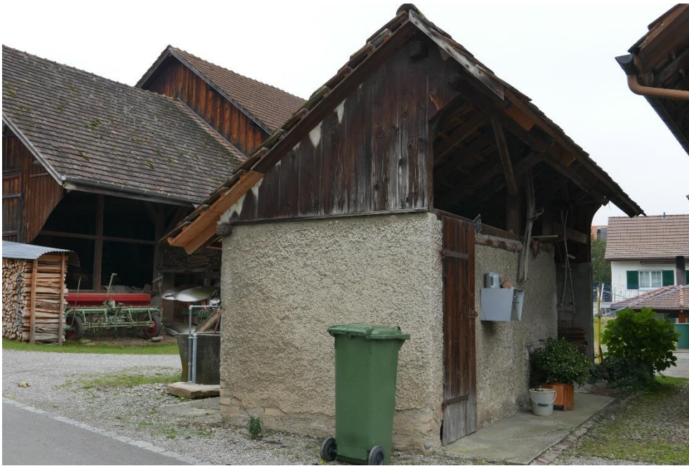
Vielzweckbauernhaus mit Nebengebäuden, Schweinestall (Vers. Nr. 00439), Ansicht von SO, 31.10.2016 (Bild Nr. D100562_45).
