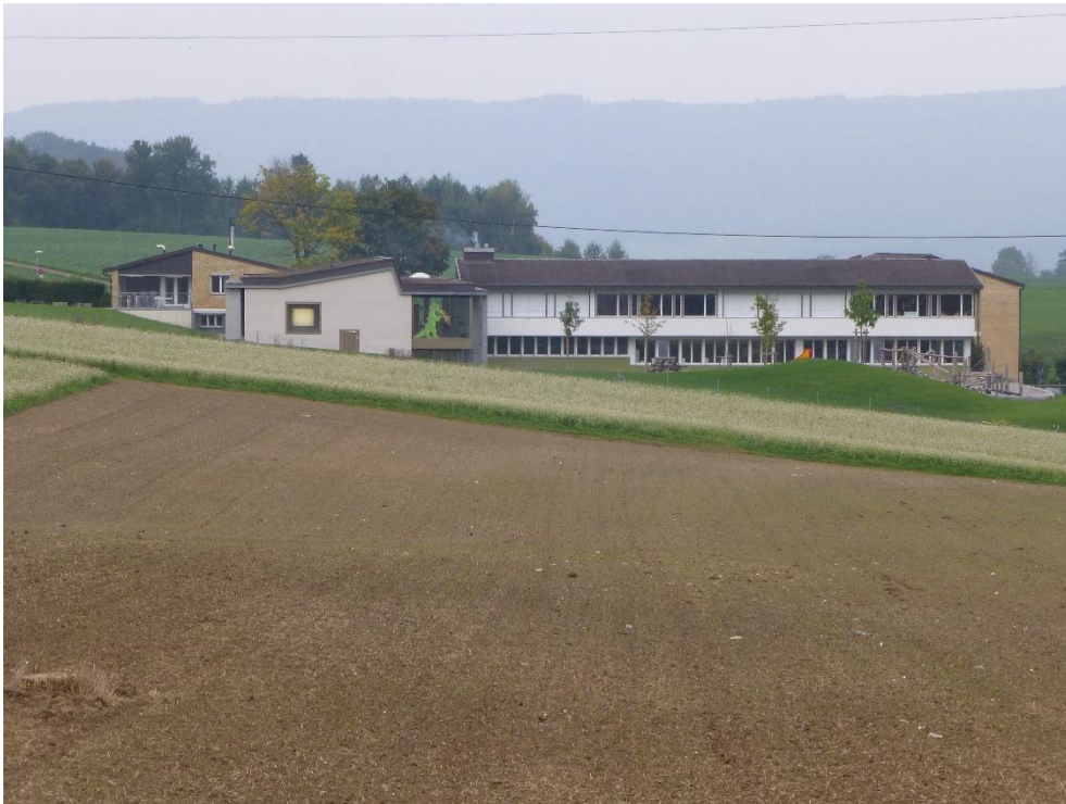
Schulanlage Im Gsteig, Abwartswohnhaus (063BEI00201), Erweiterungsbau Marchlen (063ERWEITERUNG00201), Klassentrakt (Vers. Nr. 00201), Ansicht von S, 01.10.2013 (Bild Nr. D100554_10).
