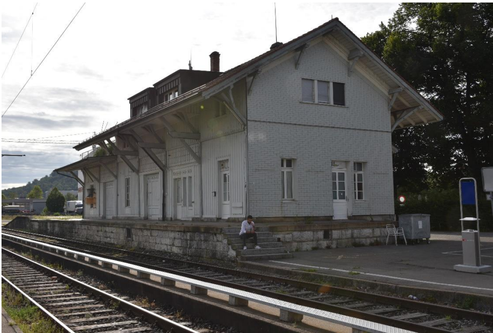
Bahnhof Embrach-Rorbas, Güterschuppen (Vers. Nr. 01355), Ansicht von NW, 24.08.2020 (Bild Nr. D100553_72).
