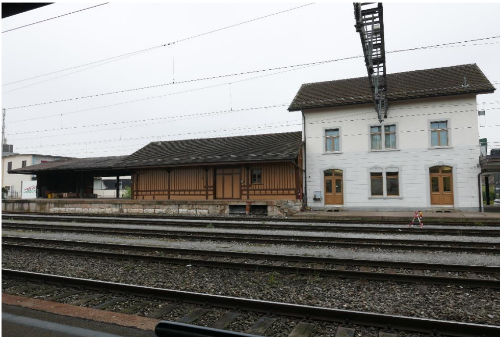
Bahnhof Niederglatt, Ansicht von O, 31.10.2016 (Bild Nr. D100561_71).
