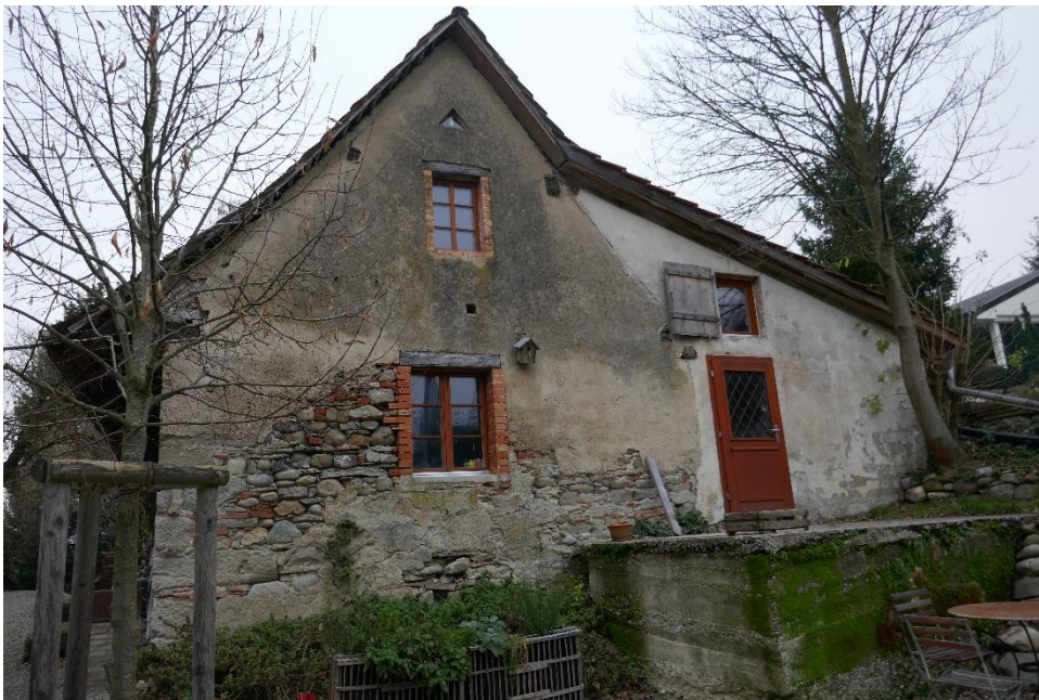
Hof Gstein, Waschhaus (Vers. Nr. 00114), Ansicht von S, 05.12.2019 (Bild Nr. D101355_68).
