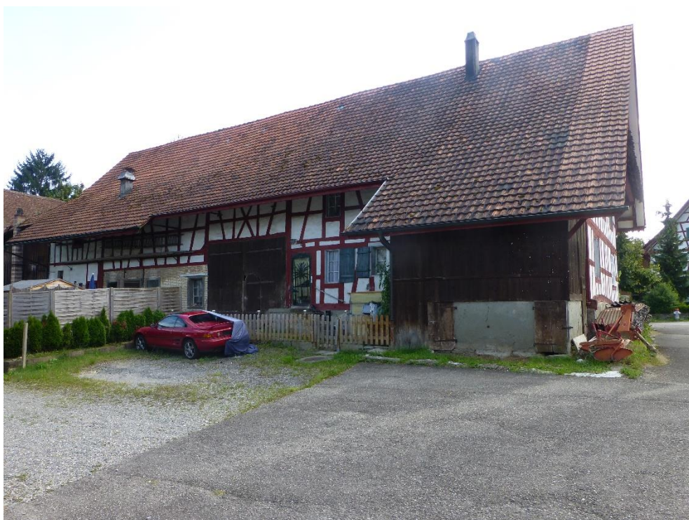
Bauernhaus «Scheibli», rechts vorne Schweinstallanbau mit Holzschoopf, Ansicht von NO, 19.08.2014 (Bild Nr. D100570_15).
