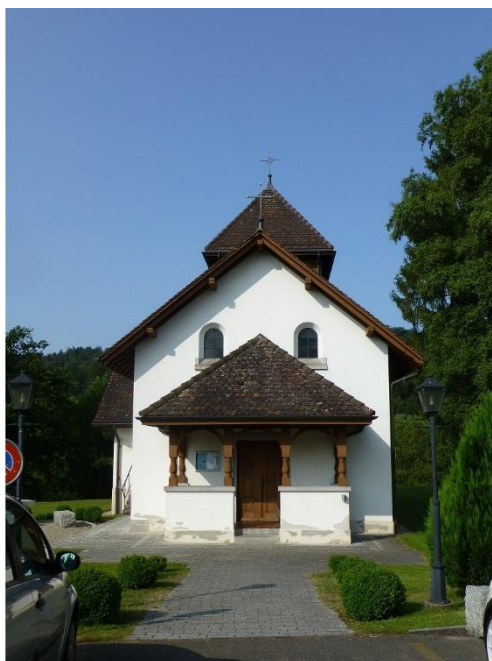
Kath. Kirche St. Petrus, Ansicht von NO, 12.07.2013 (Bild Nr. D100563_32)
