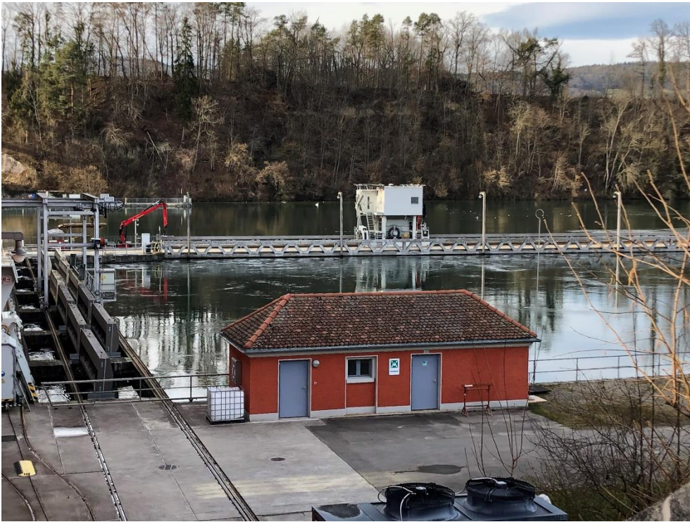
Kraftwerk Eglisau, ehem. Feuerwehrgeräte-lokal (Vers. Nr. 01659), Ansicht von S, 22.02.2020 (Bild Nr. D100567_21).
