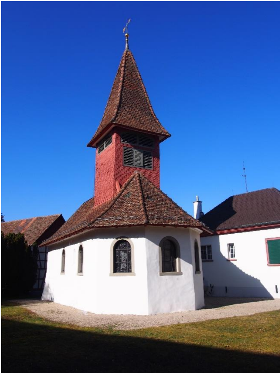
Ref. Filialkirche, Ansicht von SO, 01.03.2019 (Bild Nr. D101366_11).
