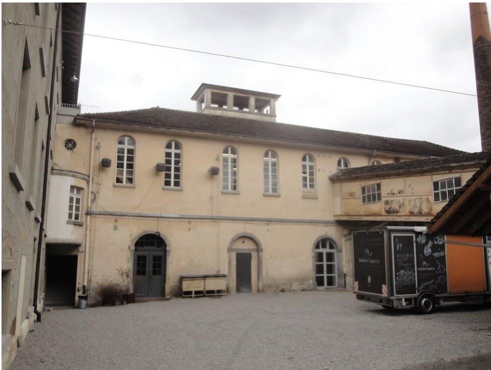
Ehem. Spinnerei Blumer, Fabrikanlage, Vorwerk II mit Staubturm (057VORWII00027), links Vorwerk I (057VORWI00027), rechts Passerelle Südost (057PASSERELLESO00027), Ansicht von S, 12.03.2020 (Bild Nr. D100681_36).
