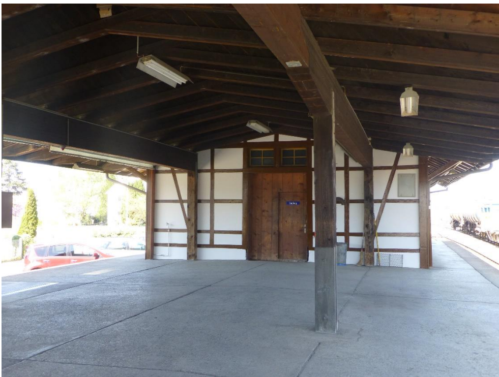
Bahnhof Niederglatt, Güterschuppen (089BEI00778), Ansicht von S, 31.10.2016 (Bild Nr. D100565_55).
