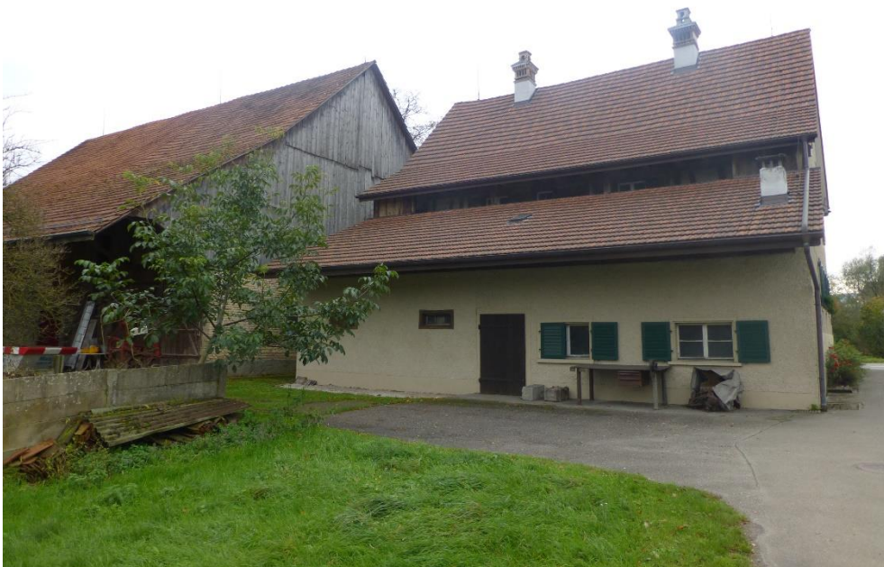
Bauernwohnhaus mit Scheune, Ansicht von NO, 23.10.2014 (Bild Nr. D100571_28).
