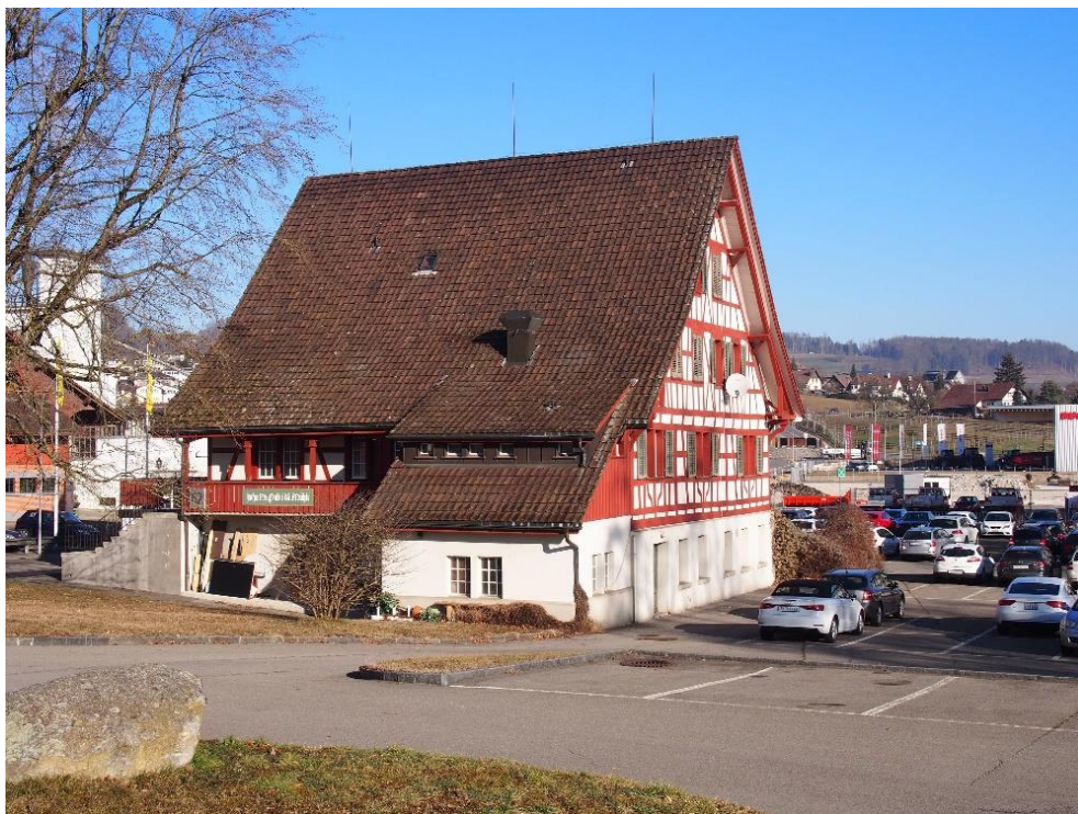
Ehem. Murzlenmühle, Ansicht von SO, 19.02.2019 (Bild Nr. D100596_27).
