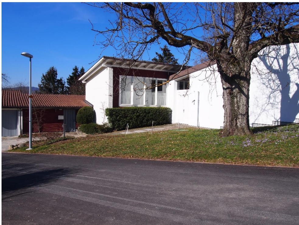
Atelierhaus Sigg, Eingangssituation, Ansicht von O 25.02.2019 (Bild Nr. D101351_84).
