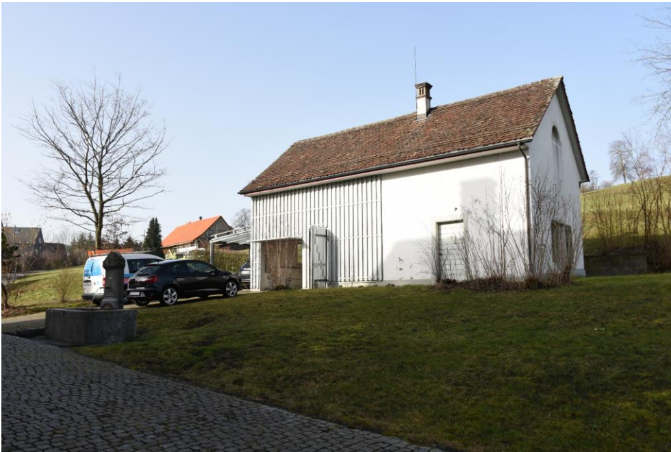
«Schloss», Waschhaus (Vers. Nr. 00013) und Pfarrhausbrunnen (063BRUNNEN00002), Ansicht von NO, 23.02.2021 (Bild Nr. D100591_21).
