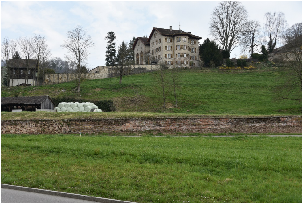
Schloss Teufen, Altes Schloss mit westl. Terrassengarten (057PARK00380b) und Südflügel (Vers. Nr. 00372), ganz links ehem. Tonmühle (Vers. Nr. 00370), Ansicht von SW, 20.03.2020 (Bild Nr. D100598_04).
