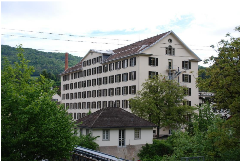
Ehem. Spinnerei Blumer, Fabrikanlage, Spinnerei (057SPINNEREI00027), im Vordergrund das Portierhaus (Vers. Nr. 00021), Ansicht von SW, 09.05.2014 (Bild Nr. D100828_09).
