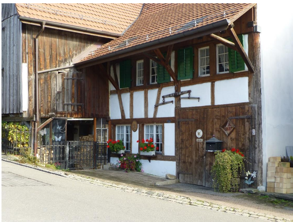
Ehem. Kleinbauernhaus, Ansicht von SW, 24.10.2013 (Bild Nr. D100566_53).
