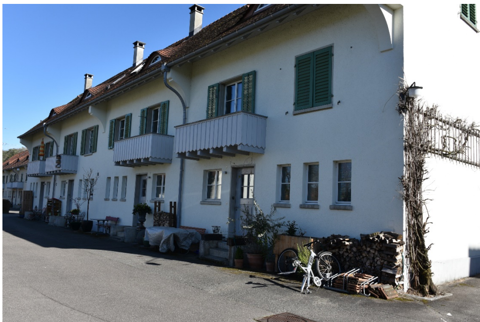
Kraftwerk Eglisau, Wohnkolonie für Angestellte, Reihenwohnhaus 1 (Vers. Nr. 01618), Ansicht von NW, 13.03.2020 (Bild Nr. D100575_47).
