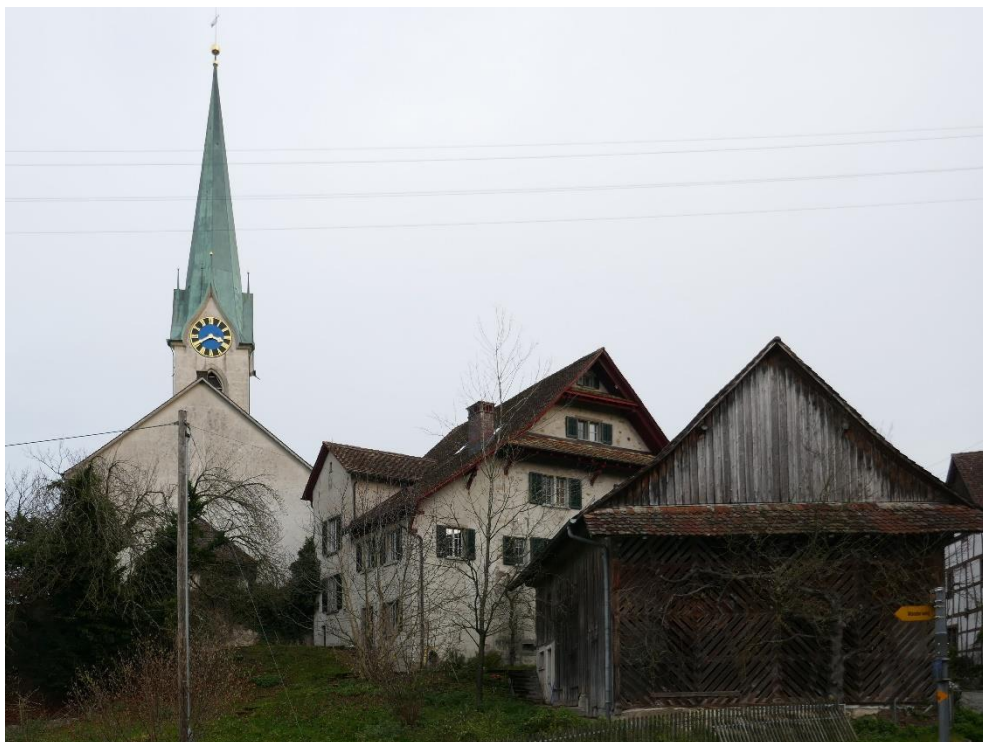
Kirchenbezirk, Ansicht von W, von links nach rechts die ref. Kirche (Vers. Nr. 00436), das Pfarrhaus (Vers. Nr. 00137) und die Scheune (Vers. Nr. 00138), 18.02.2019 (Bild Nr. D101358_79).
