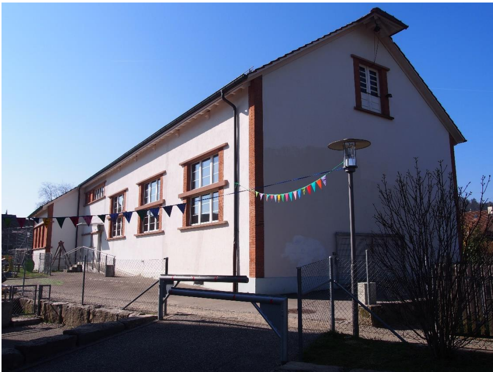
Ehem. Sekundarschulhaus mit Turnhalle, Ansicht von NO, 22.03.2019 (Bild Nr. D101364_06).
