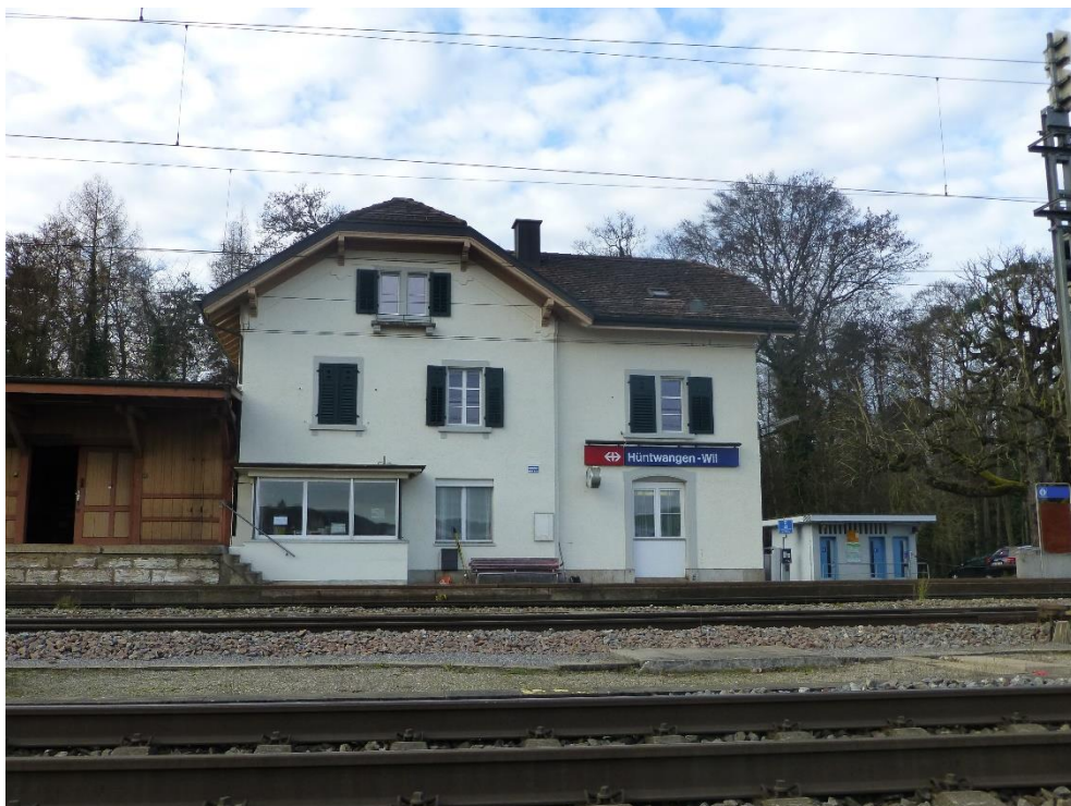
Bahnhof Hüntwangen-Wil, Aufnahmegebäude mit Güterschuppen, Ansicht von O, 12.12.2014 (Bild Nr. D100573_96).
