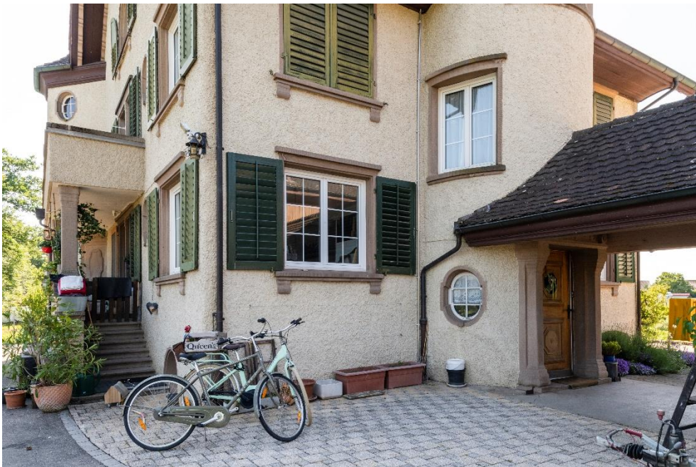
Aussiedlerhof «Rhihof», Bauernwohnhaus (Vers. Nr. 01607), Eingangssituation, Ansicht von NW, 28.05.2020 (Bild Nr. D100561_94).
