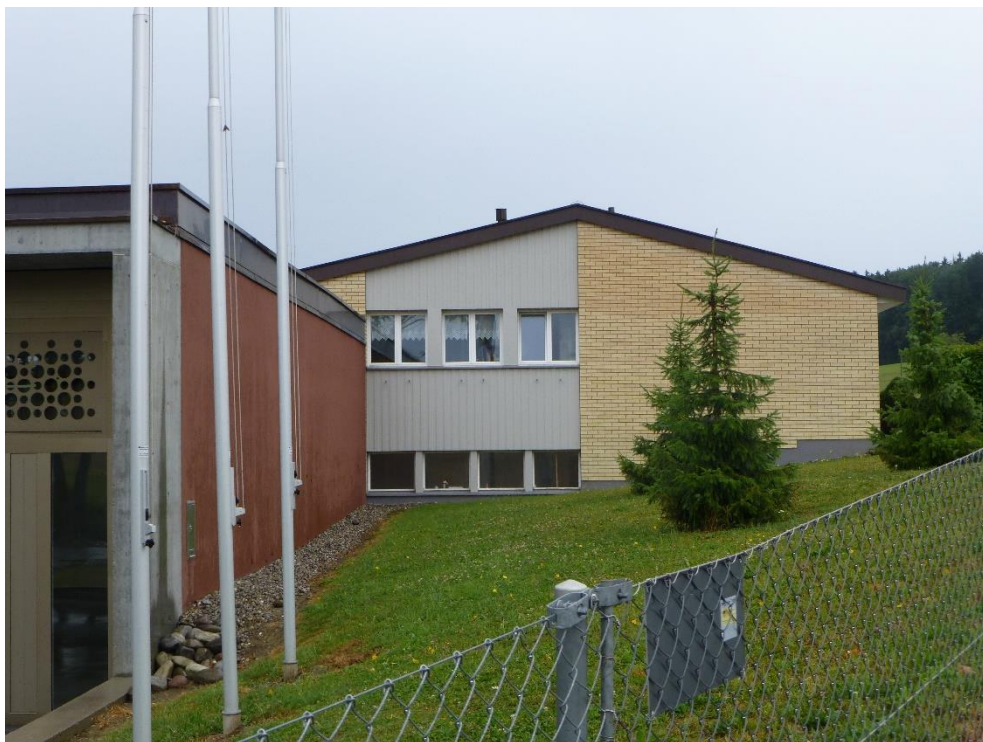
Schulanlage Im Gsteig, Abwartwohnhaus (063BEI00201), Ansicht von N, 29.07.2013 (Bild Nr. D100554_01).
