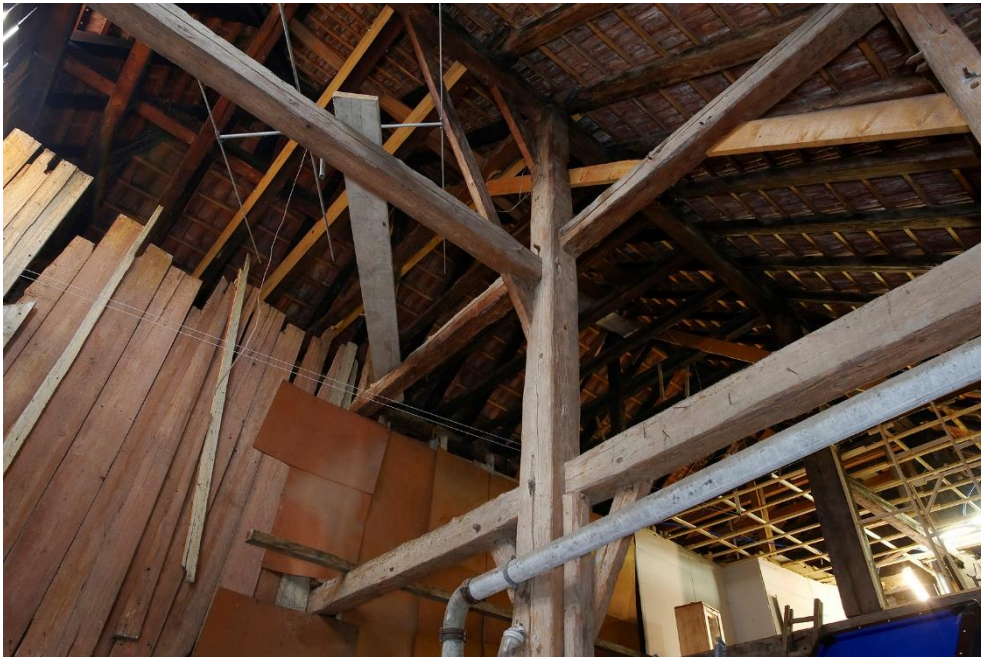
Ehem. Zehntenscheune, Hausteil NO (Vers. Nr. 01242), Ökonomieteil Hochständerkonstruktion, Ansicht von SO, 27.11.2015 (Bild Nr. D100587_46).
