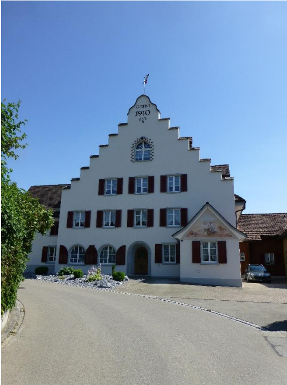
Wohn- und Geschäftshaus «Zum Staffelhof», Ansicht von N, 17.02.2014 (Bild Nr. D100563_21).
