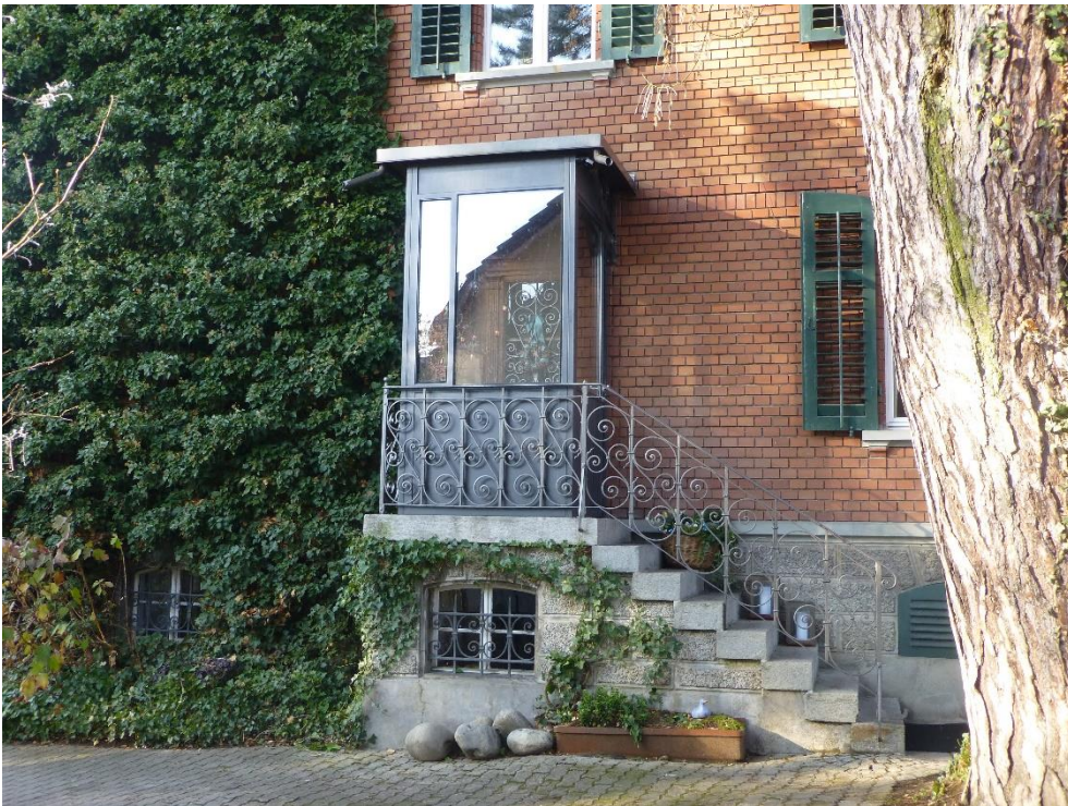
Wohnhaus Steiner mit Nebengebäude, Wohnhaus (Vers. Nr. 001431), Ansicht von SO, 17.12.2013 (Bild Nr. D100563_88).
