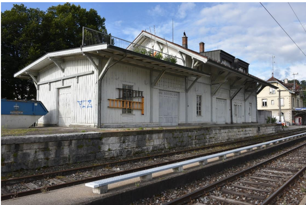
Bahnhof Embrach-Rorbas, Güterschuppen (Vers. Nr. 01355), Ansicht von NO, 24.08.2020 (Bild Nr. D100553_71).
