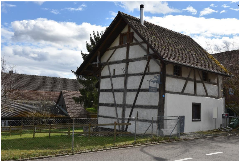
Speicher, Ansicht von NW, 11.03.2020 (Bild Nr. D100571_62).
