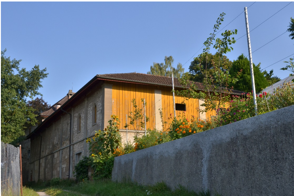
Schloss Teufen, Geräte-/Holzschof (Vers. Nr. 00375), Ansicht von SO, 12.08.2020 (Bild Nr. D100598_27).
