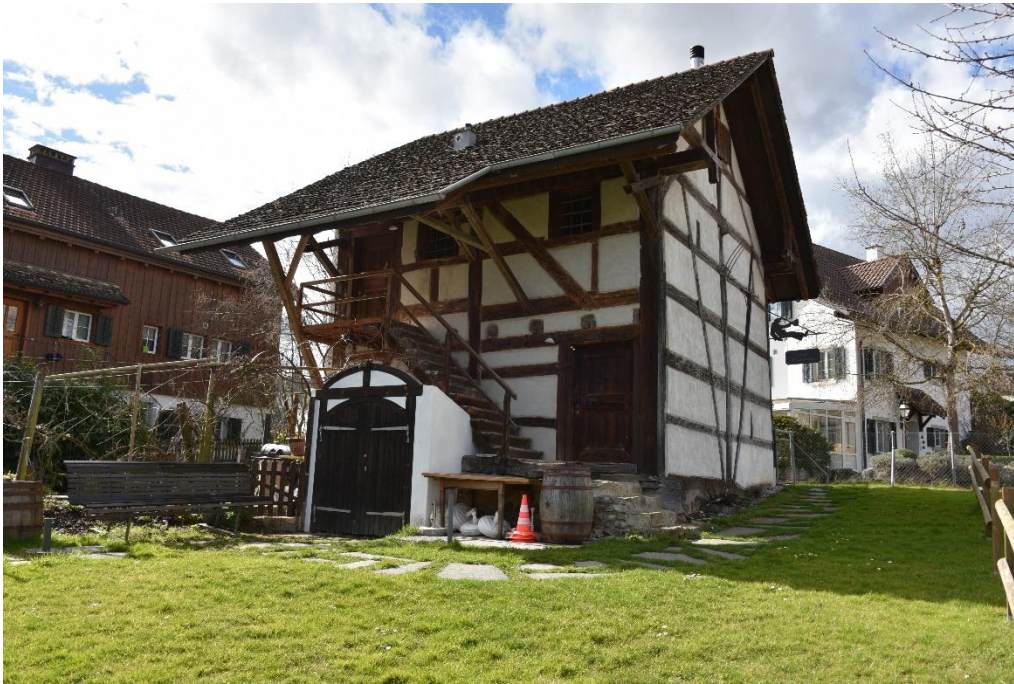
Speicher, Ansicht von NO, 11.03.2020 (Bild Nr. D100571_63).
