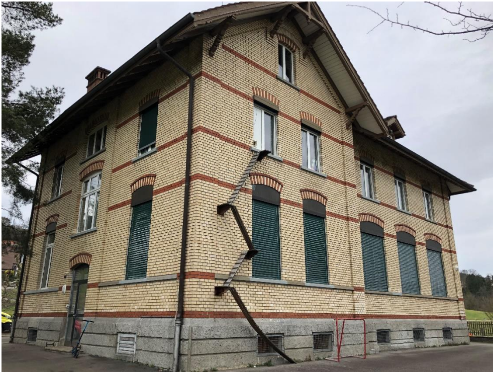
Ehem. Schulhaus Teufen, Ansicht von W, 23.02.2020 (Bild Nr. D100566_82).
