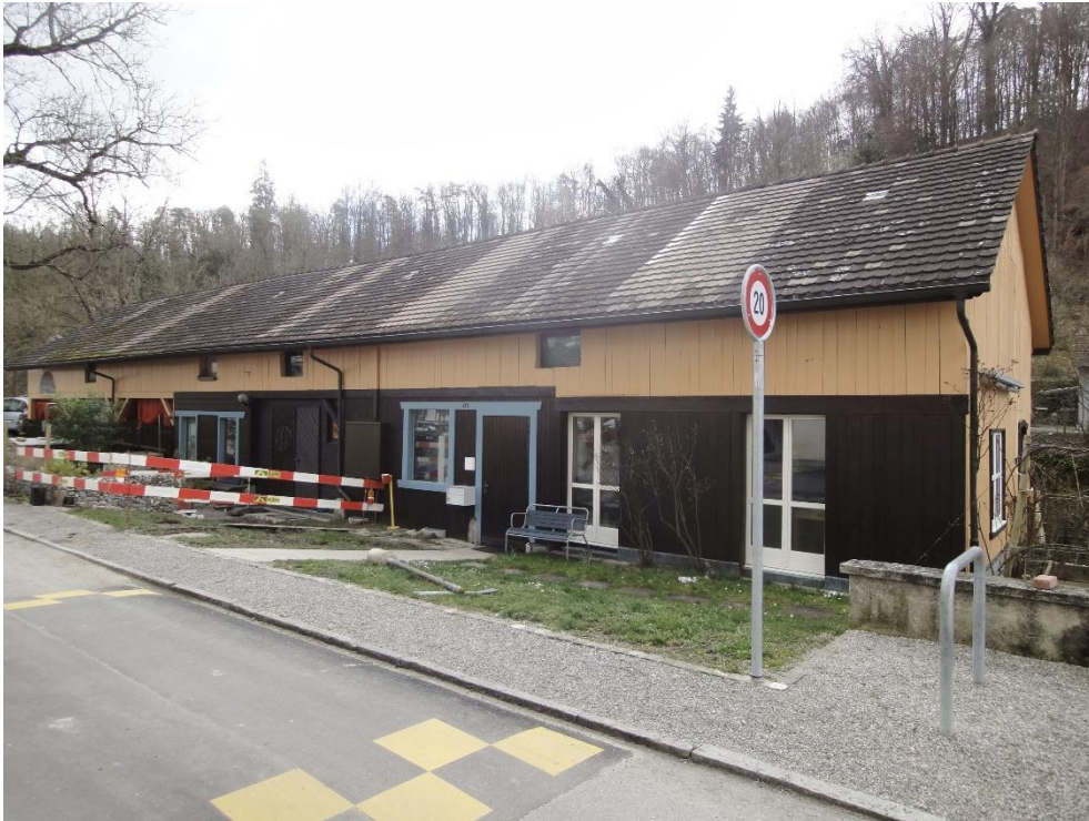
Ehem. Spinnerei Blumer, Fabrikanlage, Bretterschopf (Vers. Nr. 00020), Ansicht von NW, 12.03.2020 (Bild Nr. D100681_55).
