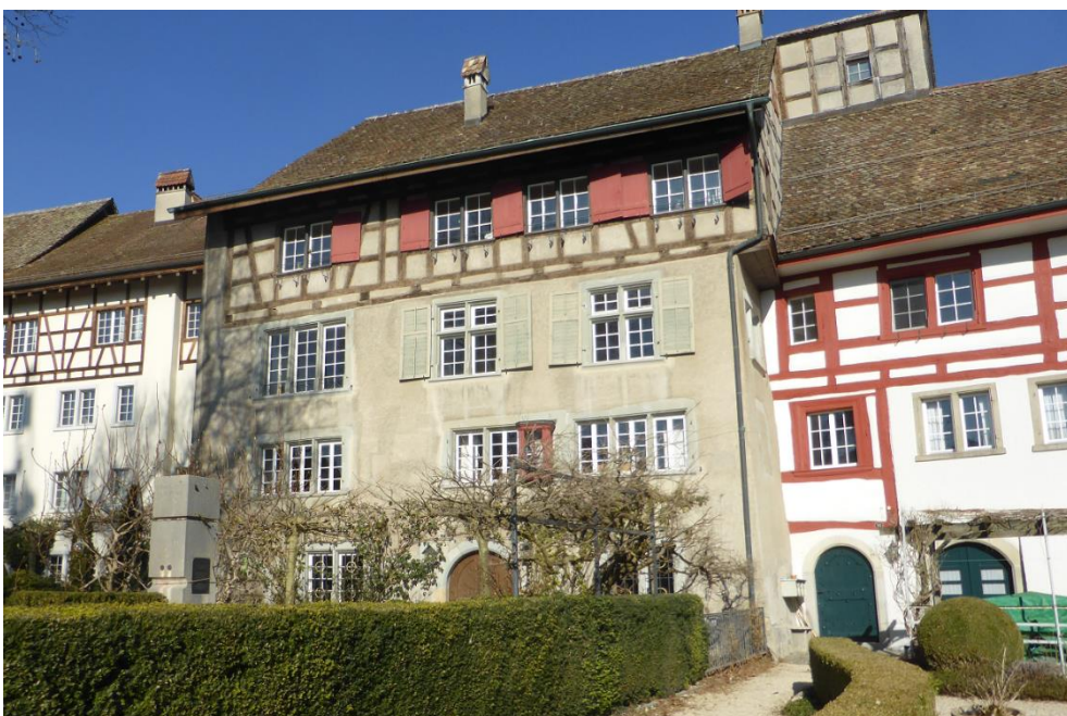
«Engelfridhaus», Ansicht von SO, 28.02.2019 (Bild Nr. D101397_34).
