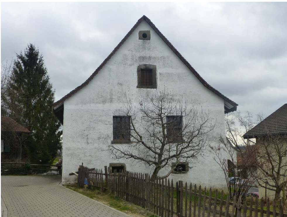
Speicher, Ansicht von W, 13.02.2014 (Bild Nr. D100553_03).
