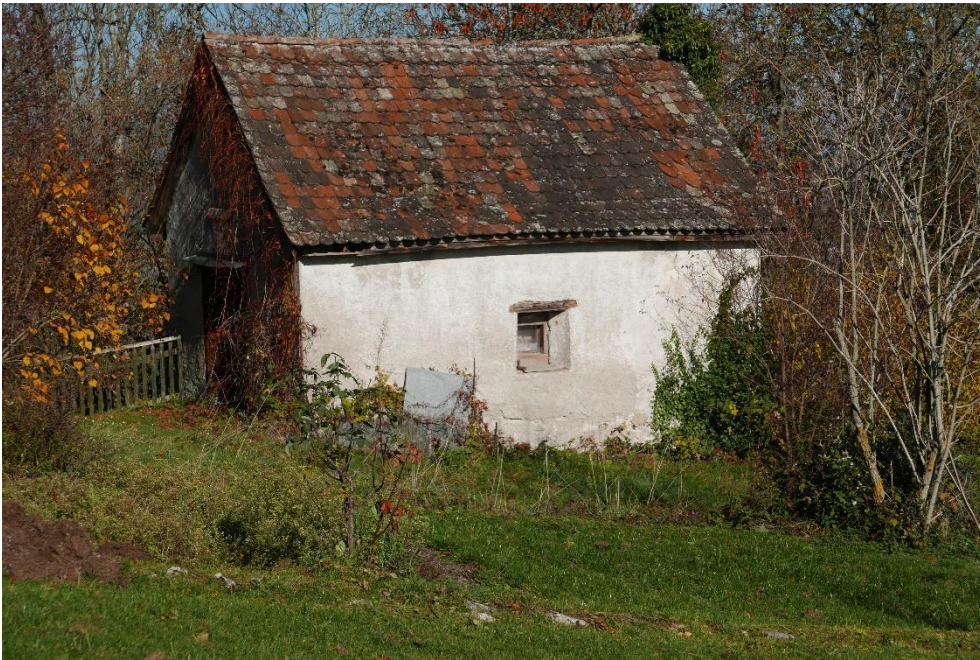
Kanonenhäuschen, Ansicht von S, 01.11.2015 (Bild Nr. D101106_05).
