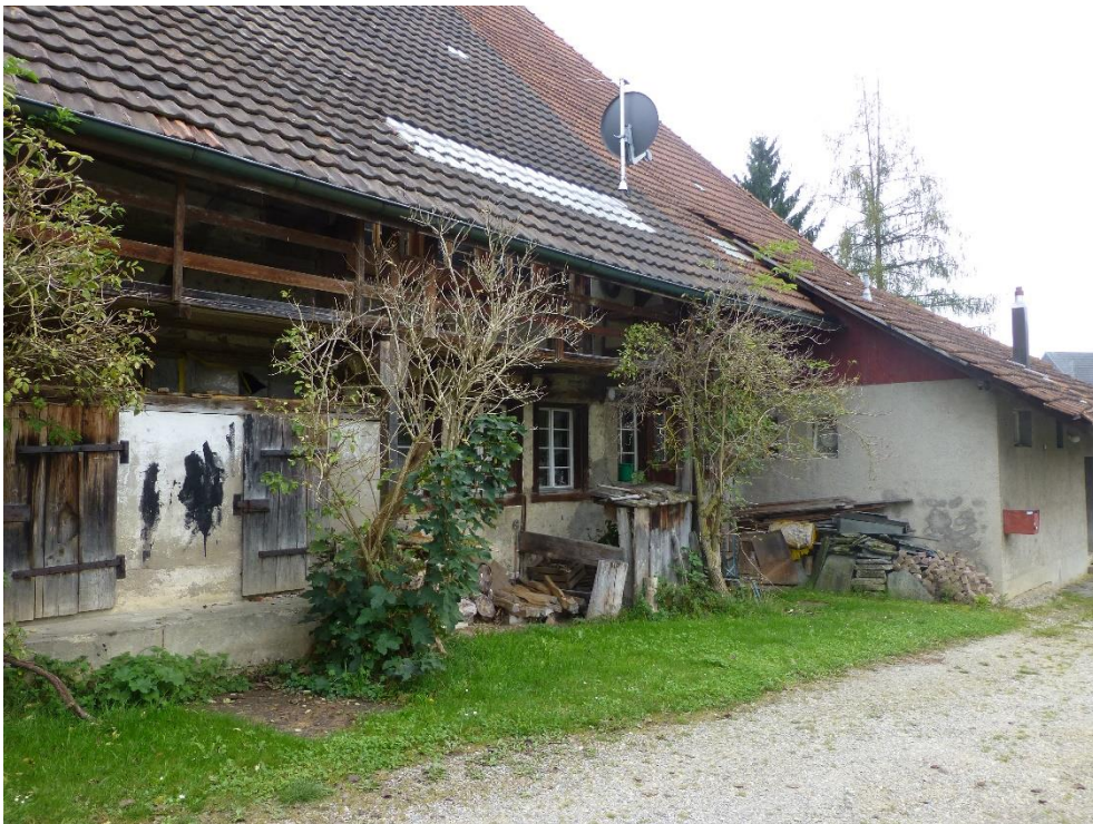
Vielzweckbauernhaus, Westfassade mit Hausteil 2 (Vers. Nr. 00388), Ansicht von NW, 03.10.2014 (Bild Nr. D100559_54).
