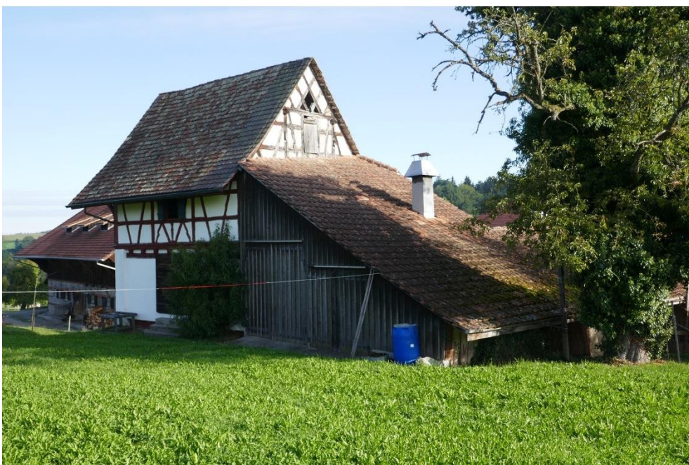
Speicher, Ansicht von SW, 17.09.2019 (Bild Nr. D101088_74).
