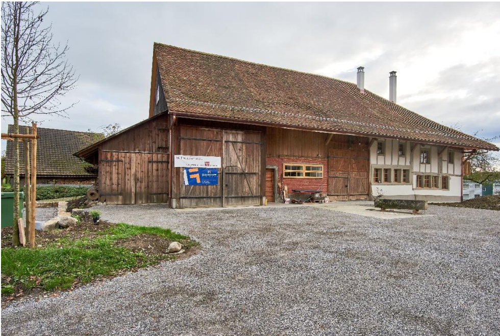
Vielzweckbauernhaus, nach dem Umbau 2019, Ansicht von NO, 13.11.2019 (Bild Nr. D100990_91).
