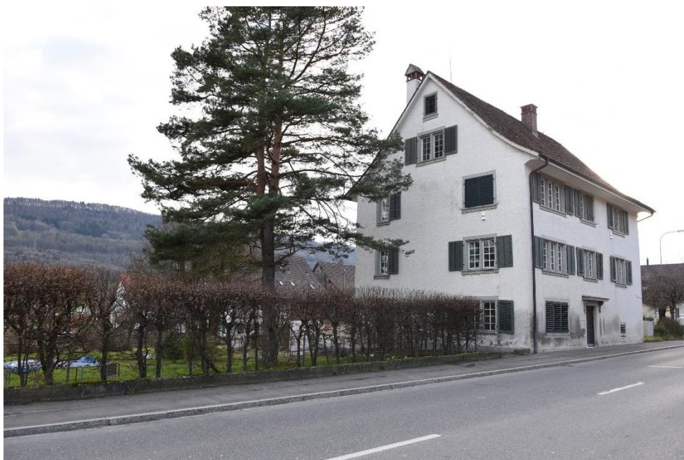
Ref. Pfarrhaus, Ansicht von NO, 07.03.2020 (Bild Nr. D101367_46).
