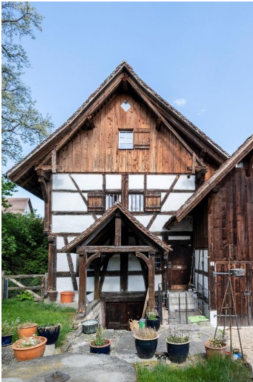
Speicher mit Trotte, Speicher mit vorgelagertem Kellerabgang, Ansicht von SO, 24.04.2020 (Bild Nr. D101367_02).
