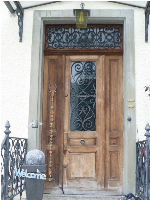
Villa Blumer mit Stallscheune und Park, Eingangstür der Villa (Vers. Nr. 00453), Ansicht von NW, 01.10.2013 (Bild Nr. D100557_14).
