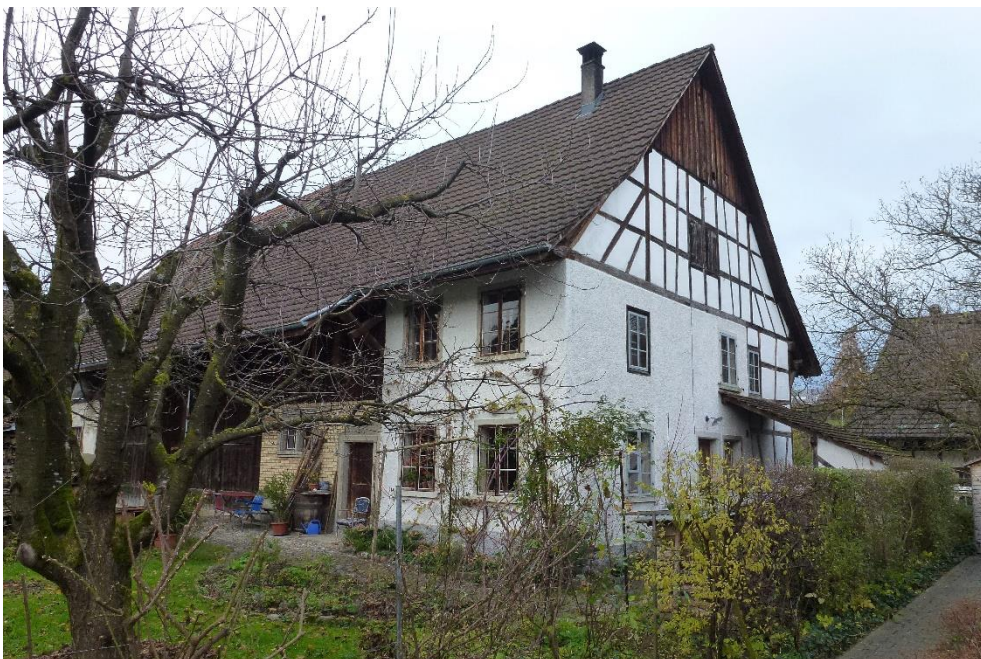
Vielzweckbauernhaus, östlicher Hausteil (Sägestrasse 7b), Ansicht von SO, 28.11.2014 (Bild Nr. D100580_35).
