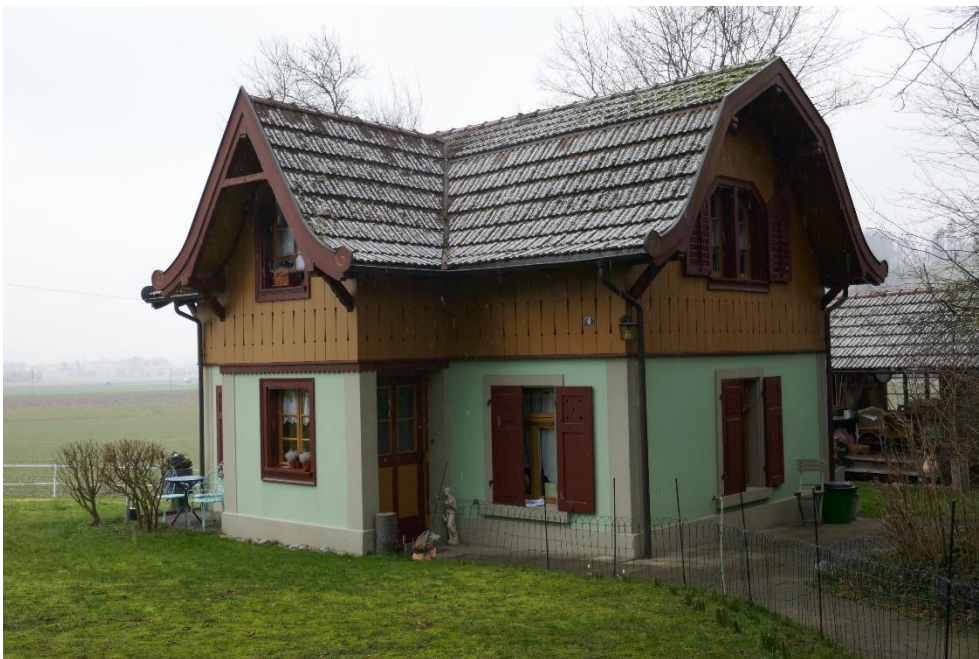
Ensemble Villa «Tusculum», Waschhaus (Vers. Nr. 00097), Ansicht von SO, 07.02.2018 (Bild Nr. D101366_49).
