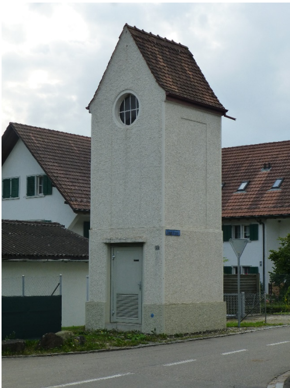
Transformatorstation «Dorf», Ansicht von NO, 17.02.2014 (Bild Nr. D100551_01).
