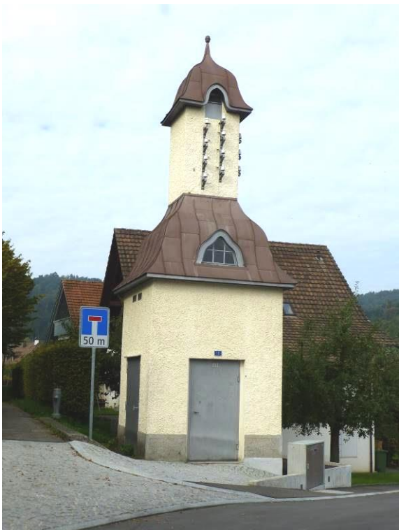
Transformatorstation «Dorf», Ansicht von NO, 26.09.2014 (Bild Nr. D100559_21).
