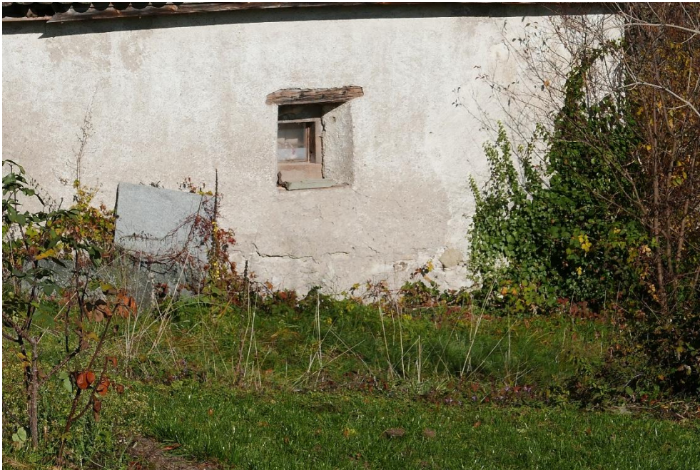
Kanonenhäuschen, Ansicht von S, 01.11.2015 (Bild Nr. D101106_06).
