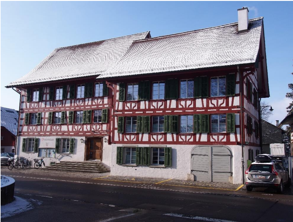
Gemeindehaus, Ansicht von NO, 04.02.2019 (Bild Nr. D100596_11).
