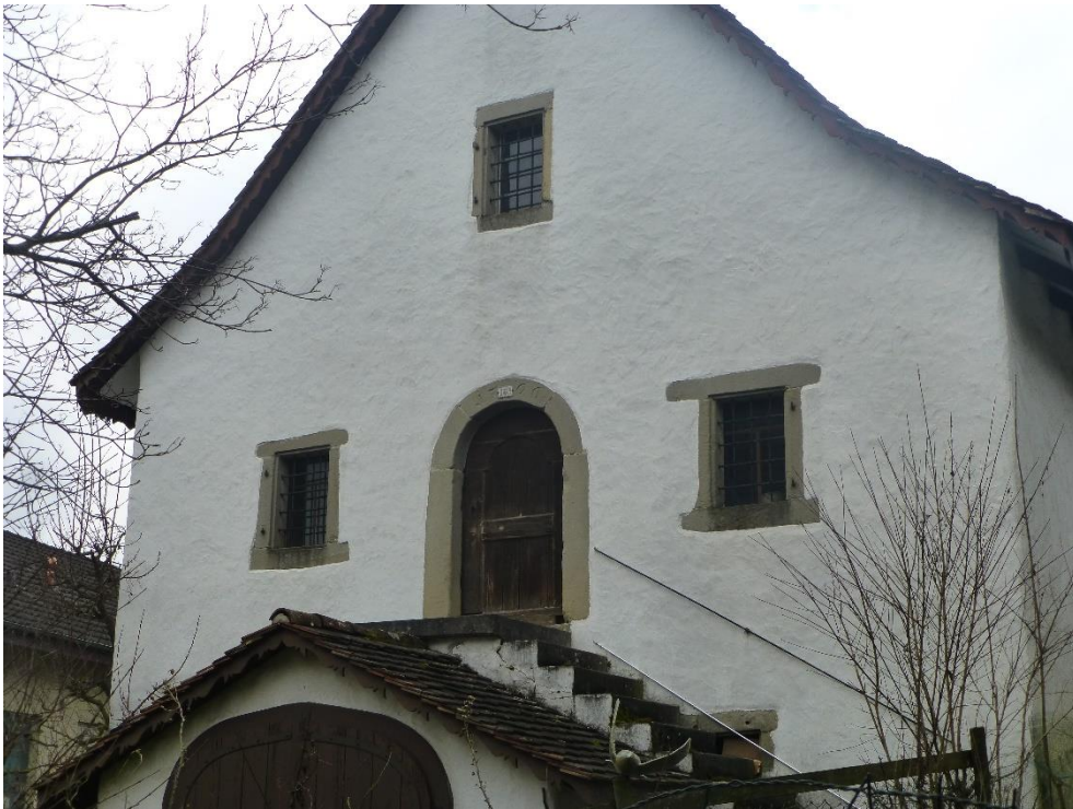
Speicher, Ansicht von O, 13.02.2014 (Bild Nr. D100553_05).
