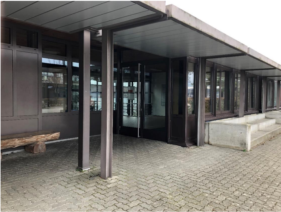
Schulanlage Schalmenacker, Schulhaus Eingang (Vers. Nr. 00680), Ansicht von NO, 23.02.2020 (Bild Nr. D100577_62).
