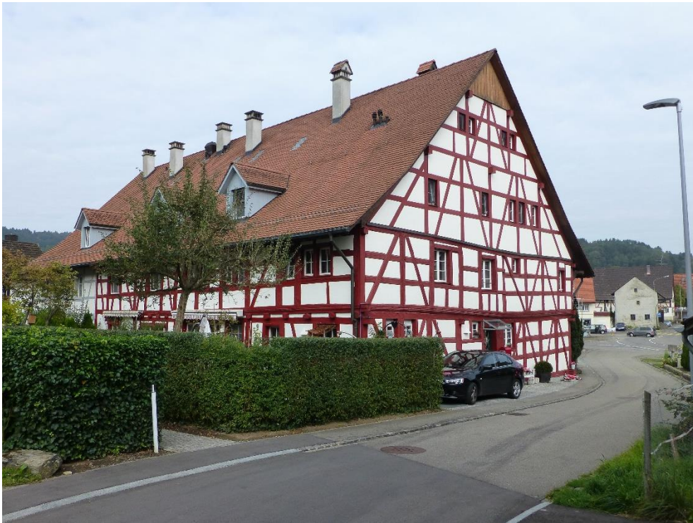
Ehem. Vielzweckbauernhaus, Ansicht von SO, 26.09.2014 (Bild Nr. D100559_31).
