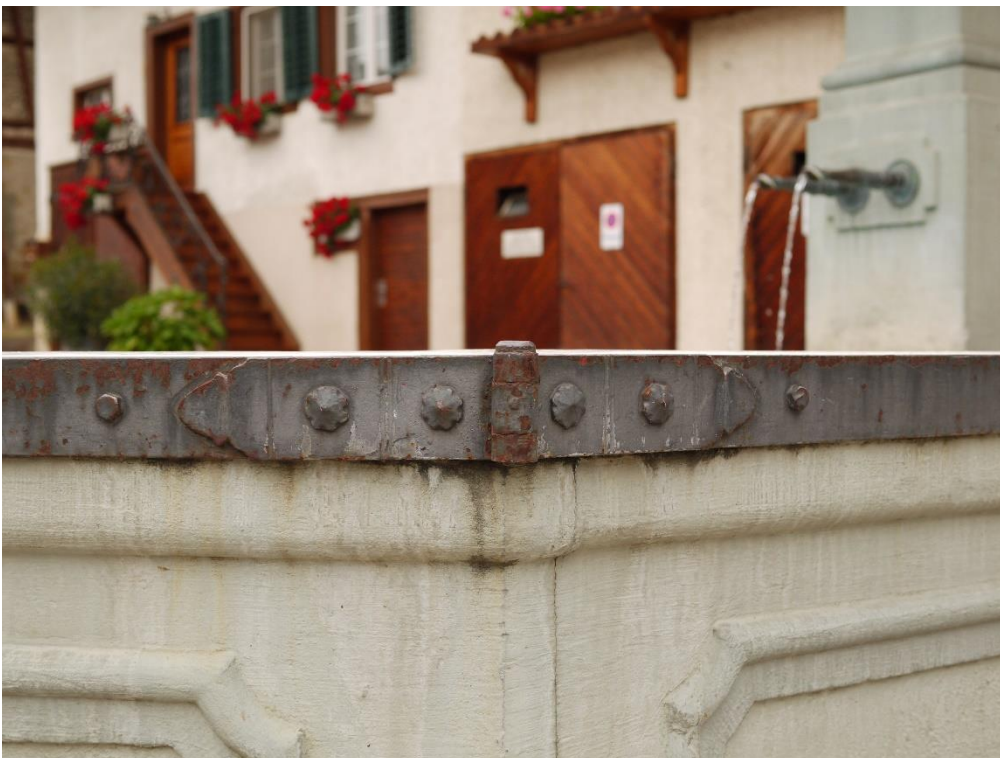
Dorf- oder Breitenbrunnen, Flacheisenband mit Scharnieren und Nietenköpfen, 27.06.2013 (Bild Nr. D100572_02).
