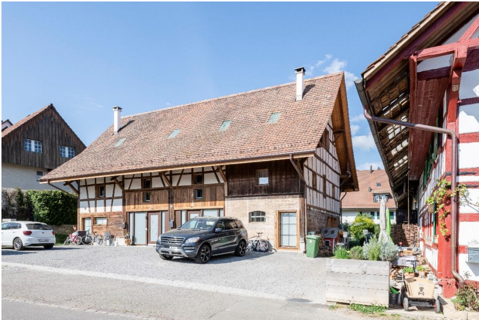
Sog. «Schellenberghaus» mit Doppelscheune, Doppelscheune (Vers. Nr. 00208, 00485), nach dem Umbau 2018, Ansicht von NO, 24.04.2020 (Bild Nr. D100552_32).
