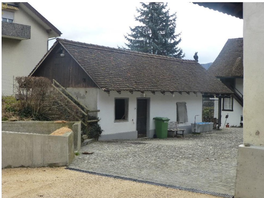
Hofgruppe Hinterdorf, Waschhaus (Vers. Nr. 00153), Ansicht von NW, 12.02.2014 (Bild Nr. D101355_52).
