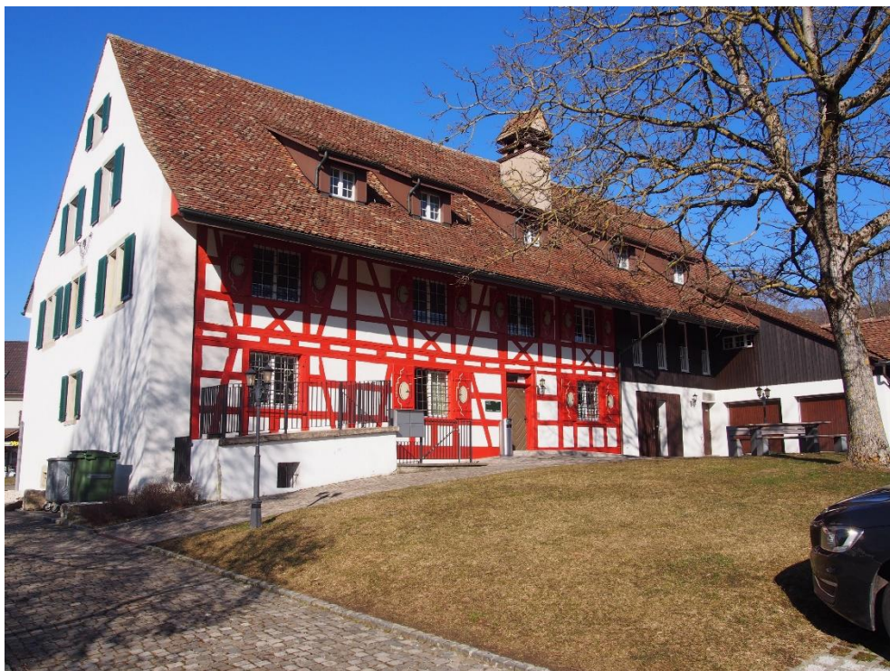
Gemeindezentrum, Gemeindehaus, ehem. Untervogthaus (Vers. Nr. 00108), Ansicht von SO, 18.02.2019 (Bild Nr. D101358_02).
