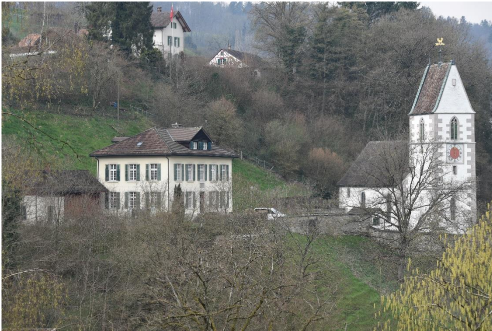
Ref. Pfarrhaus mit Waschhaus, Situation am Hang, Ansicht von O, 20.03.2020 (Bild Nr. D100591_71).
