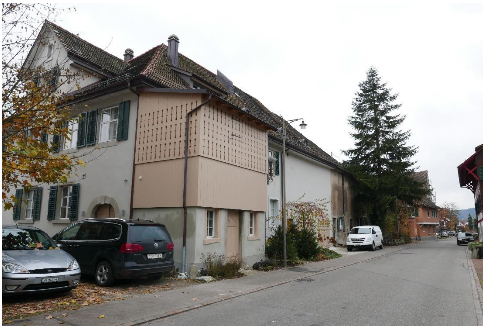
Ehem. Doppelscheune mit Wohnteil, links der Hausteil Ost (Vers. Nr. 00090), Ansicht von NO, 08.11.2016 (Bild Nr. D100577_54).
