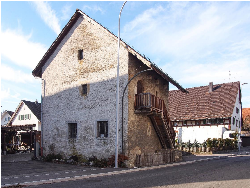
Speicher, sog. «Pulverturm», Ansicht von SO, 28.02.2019 (Bild Nr. D101396_82).
