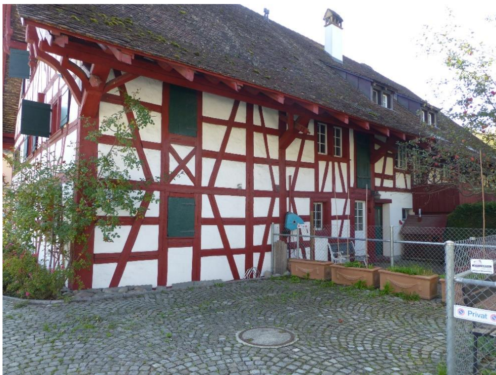
Sog. «Maaghaus» mit Waschhaus, sog. «Maaghaus» mit Wohnteil (Vers. Nr. 00038) und ehem. Ökonometeil (Vers. Nr. 00178), Ansicht von O, 26.09.2014 (Bild Nr. D100559_03).
