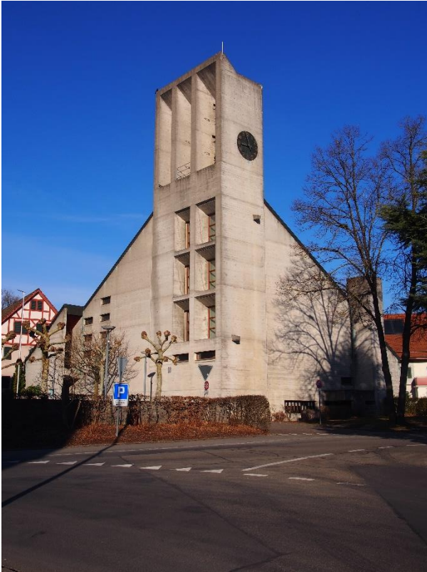
Ref. Kirche, Ansicht von SO, 25.02.2019 (Bild Nr. D100558_18).
