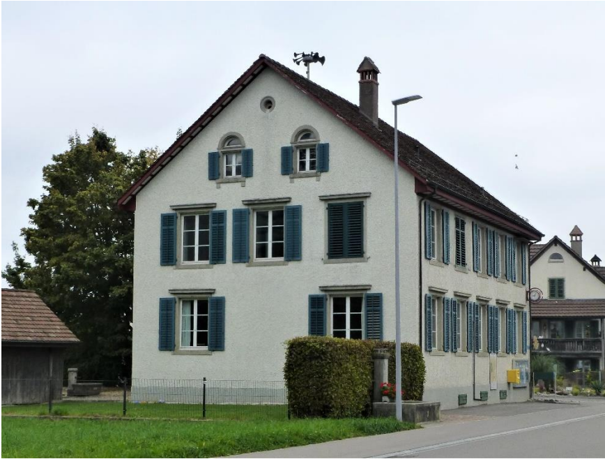
Schulhaus Windlach, Ansicht von S, 13.10.2014 (Bild Nr. D100559_61).
