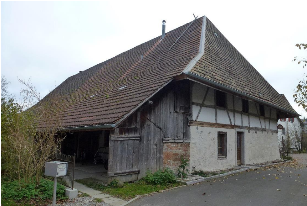
Vielzweckbauernhaus, westlicher Hausteil (Sägestrasse 7a), Ansicht von NW, 28.11.2014 (Bild Nr. D100580_38).
