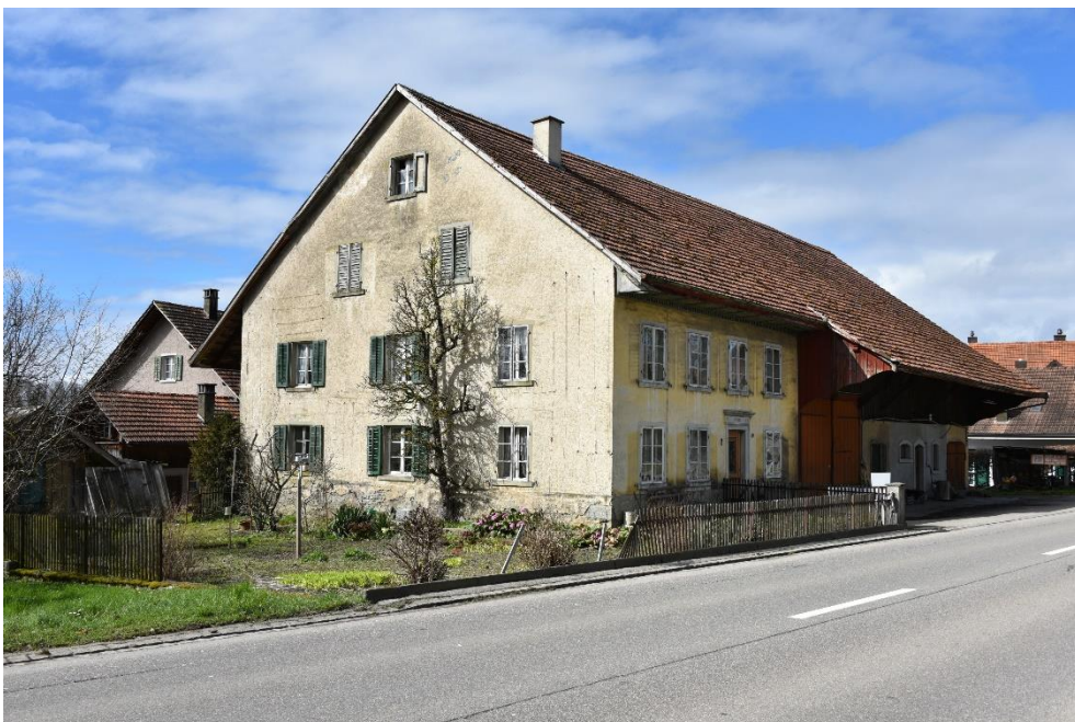
Vielzweckbauernhaus mit Scheune, Vielzweckbauernhaus (Vers. Nr. 00083), Ansicht von SO, 11.03.2020 (Bild Nr. D101097_05).
