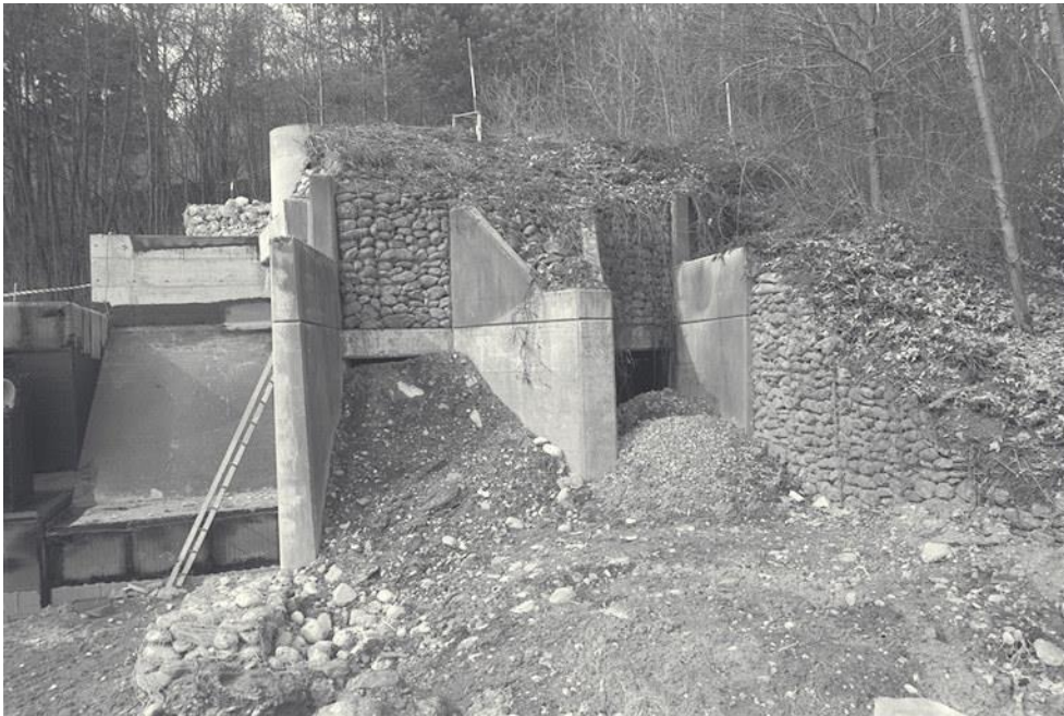
Sperrstelle 0667 Stadel, Infanteriebunker A05359 während des Baus von Centurion-Bunker A05585, links im Bild, 01.01.1995 (Bild Nr. D100682_76).
