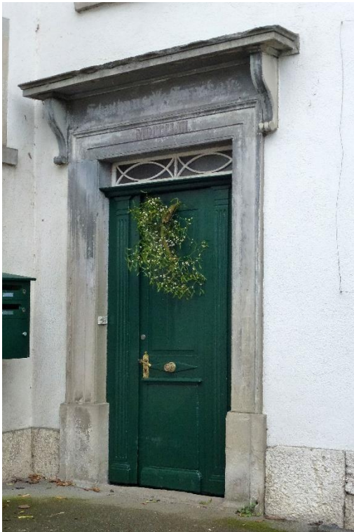
Schulhausensemble, Neues Schulhaus (Vers. Nr. 00506), östliche Giebelfassade, Eingangsportal, 04.12.2014 (Bild Nr. D100580_09).
