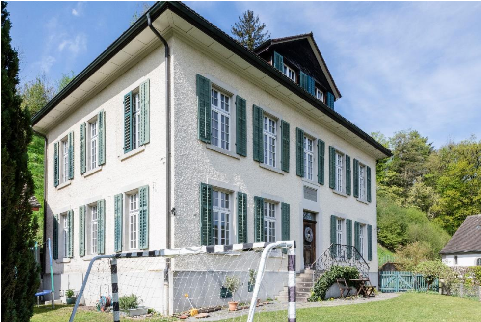
Ref. Pfarrhaus mit Waschhaus, ref. Pfarrhaus (Vers. Nr. 00158), Ansicht von SO, 16.04.2020 (Bild Nr. D101366_72).
