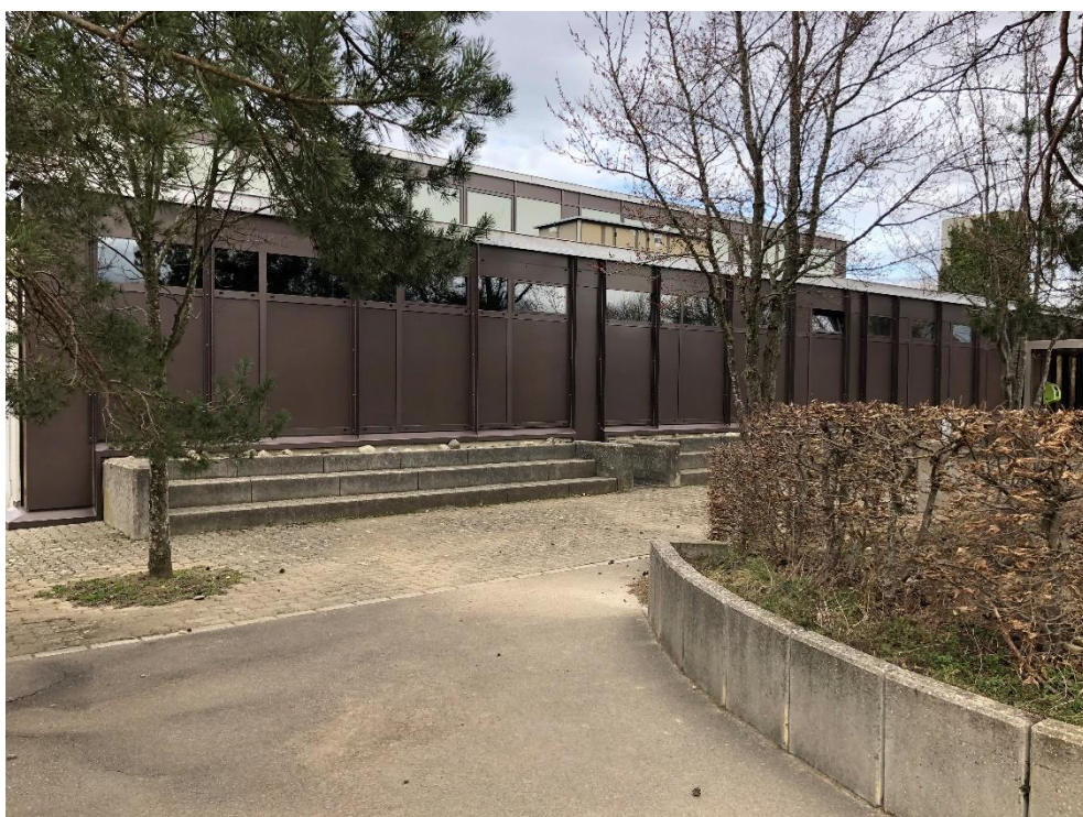
Schulanlage Schalmenacker, Turn- und Schwimmhalle (Vers. Nr. 00682), Ansicht von S, 23.02.2020 (Bild Nr. D100577_69).
