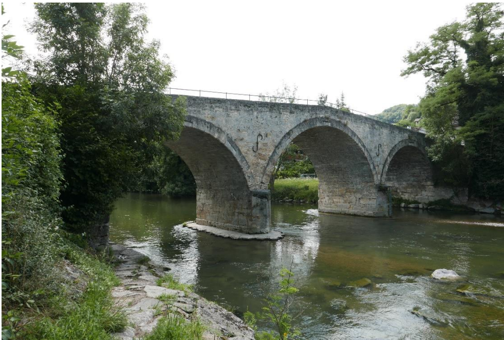
«Römerbrücke», Ansicht von N, 31.07.2017 (Bild Nr. D100557_71).
