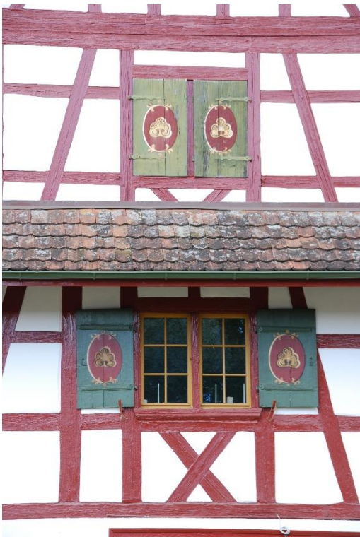
«Rothaus», Detail Giebelfassade, Ansicht von SO, 15.04.2014 (Bild Nr. D100825_20).
