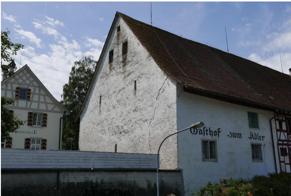
Gasthaus «Adler», Ansicht von NO, 31.07.2017 (Bild Nr. D100557_64).
