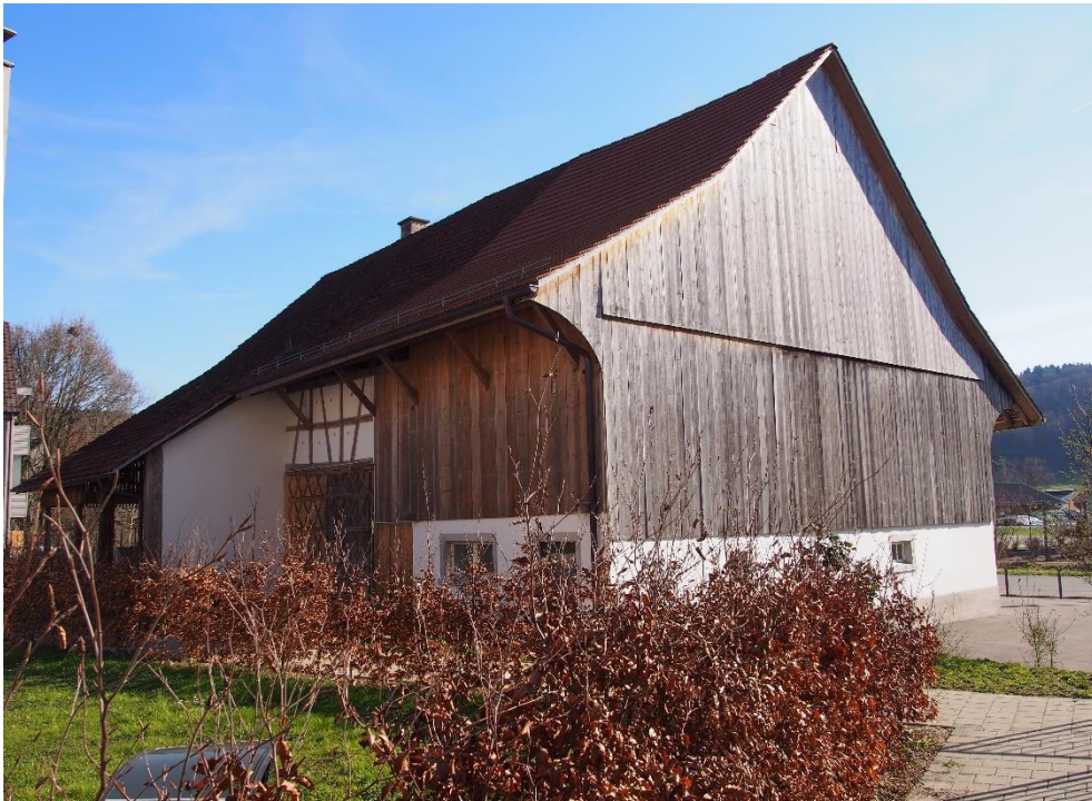
«Rothaus», Ansicht von NW, 21.03.2019 (Bild Nr. D101366_25).
