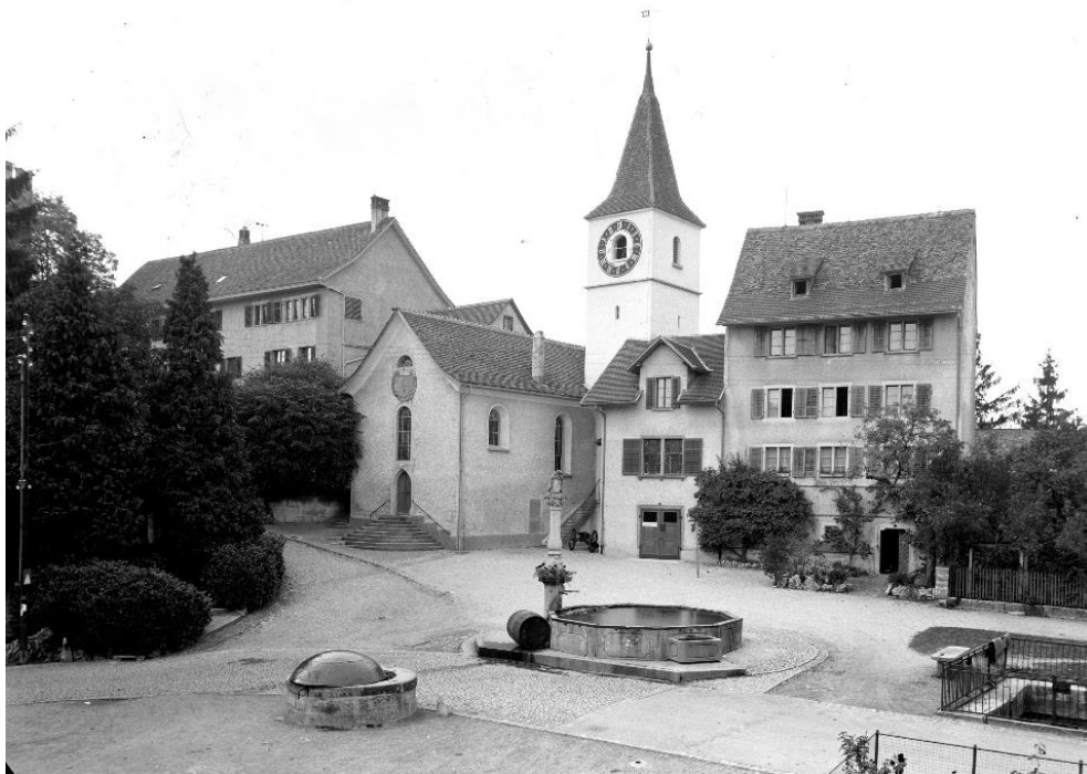
Regensberg, zentraler Platz in der Oberburg mit dem «Galchbrunnen» (095BRUNNEN00002) und dem «Stadtbrunnen» (095BRUNNEN00001), Ansicht von SO; im Hintergrund u. a. die ref. Kirche (Vers. Nr. 00045) und das Pfarrhaus (Vers. Nr. 00043), 13.10.1947 (Bild-Nr. Z23181A).
