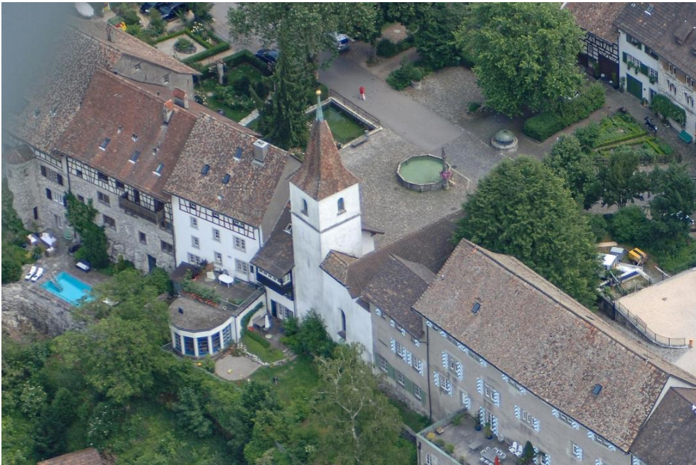
Ref. Kirche, Luftbild von NW, in der Bildmitte der «Stadtbrunnen» (Oberburg 19 bei; 095BRUNNEN00001), 26.06.2006 (Bild Nr. D101397_23).
