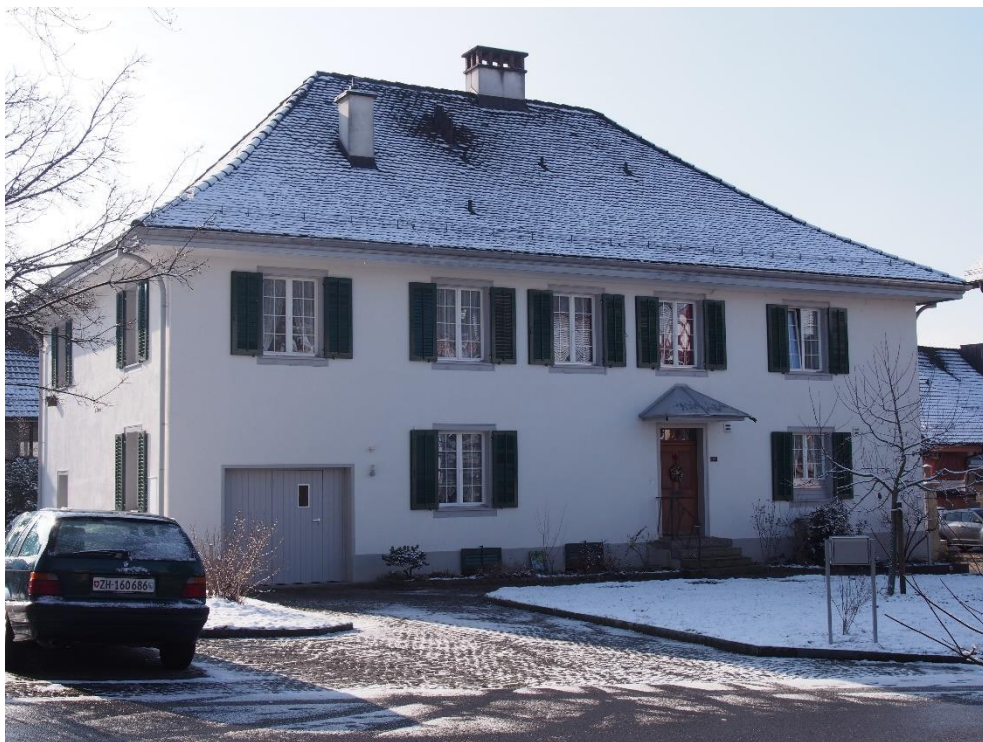
Ref. Pfarrhaus, Ansicht von NO, 07.02.2019 (Bild Nr. D101366_36).
