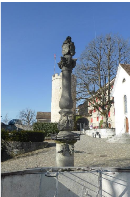
«Stadtbrunnen», Ansicht von O, 28.02.2019 (Bild-Nr. D101396_02).
