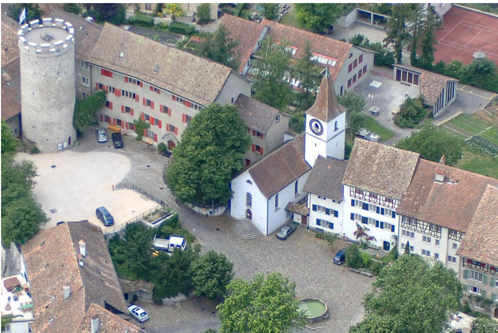
Ref. Kirche, Luftbild von SO, links davon das ehem. Schloss (Oberburg 22; Vers. Nr. 00047) und der Schlossturm (Oberburg 22.1; Vers. Nr. 00049), 26.06.2006 (Bild Nr. D101397_24).
