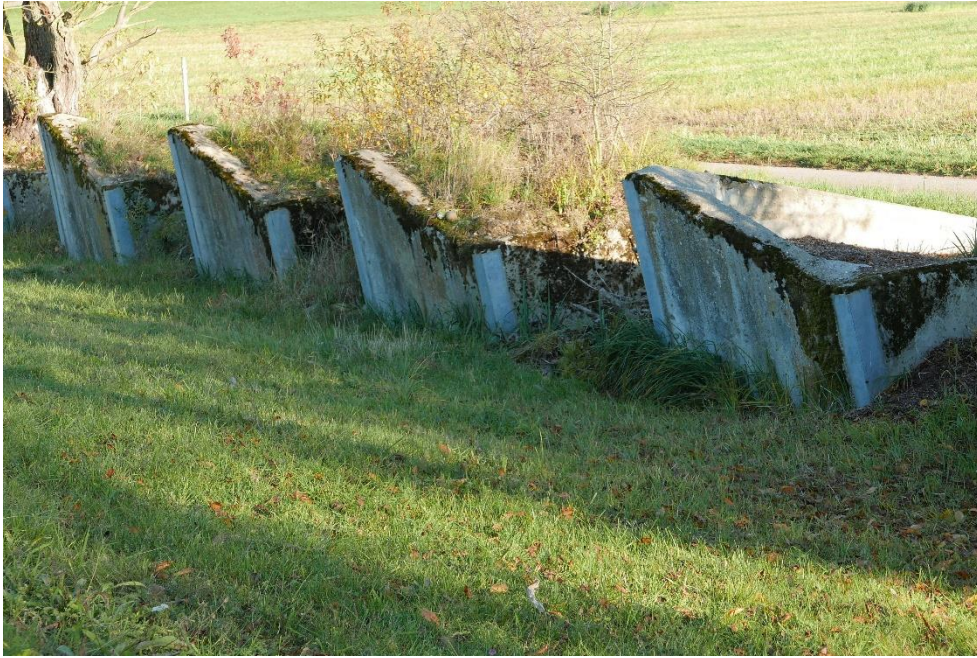
Sperrstelle 0667 Stadel, Panzersperre T02727, Betonblöcke aus den 1980er Jahren, 05.11.2015 (Bild Nr. D100682_95).
