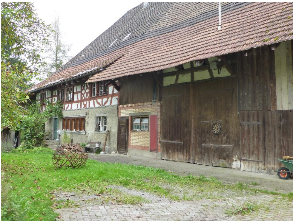
Vielzweckbauernhaus, Ostfassade, Ansicht von NO, 03.10.2014 (Bild Nr. D100559_56).
