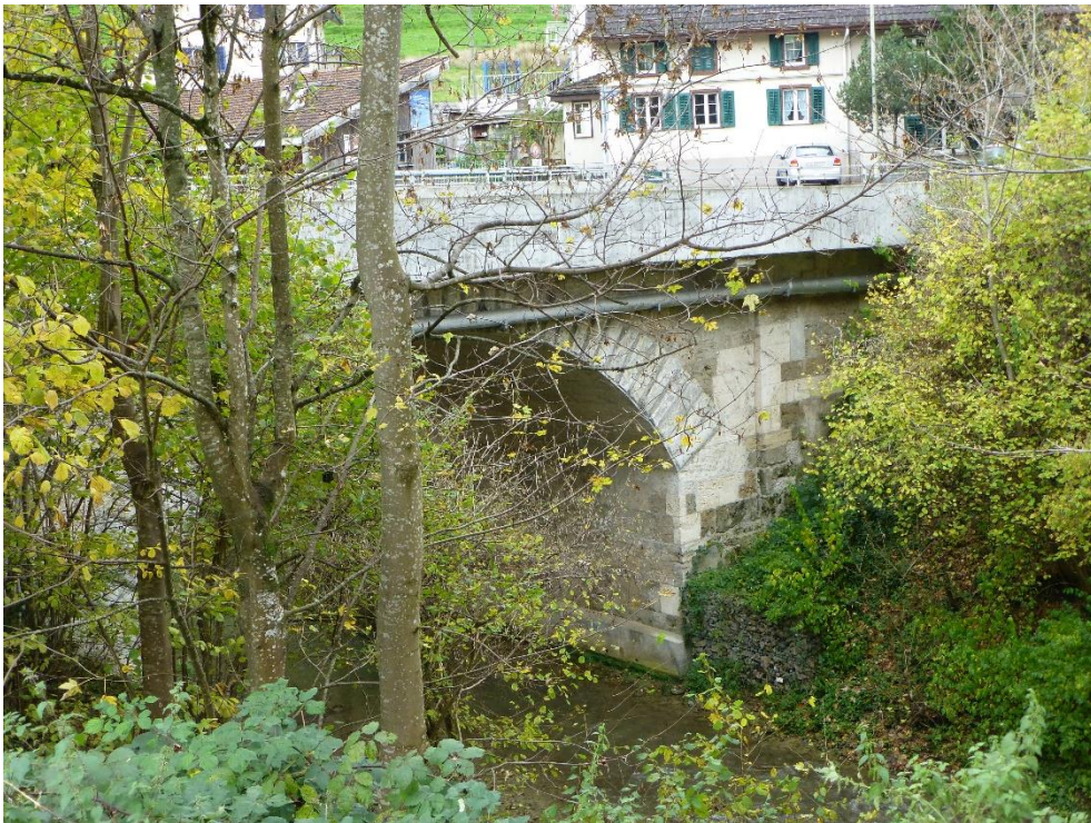
Obere Wildbachbrücke, Ansicht von O, 07.11.2013 (Bild Nr. D100557_52).
