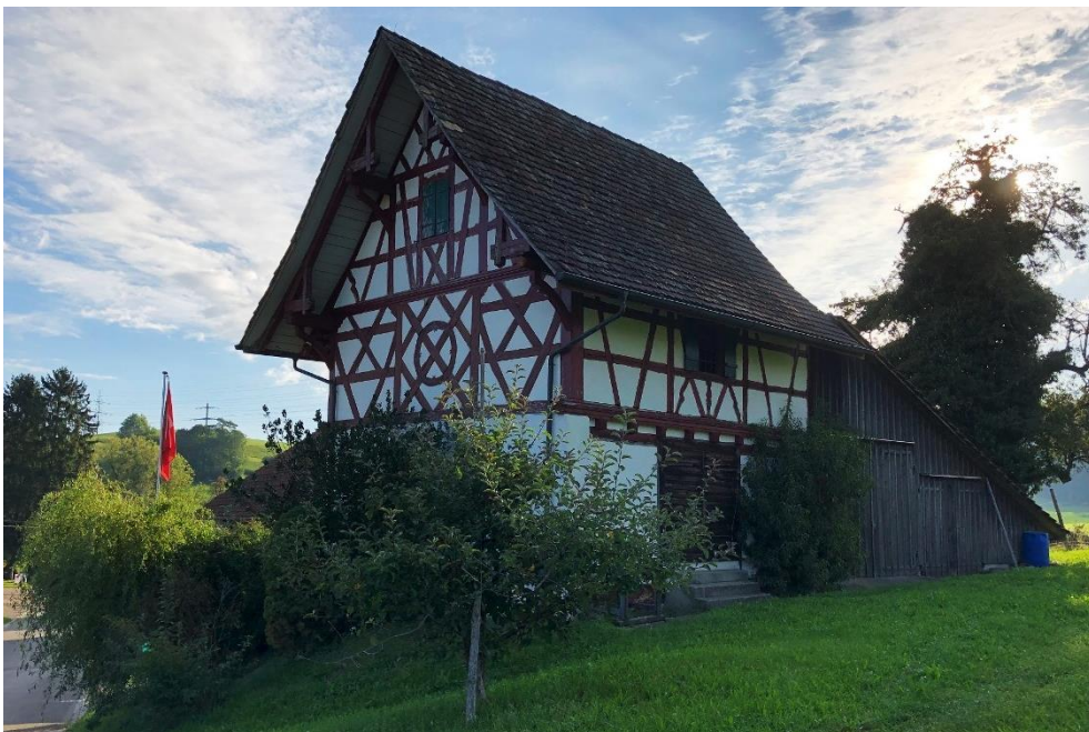
Speicher, Ansicht von W, 17.09.2019 (Bild Nr. D101088_73).
