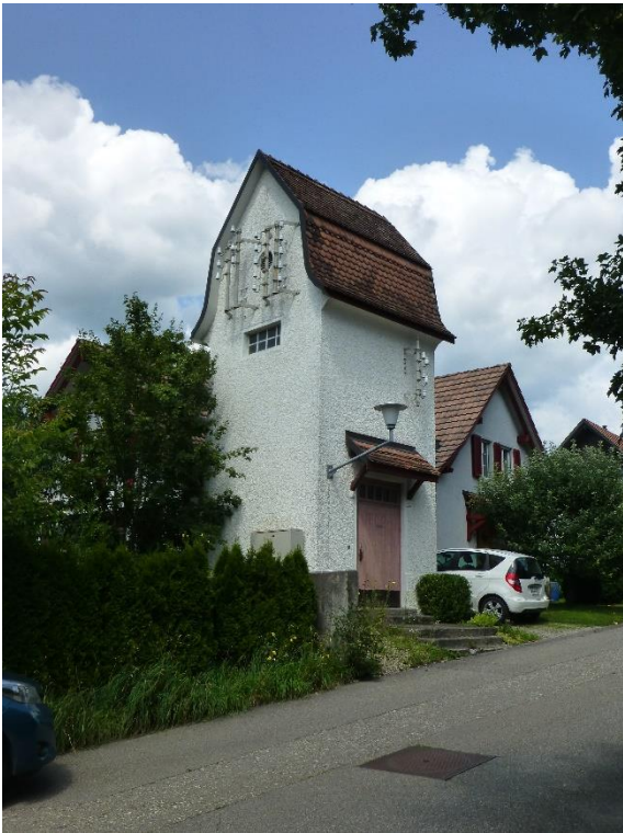
Transformatorstation «Dorf», Ansicht von SO, 05.08.2014 (Bild Nr. D100561_02).
