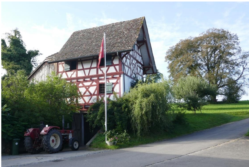
Speicher, Ansicht von NO, 17.09.2019 (Bild Nr. D101088_71).
