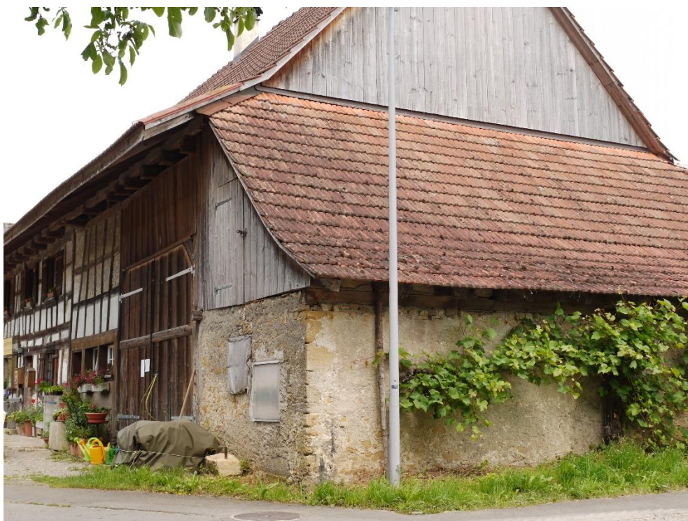
«Zunftrichterhaus», südseitiger Kelleranbau von 1800, Ansicht von NW, 27.06.2013 (Bild Nr. D100574_06).
