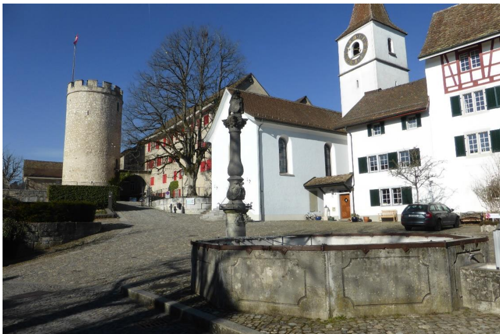
«Stadtbrunnen», Ansicht von SO, 28.02.2019 (Bild-Nr. D101396_03).
