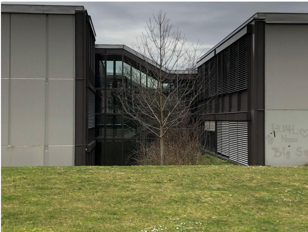
Schulanlage Schalmenacker, Schulhaus (Vers. Nr. 00680), verglastes Treppenhaus zwischen Eingangshalle und Unterrichtsräumen, Ansicht von NO, 23.02.2020 (Bild Nr. D100577_74).
