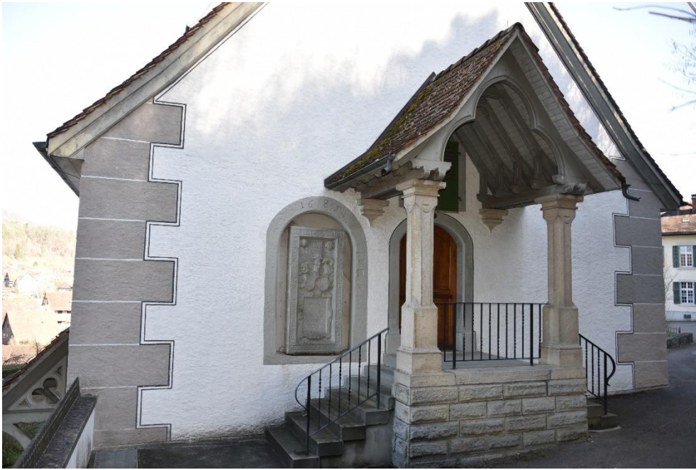
Ref. Kirche mit Friedhofgebäude, ref. Kirche (Vers. Nr. 00156), Westfassade mit Emporeneingang und Grabplatte des Teufener Gerichtsherrn Hans Meis, Ansicht von NW, 15.03.2020 (Bild Nr. D100591_80).
