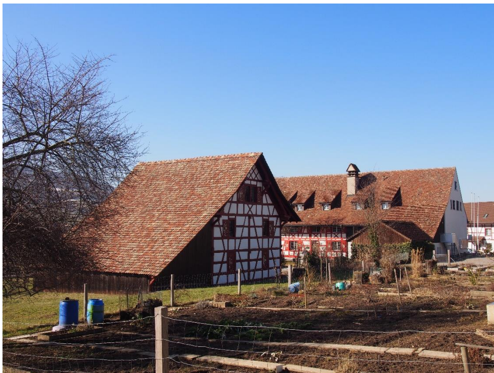
Gemeindezentrum, Heimatmuseum, ehem. Speicher (Vers. Nr. 00112), rechts dahinter das Gemeindehaus, ehem. Untervogthaus (Vers. Nr. 00108), Ansicht von NO, 18.02.2019 (Bild Nr. D101358_07).
