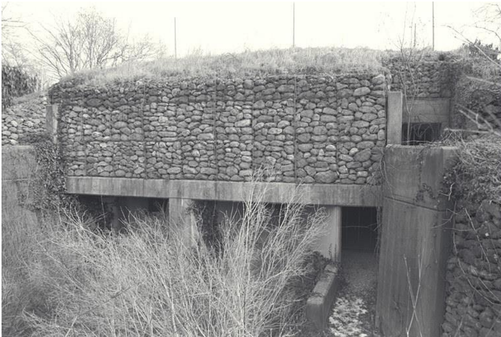
Sperrstelle 0667 Stadel, Infanteriebunker A05351, 15.12.2009 (Bild Nr. D100682_78).
