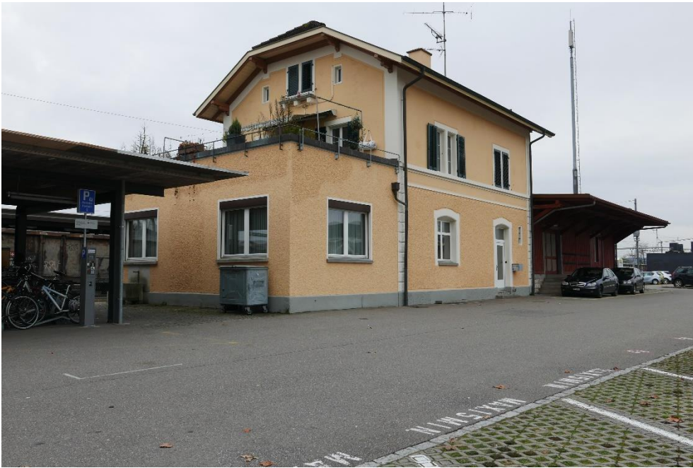
Bahnhof Rafz, Aufnahmegebäude und Güterschuppen, Ansicht von NO, 08.11.2016 (Bild Nr. D100577_02).
