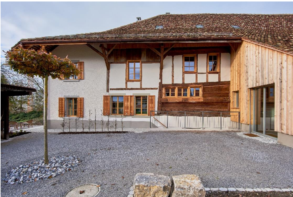
Vielzweckbauernhaus, Wohnteil nach dem Umbau 2019, Ansicht von S, 13.11.2019 (Bild Nr. D100990_87).
