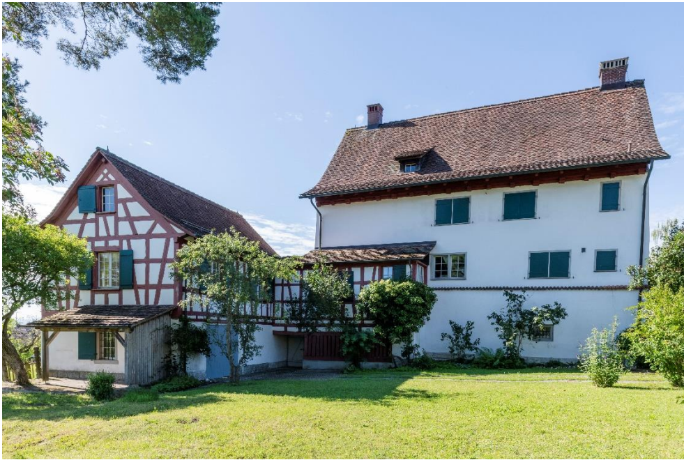
Pfarrliegenschaft, Ansicht von NW, 01.07.2020 (Bild Nr. D101391_33).
