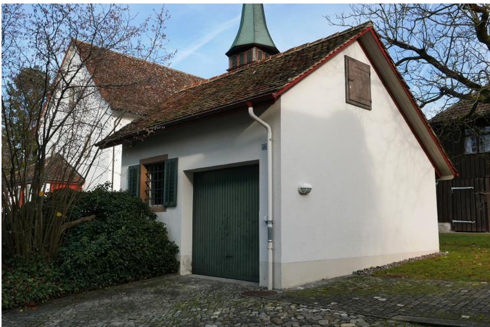
Kirchenbezirk, ehem. Waschhaus (Vers. Nr. 00241), Ansicht von S, 24.11.2017 (Bild Nr. D101396_61).
