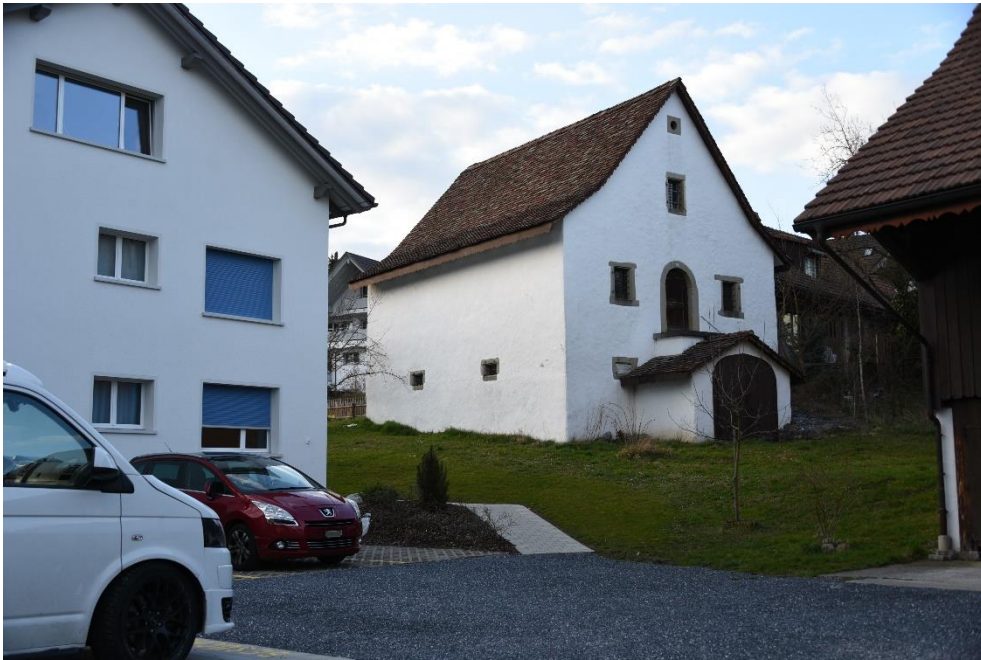
Speicher, Ansicht von SO, 07.03.2020 (Bild Nr. D100553_07).
