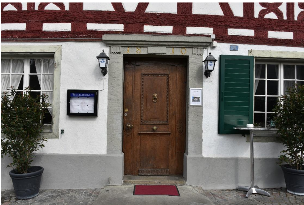
Gasthaus «Adler», Südfassade, Haupteingang mit Jahreszahl «1810» am Türsturz, Ansicht von S, 20.03.2020 (Bild Nr. D100557_65).
