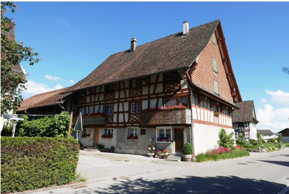
«Untervogthaus», Doppelwohnhaus, (Vers. Nr. 00089, 00090), Ansicht von NW, 06.06.2016 (Bild Nr. D100572_17).
