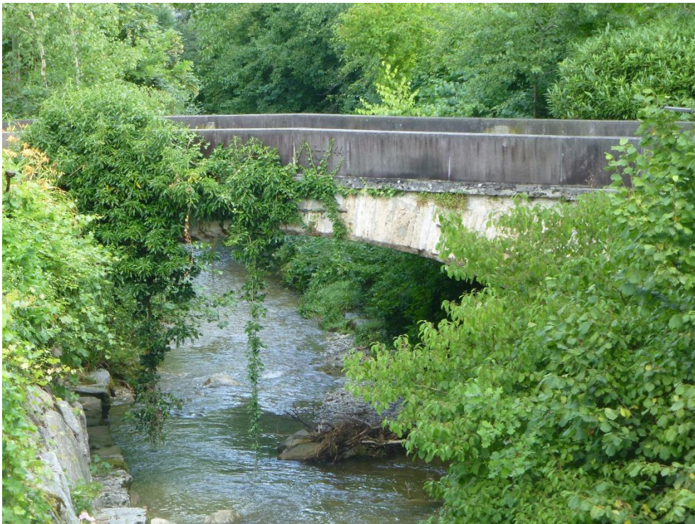
Untere Wildbachbrücke, Ansicht von SW, 30.06.2013 (Bild Nr. D100557_41).
