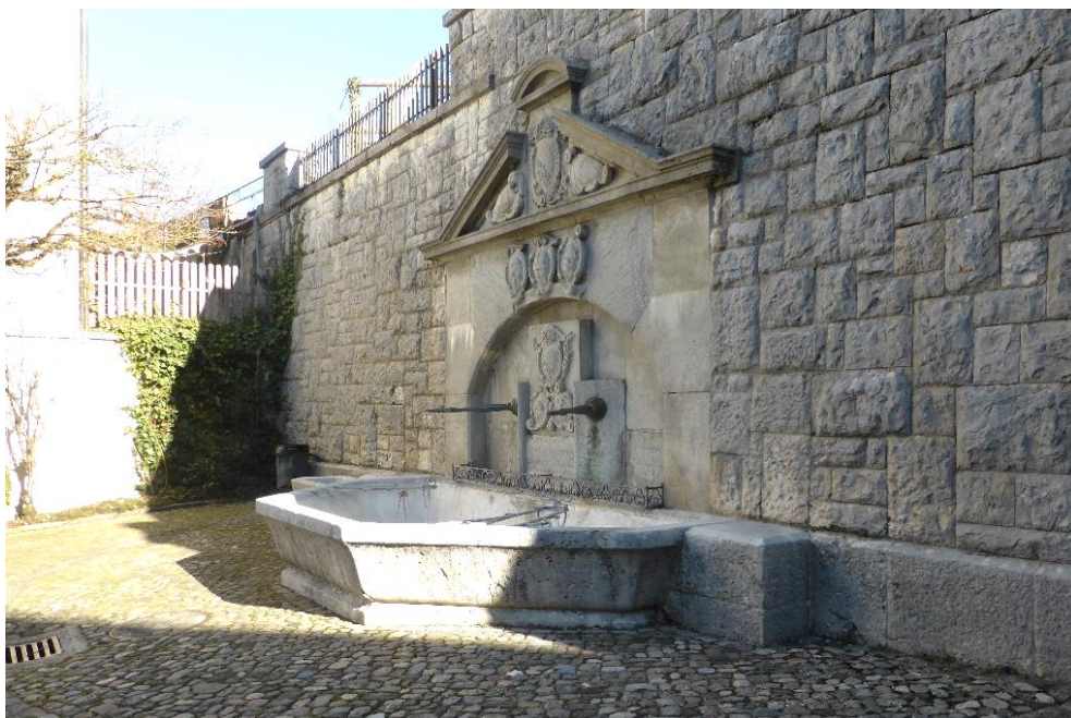
«Schulhausbrunnen», Ansicht von S, 28.02.2019 (Bild Nr. D101396_23).
