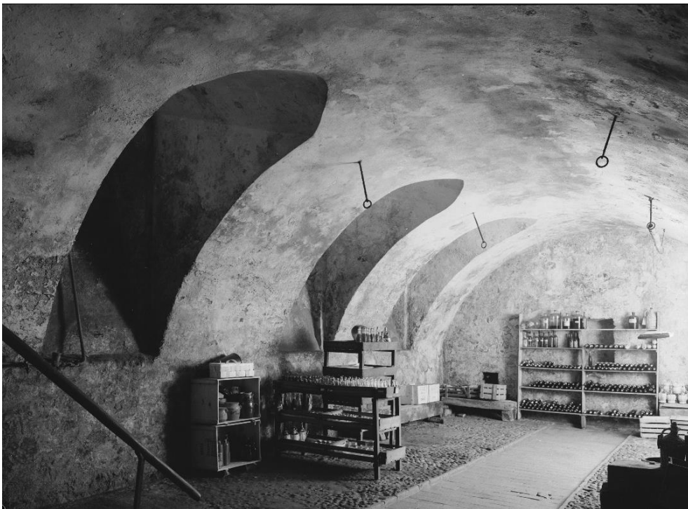
Ehem. Doppelscheune mit Wohnteil, Hausteil Ost (Vers. Nr. 00088), Gewölbekeller, 25.05.1964 (Bild Nr. U24741).
