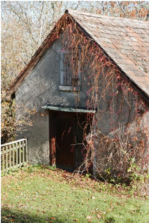
Kanonenhäuschen, Ansicht von W, 01.11.2015 (Bild Nr. D101106_03).
