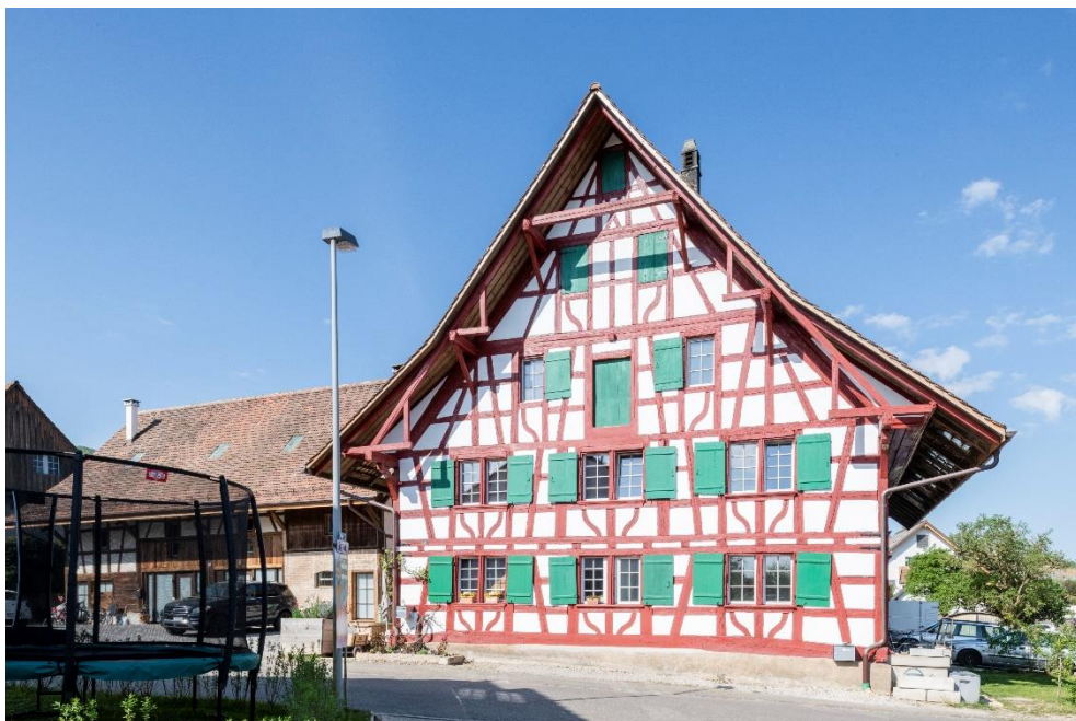
Sog. «Schellenberghaus» mit Doppelscheune, sog. «Schellenberghaus» (Vers. Nr. 00206), Ansicht von O, 24.04.2020 (Bild Nr. D100552_39).
