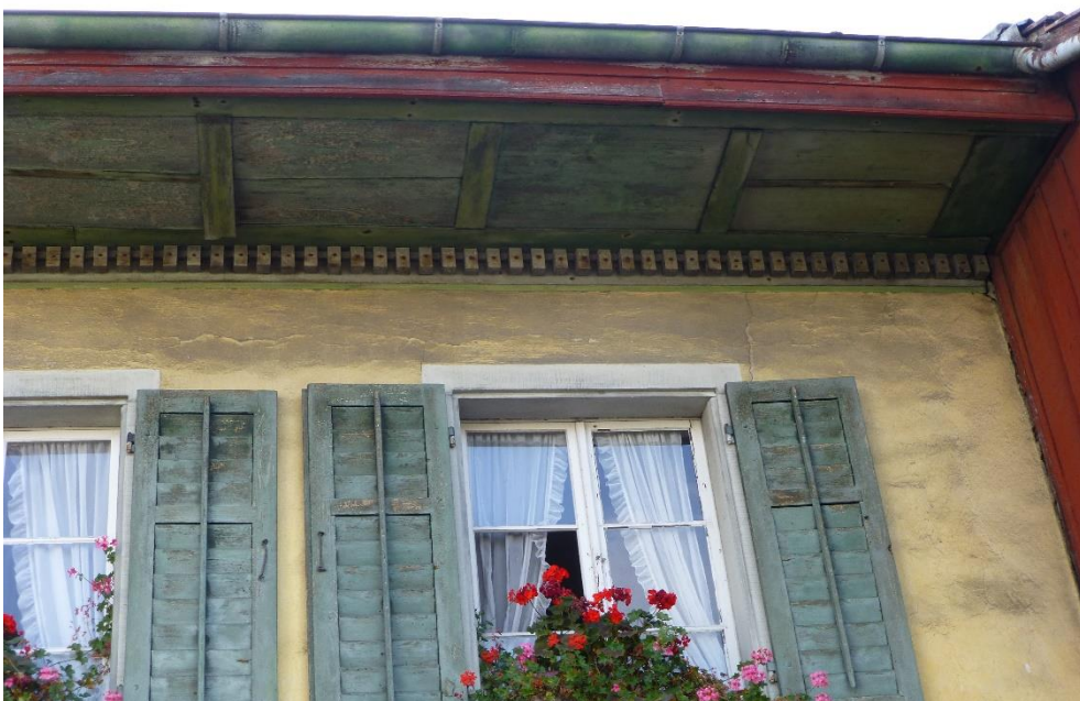
Vielzweckbauernhaus mit Scheune, Vielzweckbauernhaus (Vers. Nr. 00083), Dachuntersicht mit Würfelfries, Ansicht von O, 31.10.2013 (Bild Nr. D101097_16).
