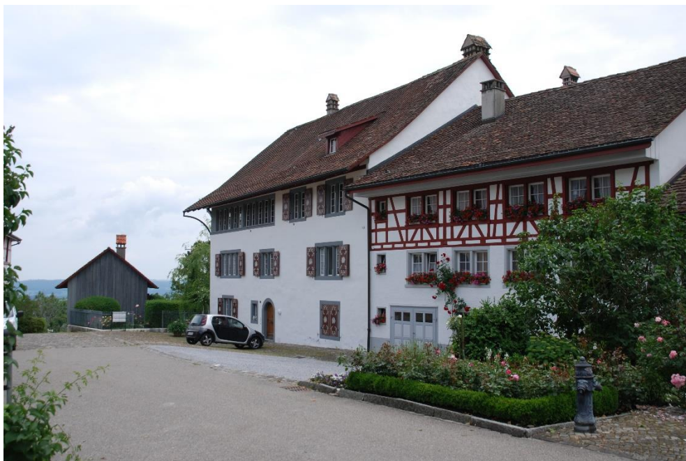
Ehem. Amtshaus, Ansicht von NW, 16.06.2015 (Bild Nr. D101012_63).
