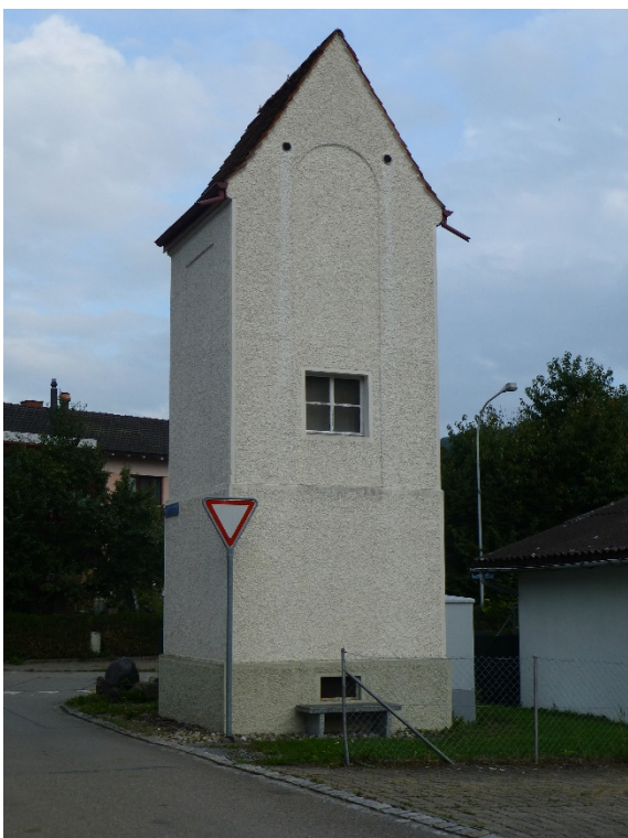
Transformatorstation «Dorf», Ansicht von NW, 01.10.2013 (Bild Nr. D100551_02).
