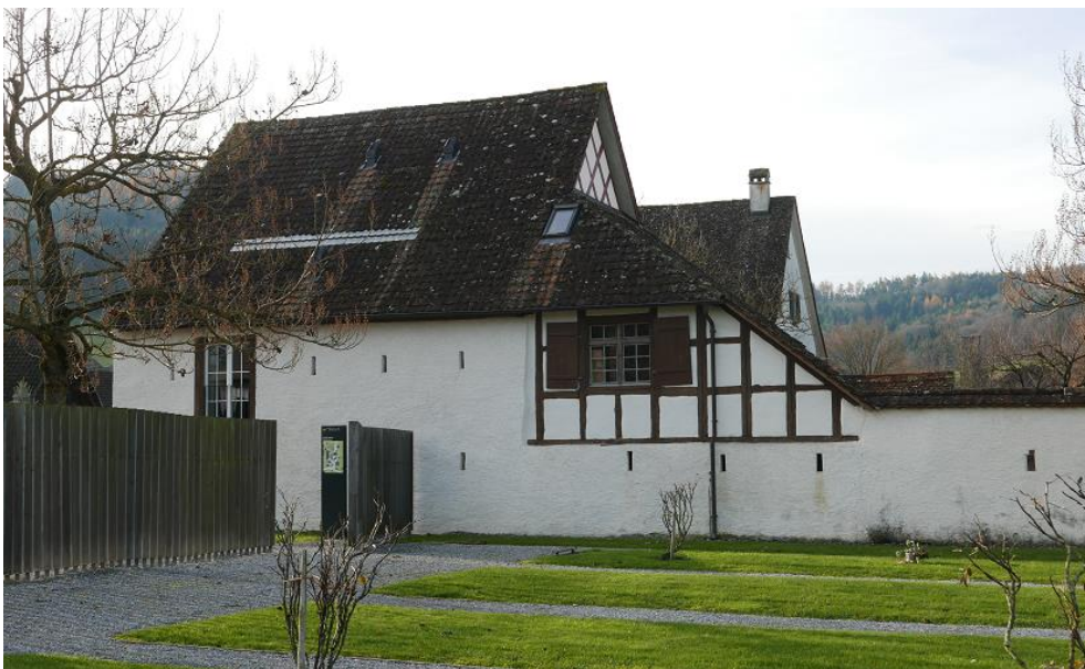
Kirchenbezirk, ehem. Pfarrscheune, heute Kirchgemeindehaus (Vers. Nr. 00243), Ansicht von NO, 24.11.2017 (Bild Nr. D101396_65).
