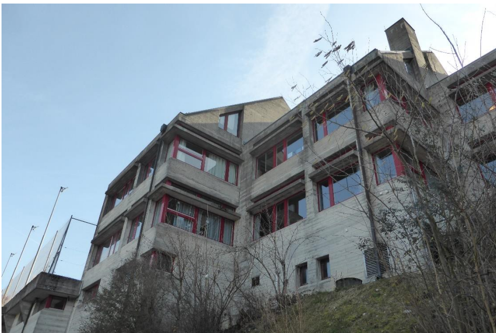
Schulhaus «Chratz», Klassentrakt, Ansicht von W, 28.02.2019 (Bild Nr. D101095_20).
