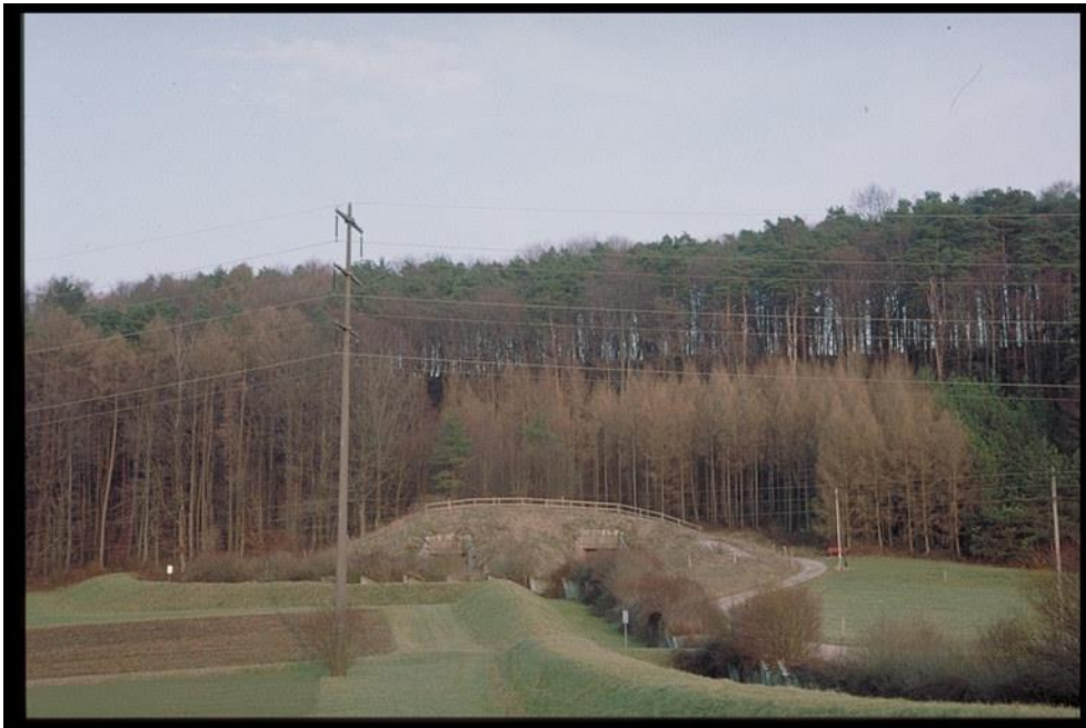
Sperrstelle 0667 Stadel, Centurion-Bunker A05584, Infanteriebunker A05353 und Centurion-Bunker A05583, Ansicht von W, 16.12.2009 (Bild Nr. D100682_87).
