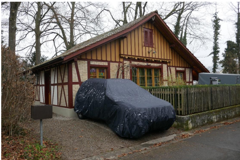
Ensemble Villa «Tusculum», Remise mit Garage (Vers. Nr. 00095), Ansicht von SW, 07.02.2018 (Bild Nr. D101366_50).
