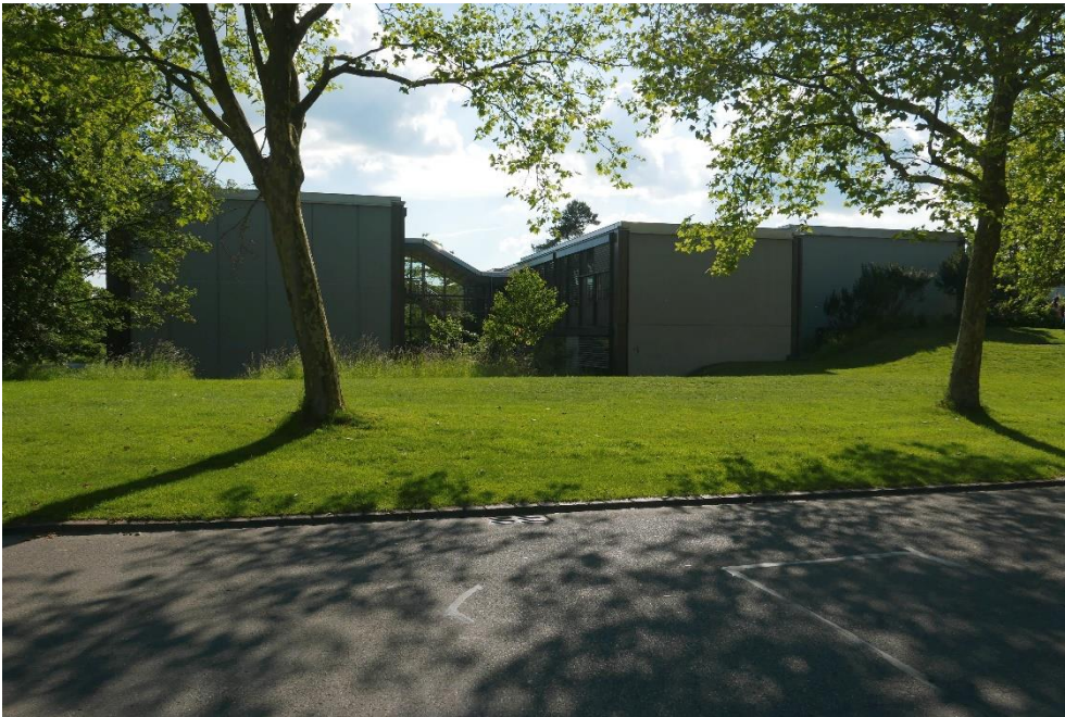
Schulanlage Schalmenacker, Schulhaus (Vers. Nr. 00680), verglastes Treppenhaus und künstlich modellierte Landschaft mit Hügeln, Bäumen und Sträuchern (067UMGEBUNG00862), Ansicht von NO, 06.06.2016 (Bild Nr. D100577_94).
