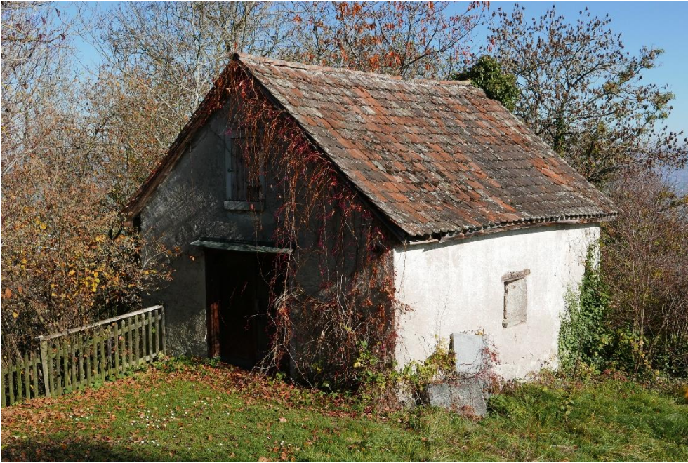
Kanonenhäuschen, Ansicht von SW, 01.11.2015 (Bild Nr. D101106_02).
