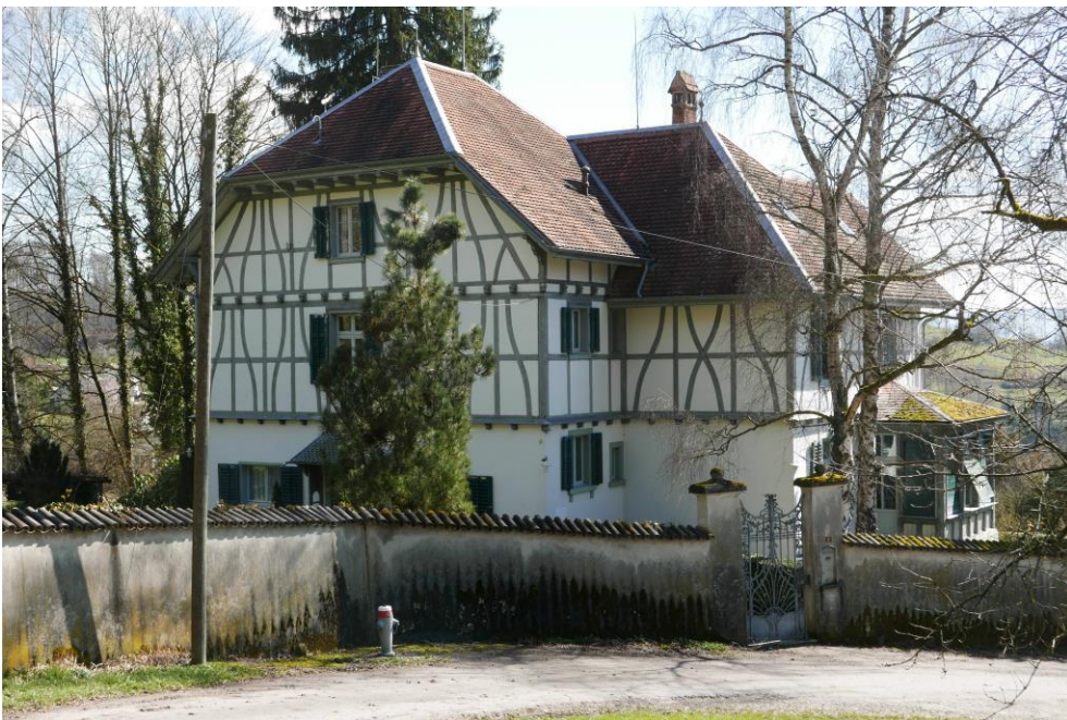
Villa «Schluchenberg», Ansicht von NW, 10.03.2017 (Bild Nr. D100577_18).
