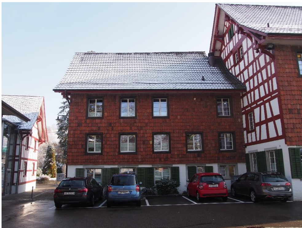
Gemeindehaus, nördliches Haus, Ansicht von W, 04.02.2019 (Bild Nr. D100596_10).
