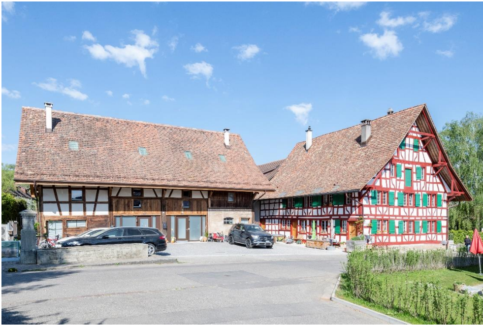
Sog. «Schellenberghaus» mit Doppelscheune, nach dem Umbau 2018, Ansicht von SO, 24.04.2020 (Bild Nr. D100552_36).
