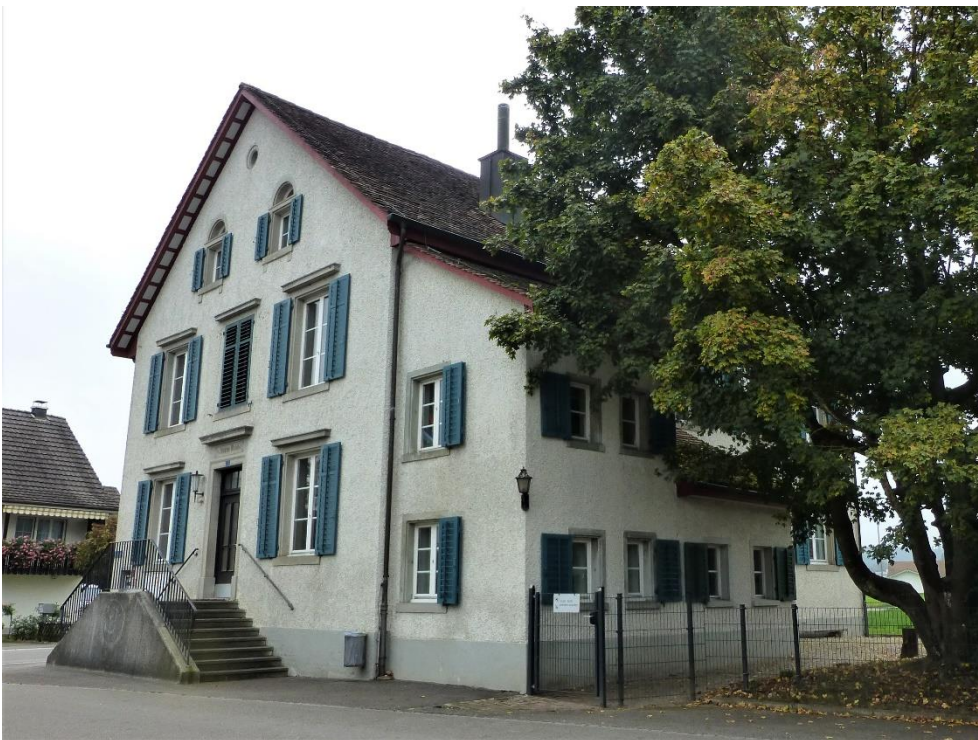
Schulhaus Windlach, Ansicht von N, 13.10.2014 (Bild Nr. D100559_65).
