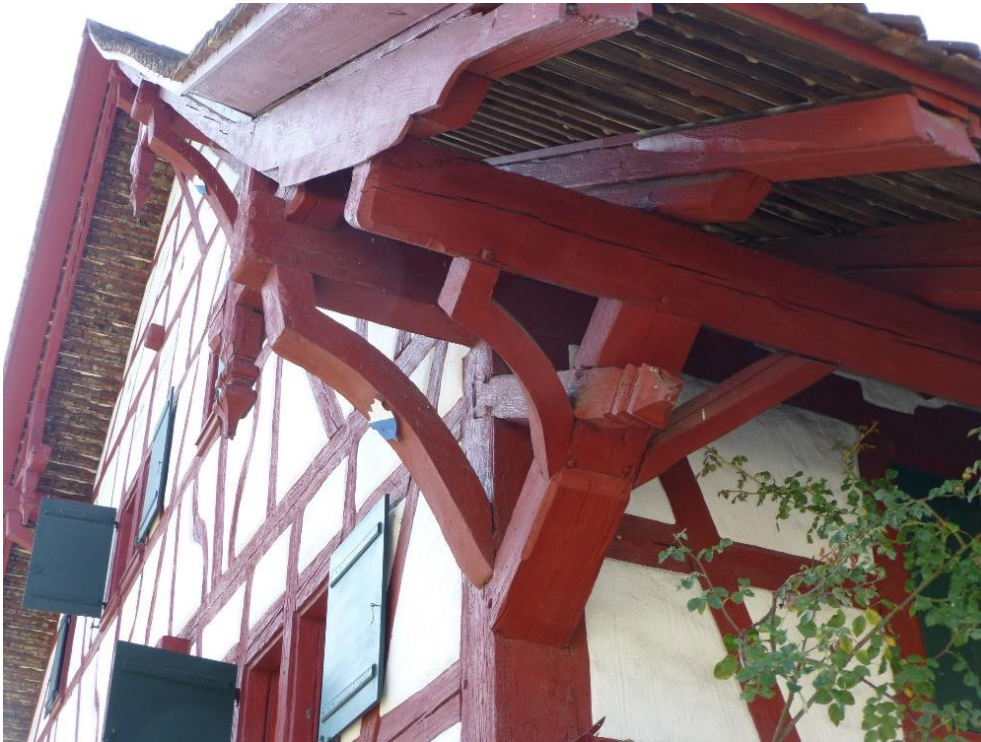
Sog. «Maaghaus» mit Waschhaus, Wohnteil (Vers. Nr. 00038) des sog. «Maaghauses», Dachkonstruktion an der Ostecke, Ansicht von NO, 26.09.2014 (Bild Nr. D100559_05).
