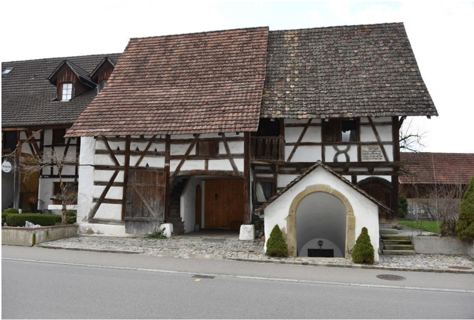
Ehem. Zehntenspeicher mit Trotte, Ansicht von SO, 11.03.2020 (Bild Nr. D100596_13).
