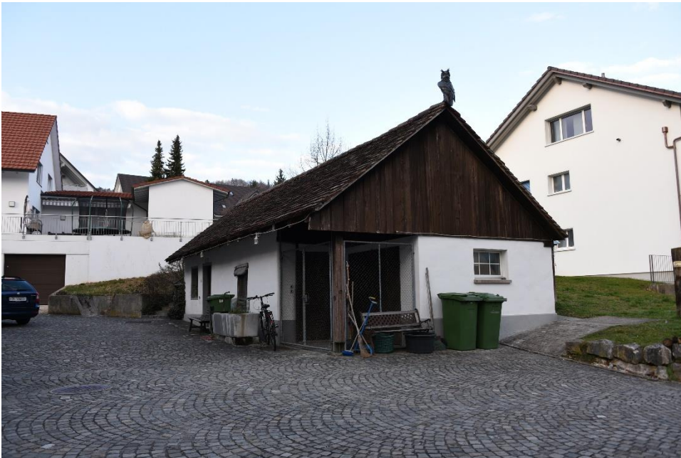
Hofgruppe Hinterdorf, Waschhaus (Vers. Nr. 00153), Ansicht von SW, 07.03.2020 (Bild Nr. D101366_54).
