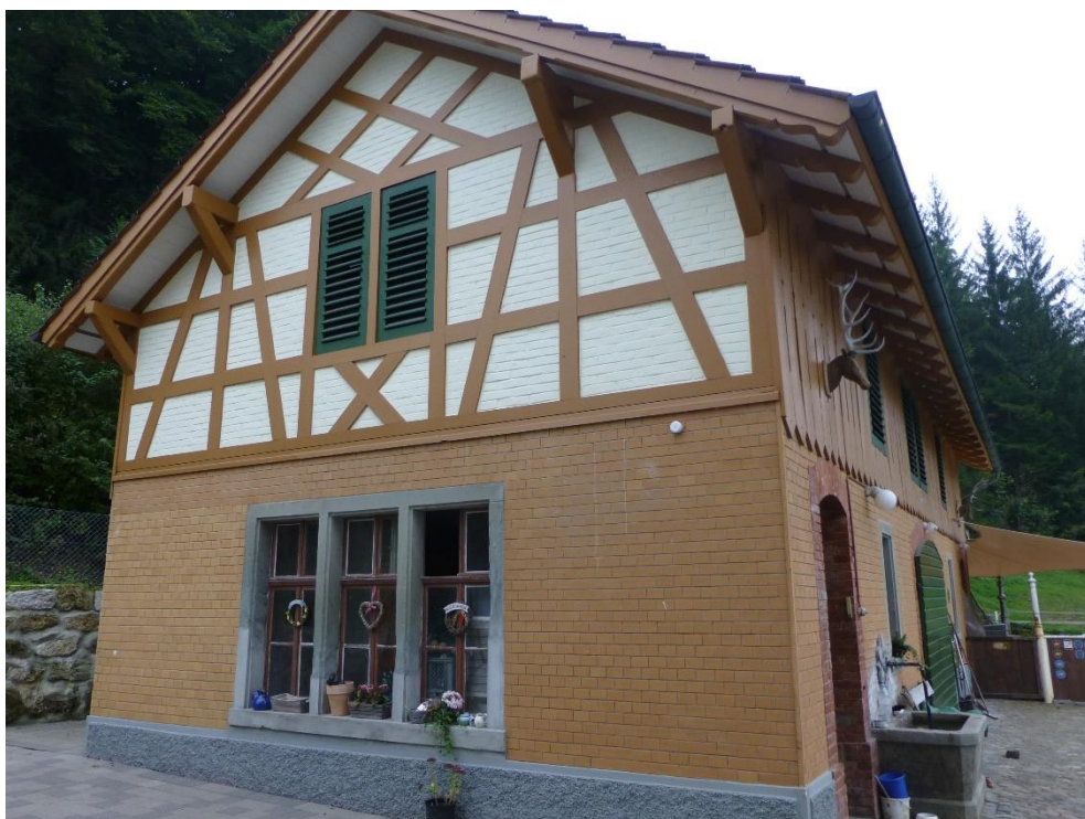
Villa Blumer mit Stallscheune und Park, Stallscheune (Vers. Nr. 00454), Ansicht von N, 01.10.2013 (Bild Nr. D100557_80).
