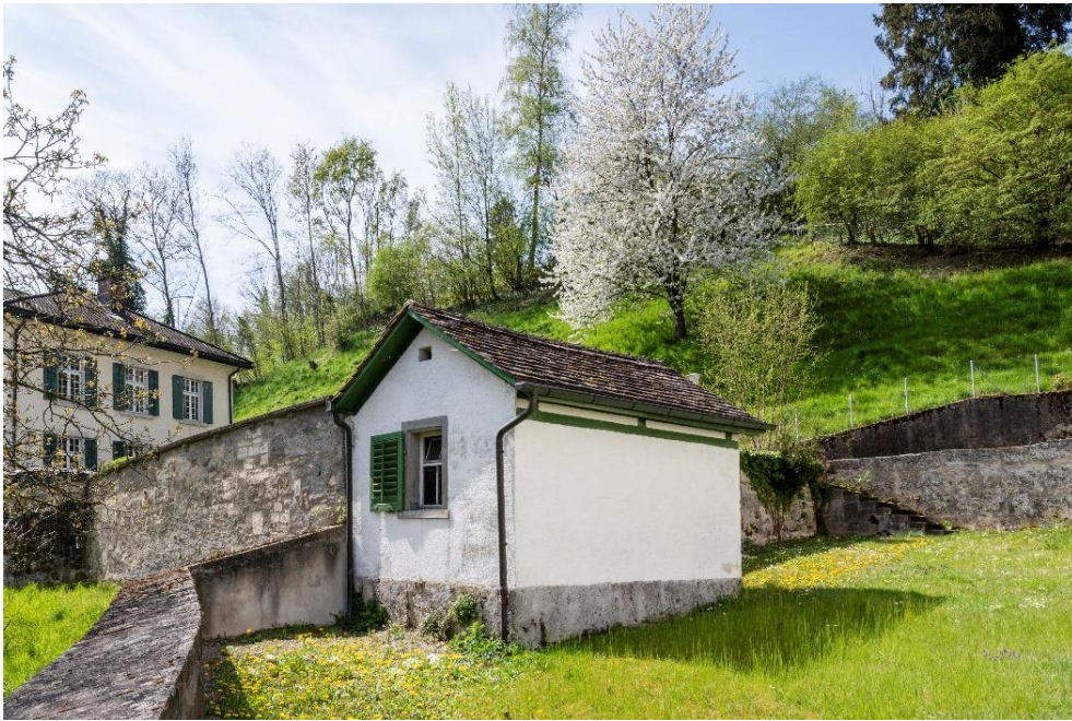
Ref. Kirche mit Friedhofgebäude, Friedhofgebäude (Vers. Nr. 00157), Ansicht von NO, 28.04.2020 (Bild Nr. D101366_62).
