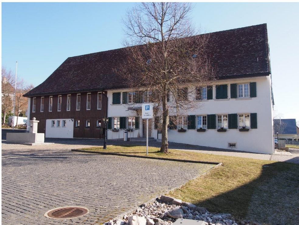
Gemeindezentrum, Gemeindehaus, ehem. Untervogthaus (Vers. Nr. 00108), Ansicht von W, 18.02.2019 (Bild Nr. D101358_03).
