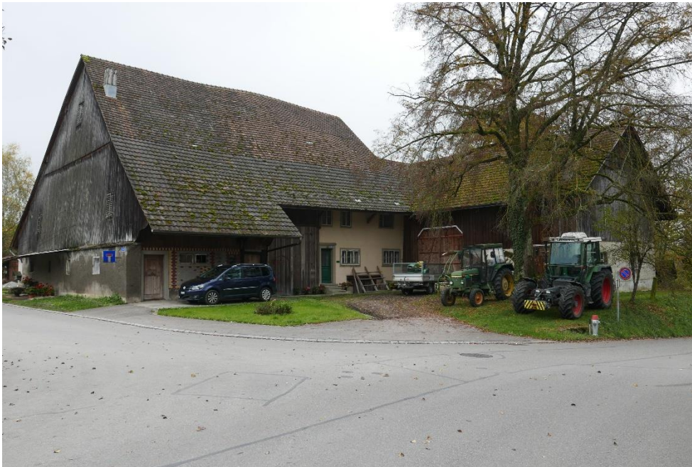
Vielzweckbauernhaus, Ansicht von N, 31.10.2016 (Bild Nr. D100558_72).
