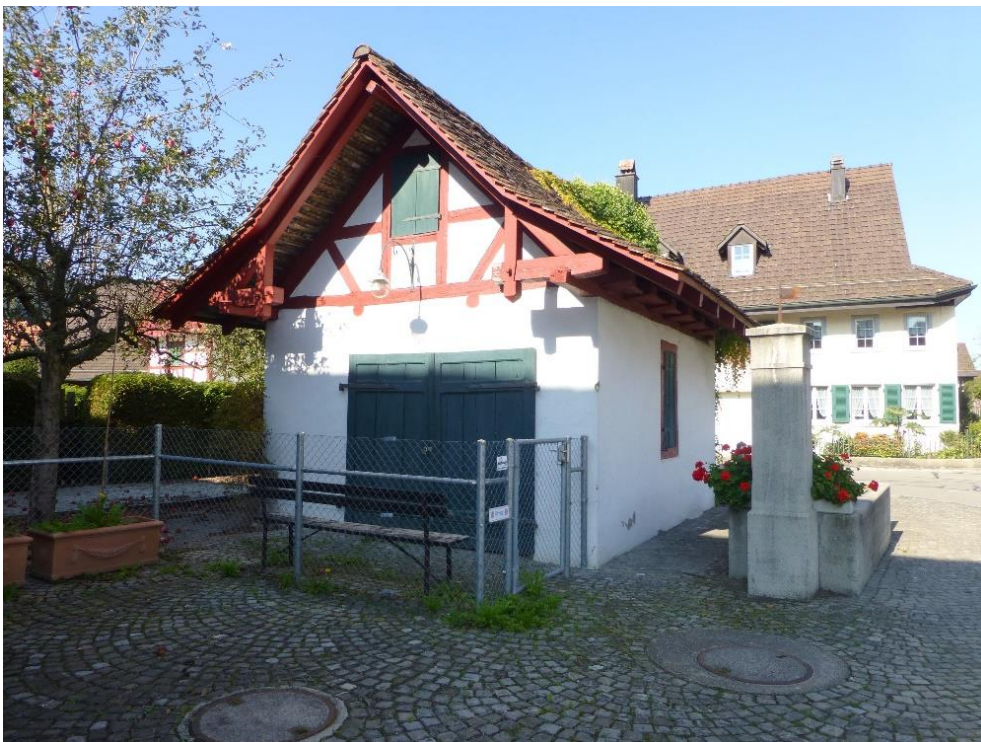
Sog. «Maaghaus» mit Waschhaus, Waschhaus (Vers. Nr. 00039), Ansicht von S, 26.09.2014 (Bild Nr. D100559_02).
