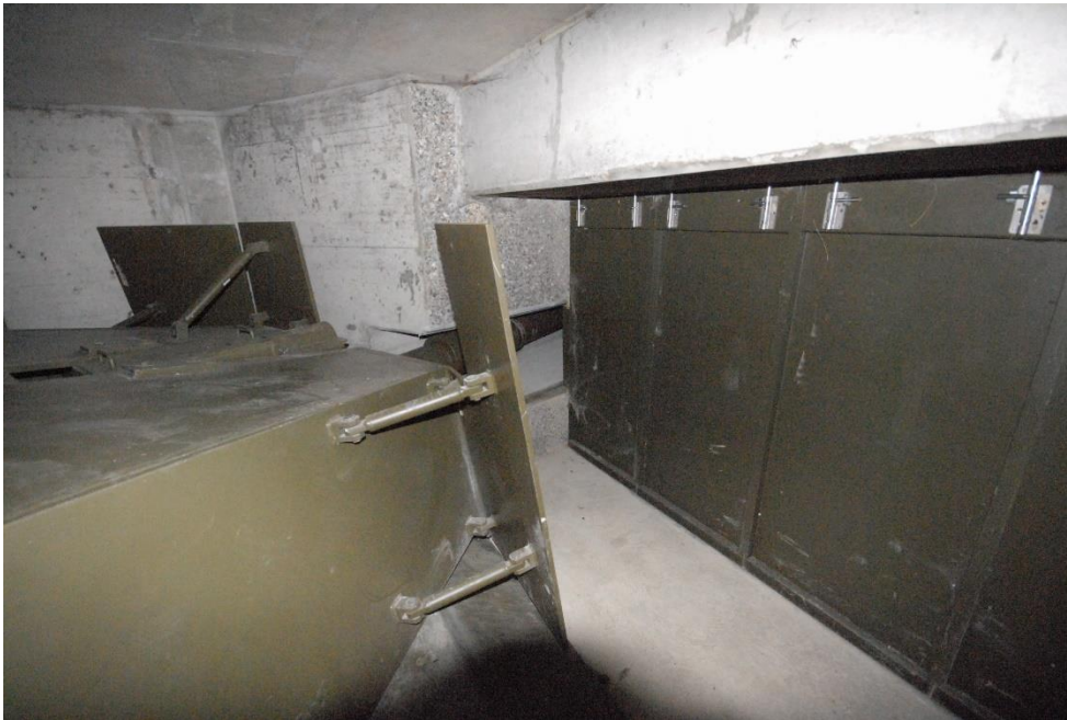
Sperrstelle 0667 Stadel, Centurion-Bunker A05583, Centurion-Geschützturm in Ruhestellung, 27.10.2011 (Bild Nr. D100682_89).
