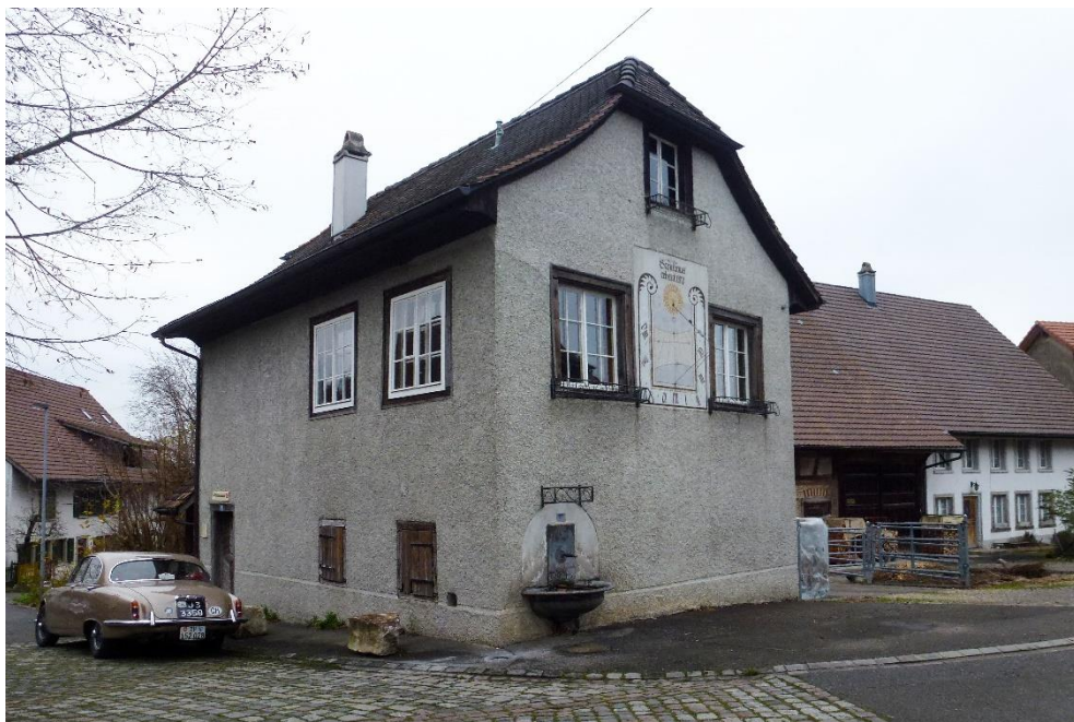
Schulhausensemble, Altes Schulhaus (Vers. Nr. 00465), Ansicht von SW, 04.12.2014 (Bild Nr. D100580_02).
