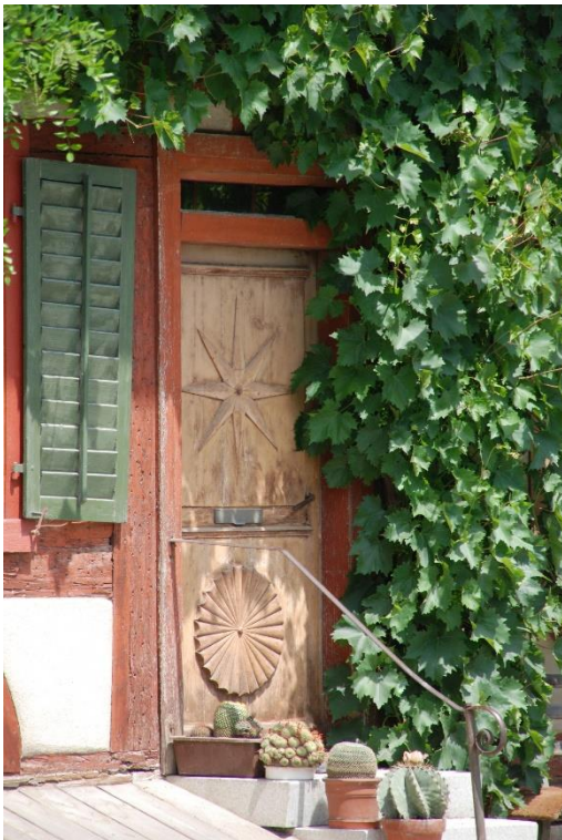
«Untervogthaus», Eingangstür an Hausteil 2 (Vers. Nr. 00090), Ansicht von S, 29.06.2012 (Bild Nr. D100069_36).
