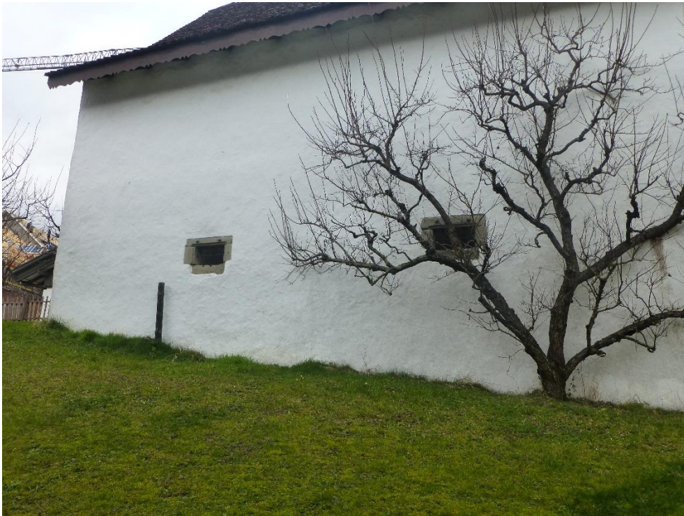
Speicher, Ansicht von S, 13.02.2014 (Bild Nr. D100553_02).
