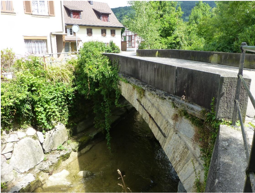
Untere Wildbachbrücke, Ansicht von S, 30.06.2013 (Bild Nr. D100557_43).
