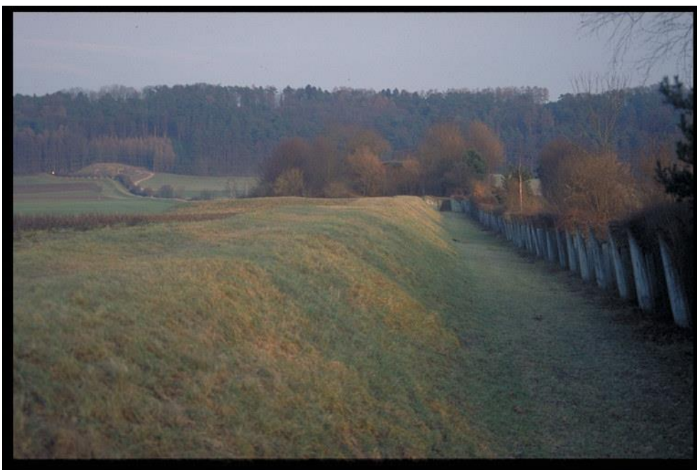
Sperrstelle 0667 Stadel, Panzersperre T02727, Ansicht von W, 01.01.2009 (Bild Nr. D100682_91).
