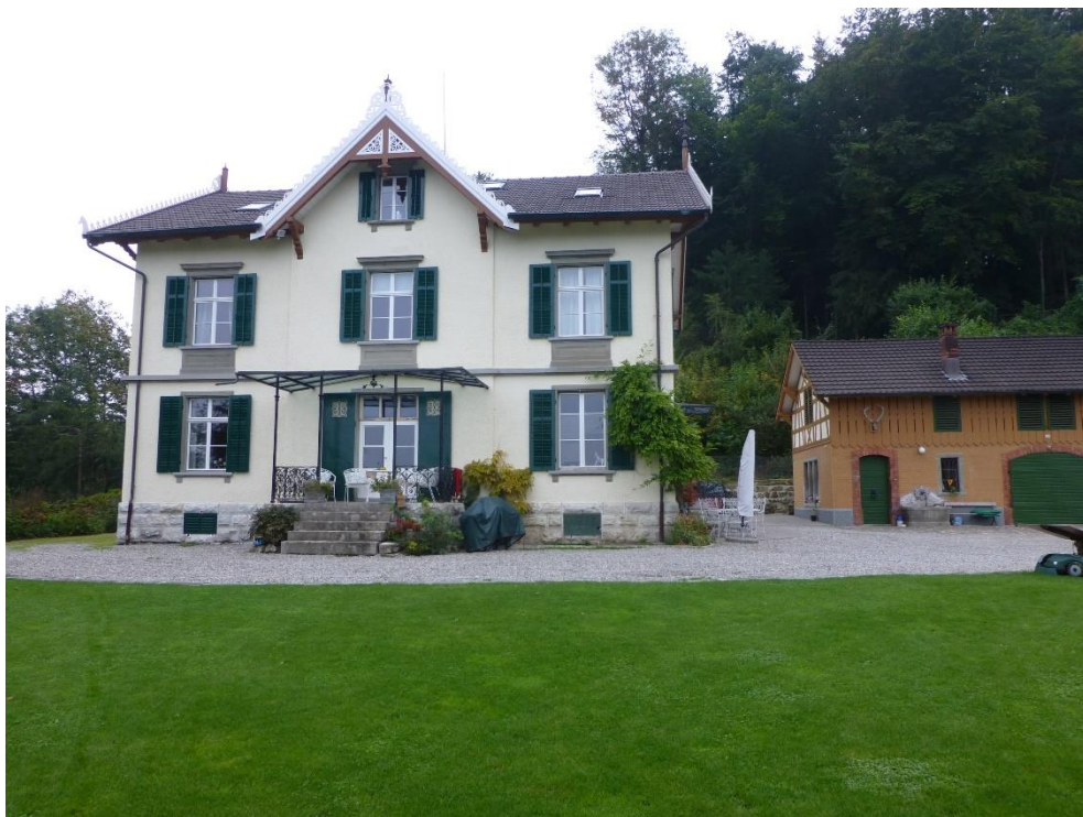
Villa Blumer mit Stallscheune und Park, Ansicht von NW, 01.10.2013 (Bild Nr. D100557_74).
