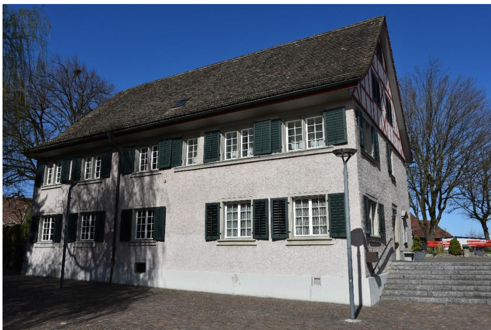
Ref. Pfarrhaus, Ansicht von SO, 13.03.2020 (Bild Nr. D101367_05).
