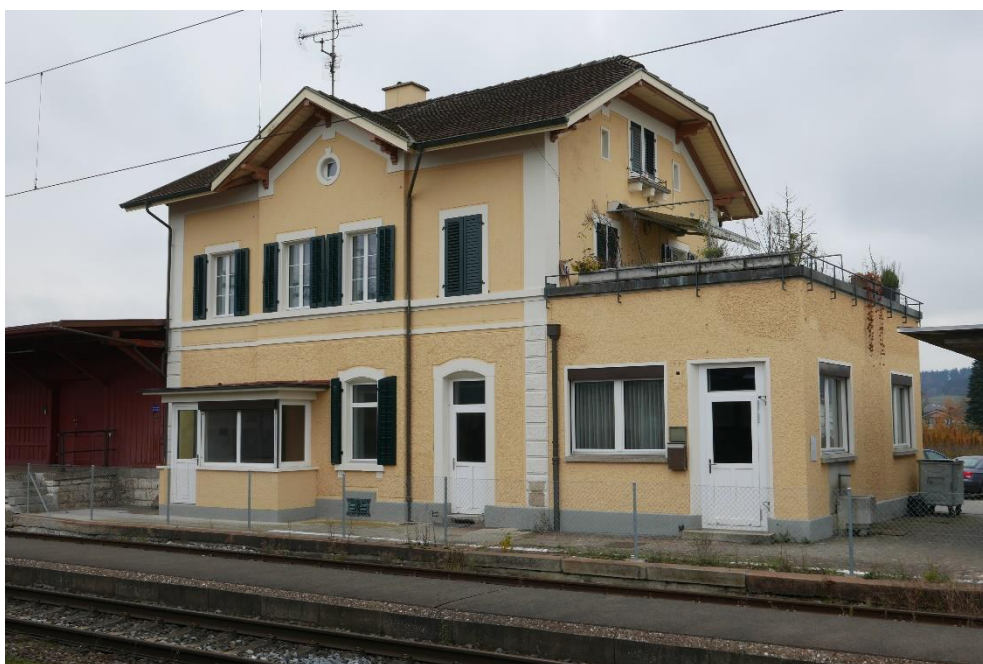
Bahnhof Rafz, Aufnahmegebäude, Ansicht von SO, 08.11.2016 (Bild Nr. D100577_05).
