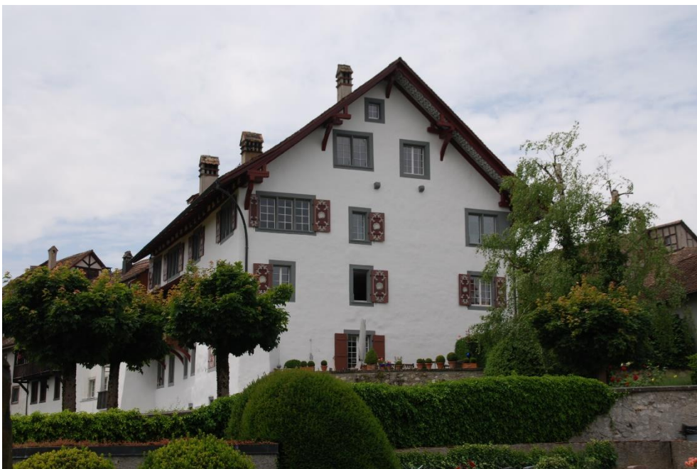
Ehem. Amtshaus, Ansicht von O, 16.06.2015 (Bild Nr. D101012_66).
