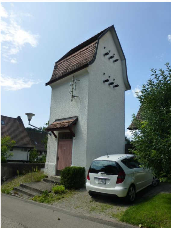
Transformatorstation «Dorf», Ansicht von NO, 05.08.2014 (Bild Nr. D100561_01).
