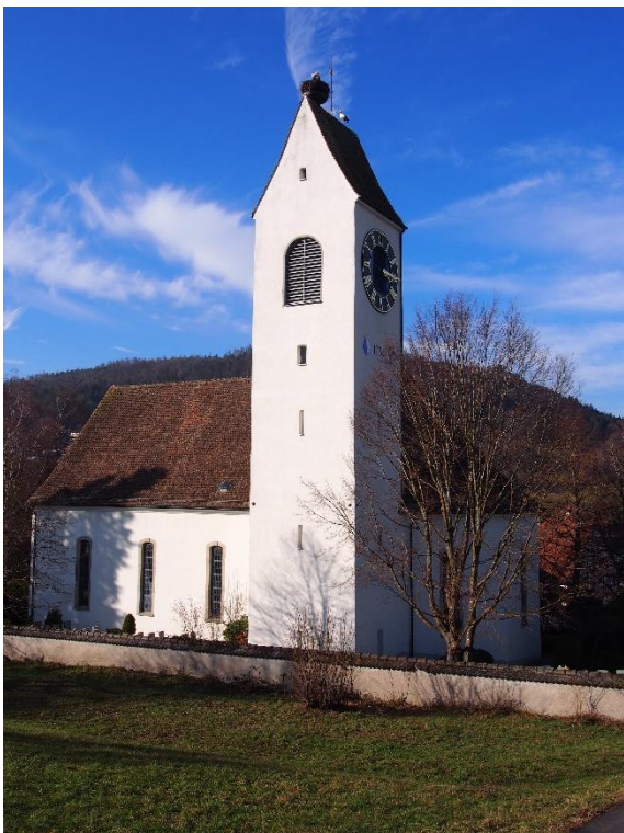
Ref. Kirche, Ansicht von SO, 14.02.2019 (Bild Nr. D101355_45).
