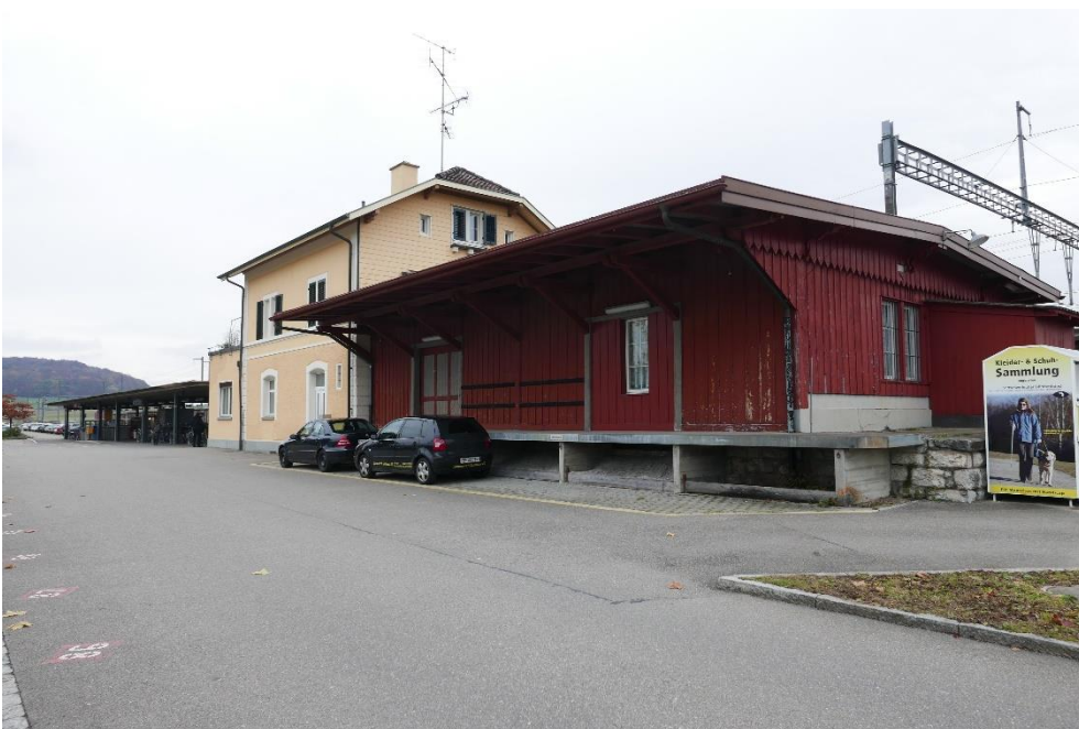
Bahnhof Rafz, Aufnahmegebäude und Güterschuppen, Ansicht von W, 08.11.2016 (Bild Nr. D100577_03).
