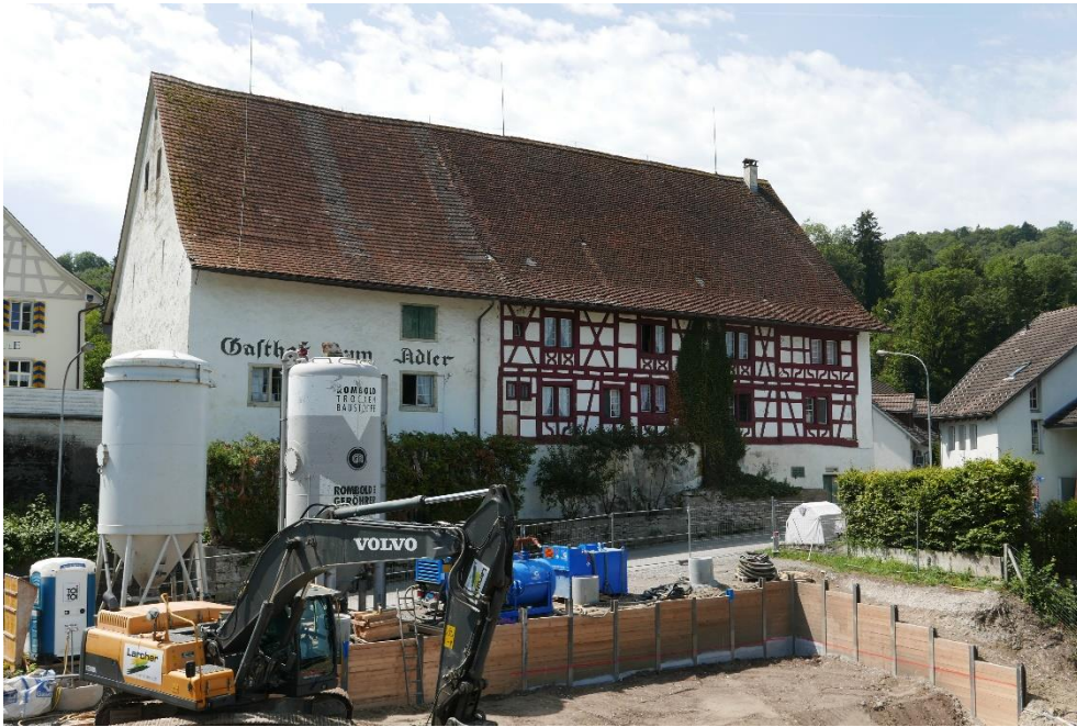
Gasthaus «Adler», Ansicht von NO, 31.07.2017 (Bild Nr. D100557_62).
