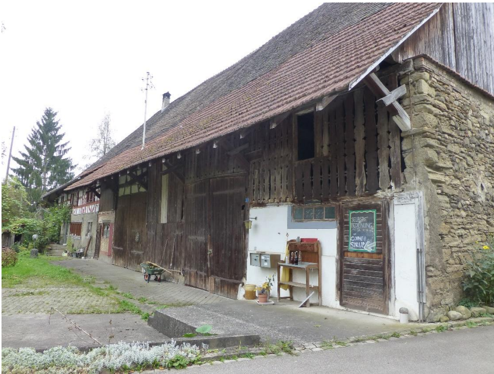
Vielzweckbauernhaus, Ostfassade, Ansicht von NO, 03.10.2014 (Bild Nr. D100559_55).
