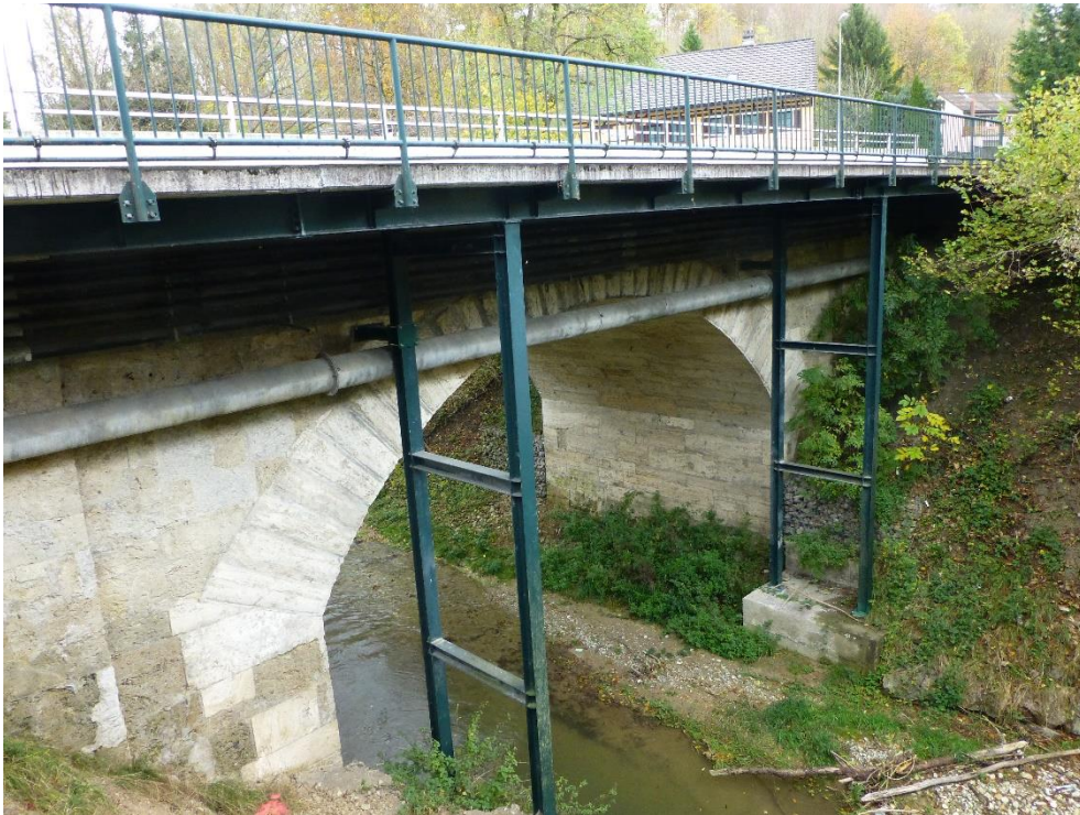
Obere Wildbachbrücke, Ansicht von W, 07.11.2013 (Bild Nr. D100557_51).
