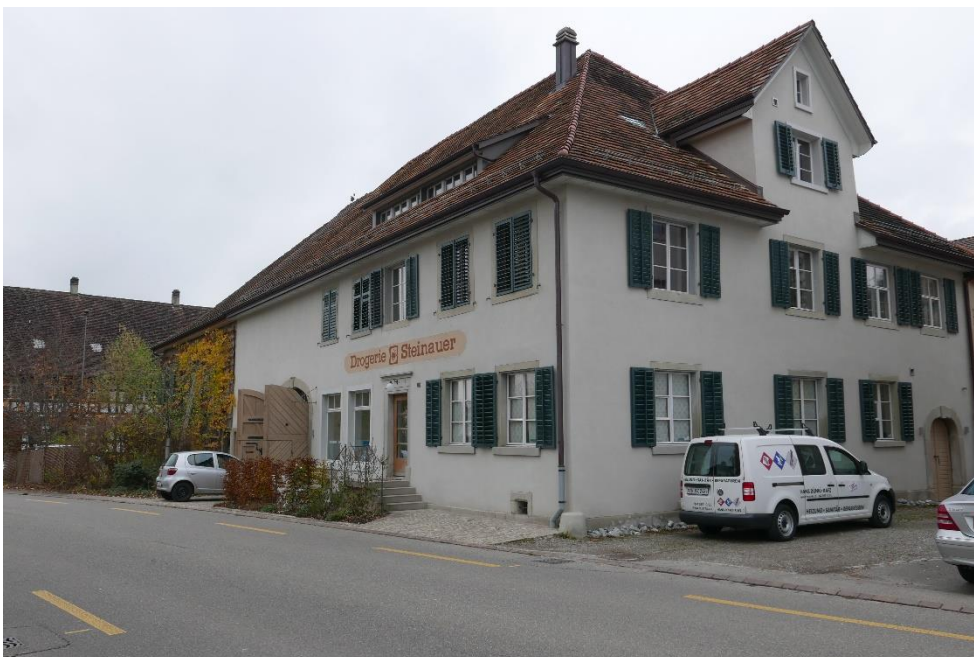
Ehem. Doppelscheune mit Wohnteil, Hausteil Ost (Vers. Nr. 00088), Ansicht von SO, 08.11.2016 (Bild Nr. D100577_52).
