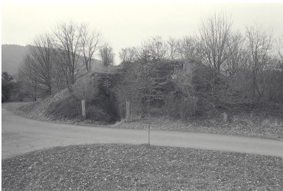
Sperrstelle 0667 Stadel, Infanteriebunker A05352, 15.12.2009 (Bild Nr. D100682_80).
