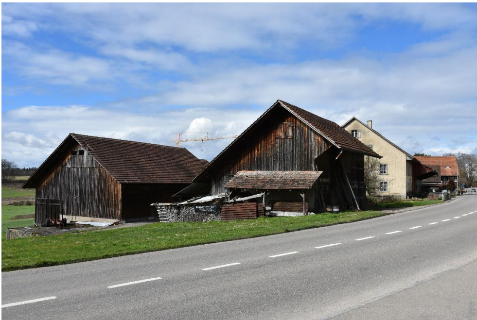
Vielzweckbauernhaus mit Scheune, Ansicht von SO, 11.03.2020 (Bild Nr. D101097_04).
