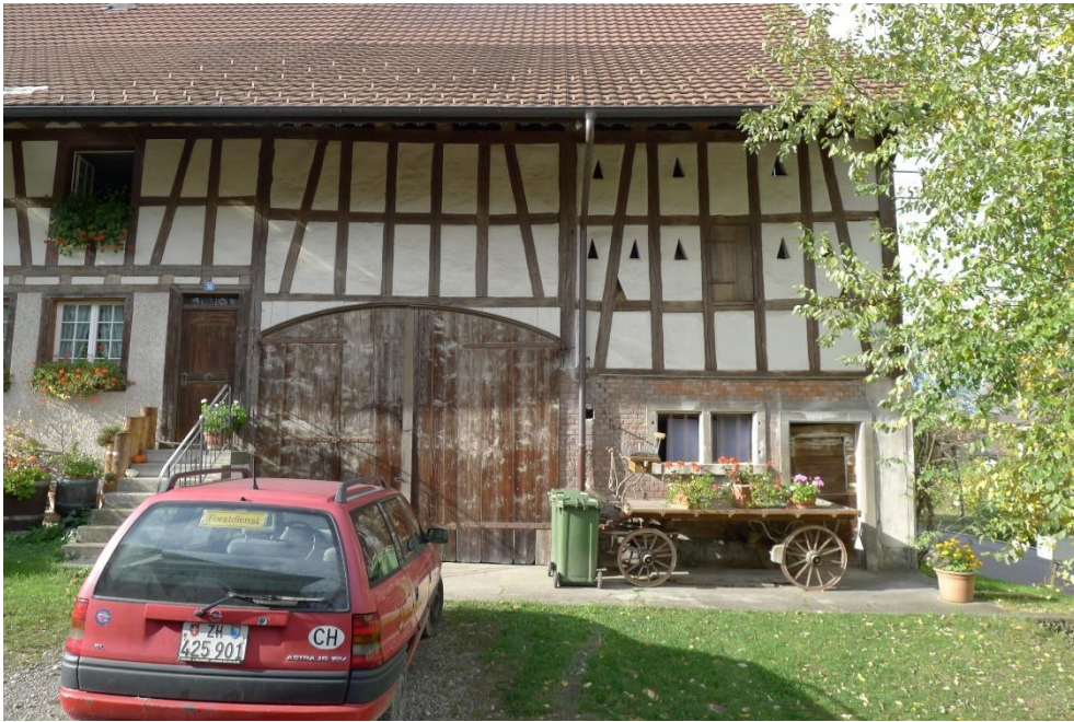
Vielzweckbauernhaus, Ansicht von O, 07.11.2013 (Bild Nr. D100581_88).
