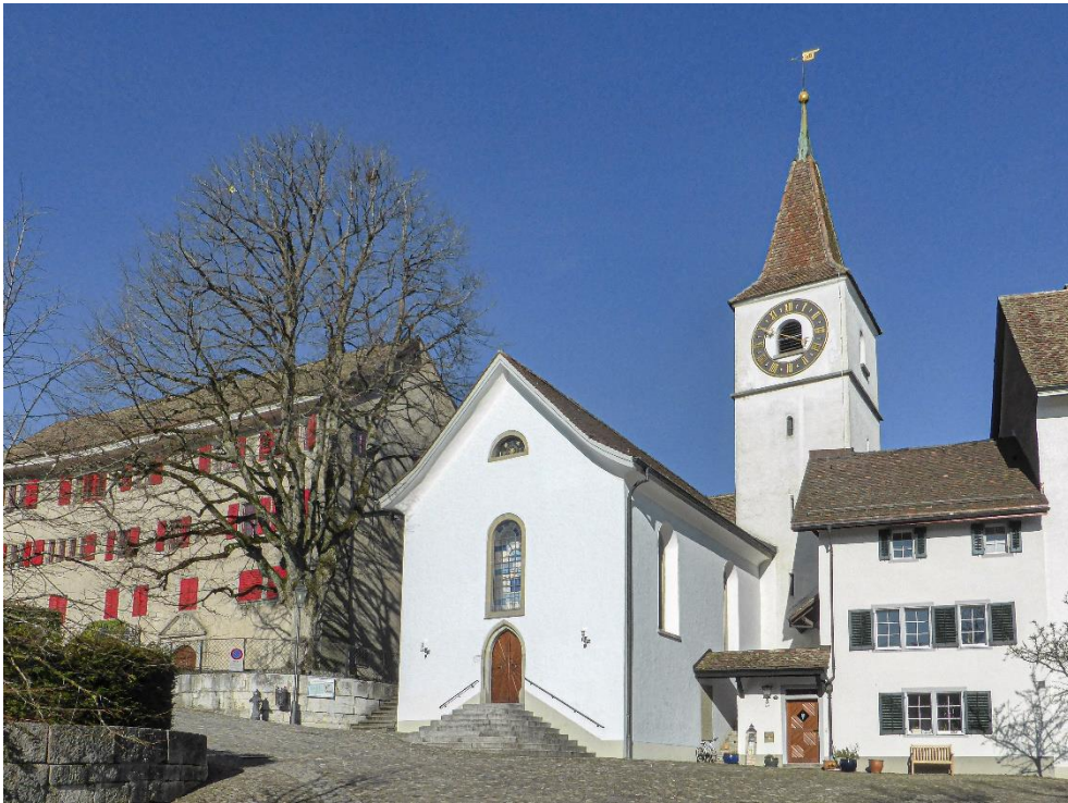
Ref. Kirche, Ansicht von SO, links das ehem. Schloss (Oberburg 22; Vers. Nr. 00047), 28.02.2019 (Bild Nr. D101397_25).
