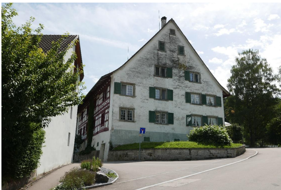
Gasthaus «Adler», Ansicht von NW, 31.07.2017 (Bild Nr. D100557_63).
