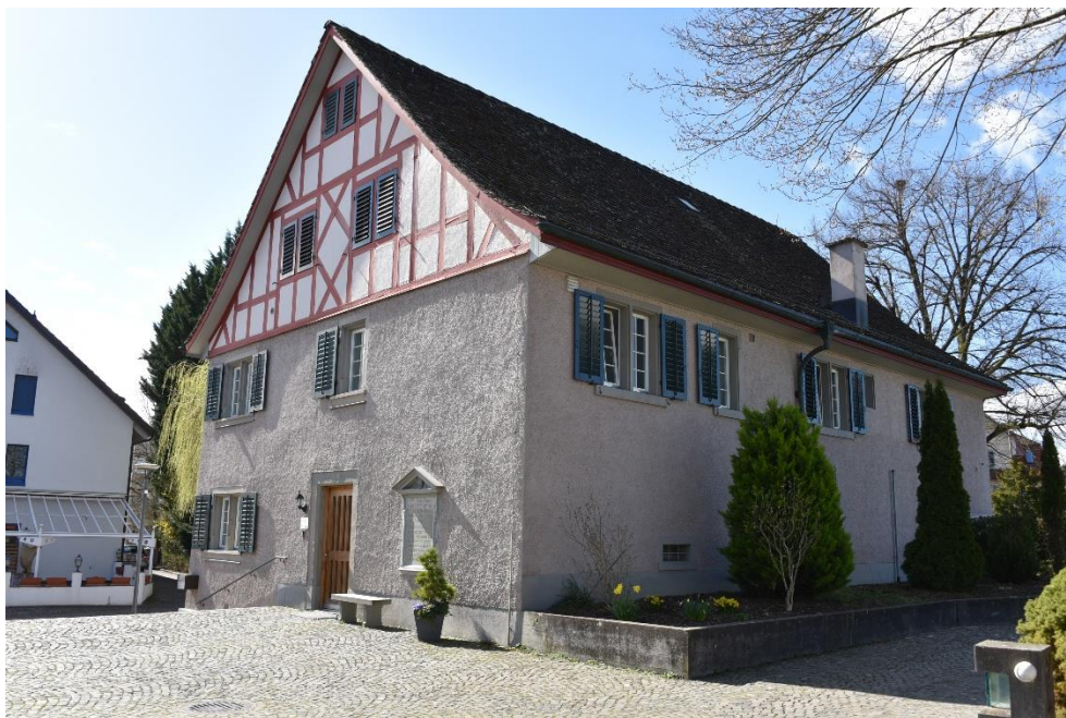
Ref. Pfarrhaus, Ansicht von NO, 13.03.2020 (Bild Nr. D101367_06).
