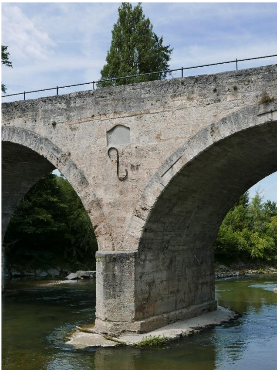
«Römerbrücke», östlicher Pfeiler, Ansicht von SO, 31.07.2017 (Bild Nr. D100557_73).
