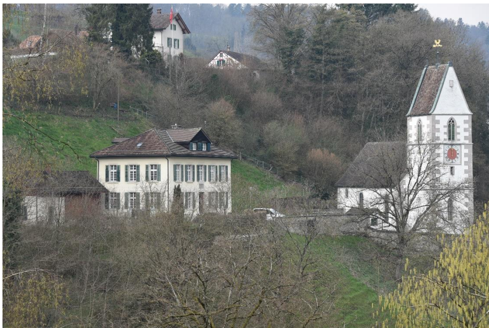
Ref. Kirche mit Friedhofgebäude, Situation am Hang, Ansicht von O, 20.03.2020 (Bild Nr. D100591_71).
