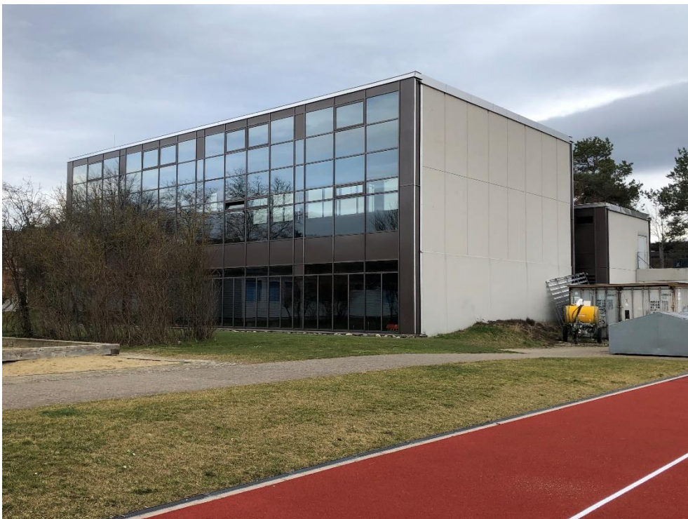
Schulanlage Schalmenacker, Turn- und Schwimmhalle, Ansicht von NW, 23.02.2020 (Bild Nr. D100577_83).
