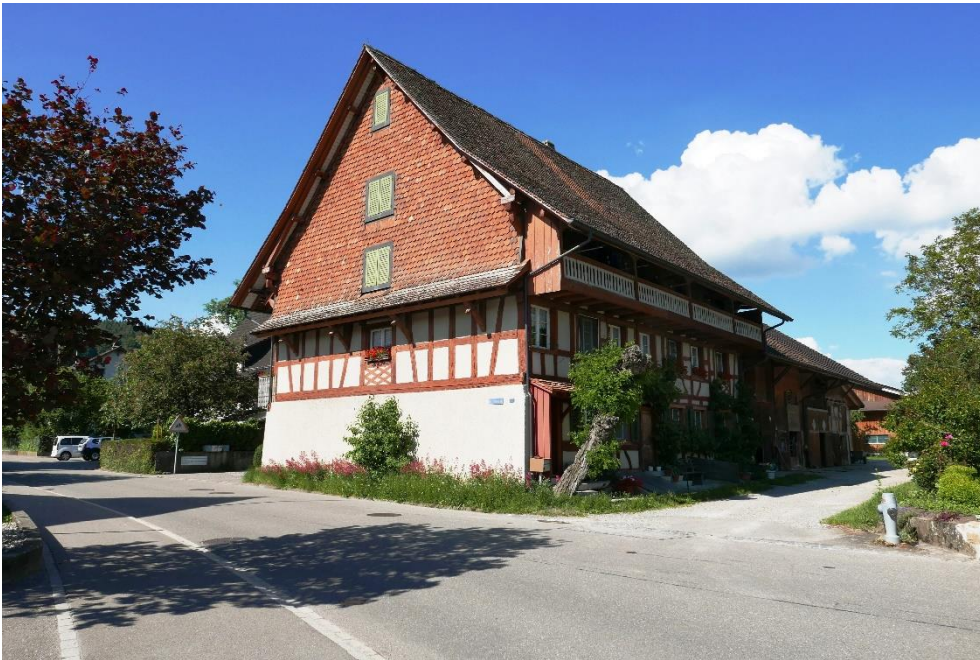
«Untervogthaus», Ansicht von SW, 06.06.2016 (Bild Nr. D100572_18).
