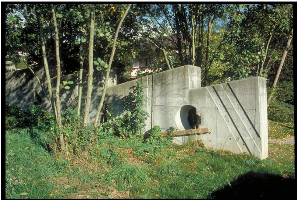
Sperrstelle 0667 Stadel, Panzersperre T02727, Erneuerung im Wohngebiet Rietwisen, 01.01.2009 (Bild Nr. D100682_92).
