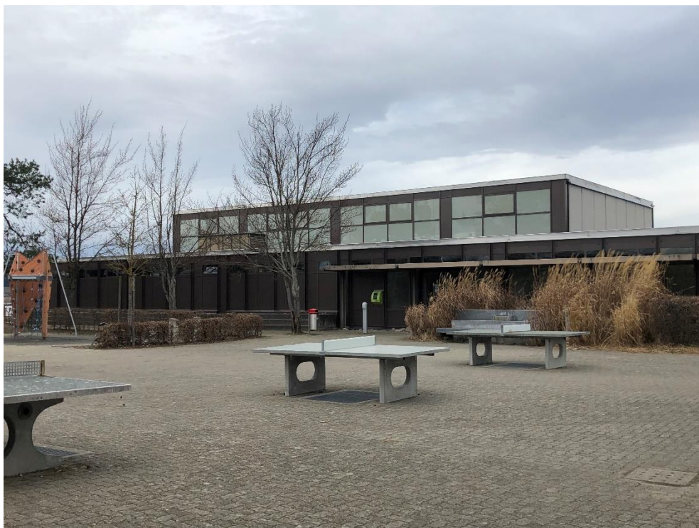
Schulanlage Schalmenacker, Turn- und Schwimmhalle (Vers. Nr. 00682), Schulhof mit Verbundsteinpflasterung und Brunnen (067UMGEBUNG00680), Ansicht von SO, 23.02.2020 (Bild Nr. D100577_67).
