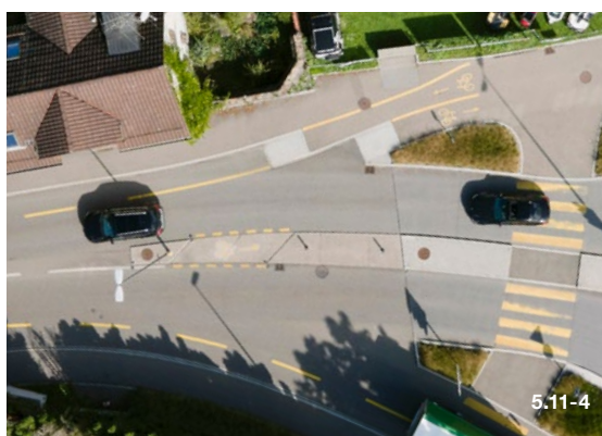
Rückführung und Zufahrt eines Radwegs auf die Rapperswilerstrasse in Wetzikon. Um auf den Radweg zu gelangen, können Velofahrende die Strasse in zwei Etappen queren.
