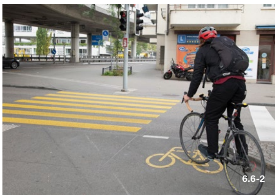
Querung mit Velofurt beim Escher-Wyss-Platz in Zürich
