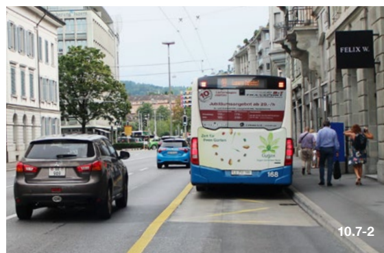
Fahrbahnhaltestelle mit Busstreifen und Veloverkehr. Überholen Velo/Bus nicht möglich. Haltestelle Hirzenhof, Luzern.
