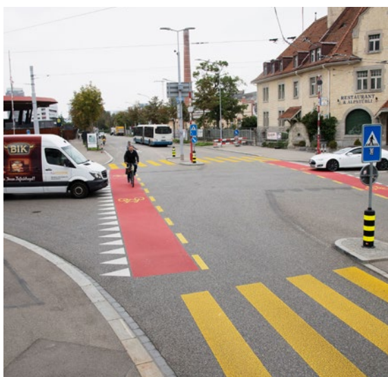
Radstreifen mit roter Einfärbung im Konfliktbereich bei der Einmündung Bullingerstrasse in Zürich 5.3-3
