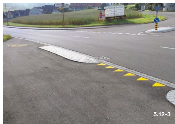
Anschluss des Radwegs an einen T-Knoten mit einem genügend grosszügigen Aufstellbereich. Stationsstrasse, Bonstetten.
