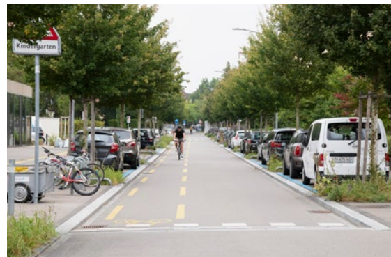
Je nach Frequenz des MIV ist eine weitergehende Markierung des Velogegeverkehrs sinnvoll, insbesondere entlang einer Längsparkierung für den motorisierten Verkehr. Scheuchzer-/Kinkelstrasse, Zürich.
