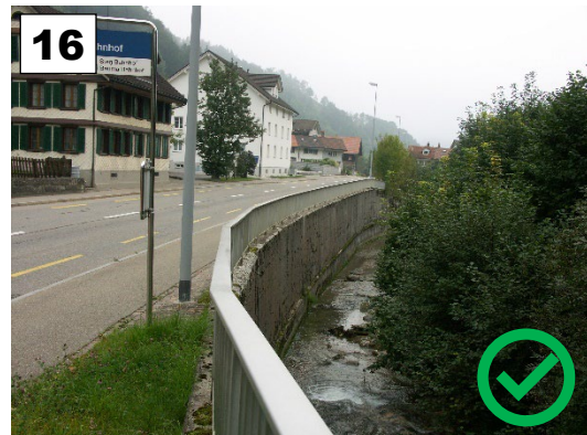
Geländer Typ Menziken ausreichend, wenn kein Fahrzeurückhaltesystem erforderlich
