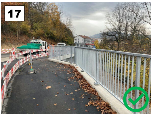
Staketengeländer innerorts, kein Fahrzeurückhaltesystem erforderlich
