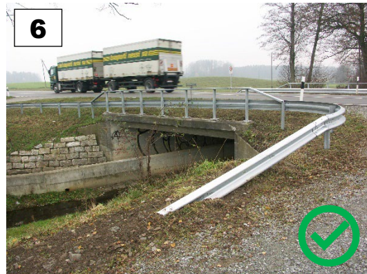
System LS 22 mit Geländerfunktion
