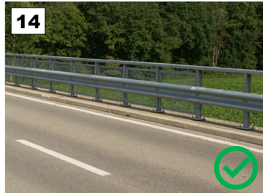
System LS 22 mit Geländerfunktion
