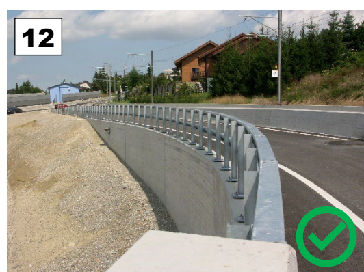
System LS 43 auf Stützmauer
