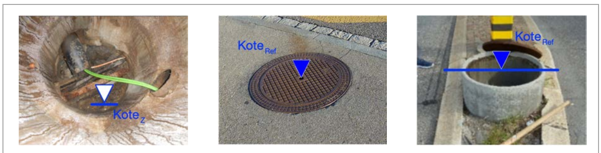
Abbildung 8: Beispiele Vermessung runde Schächte
