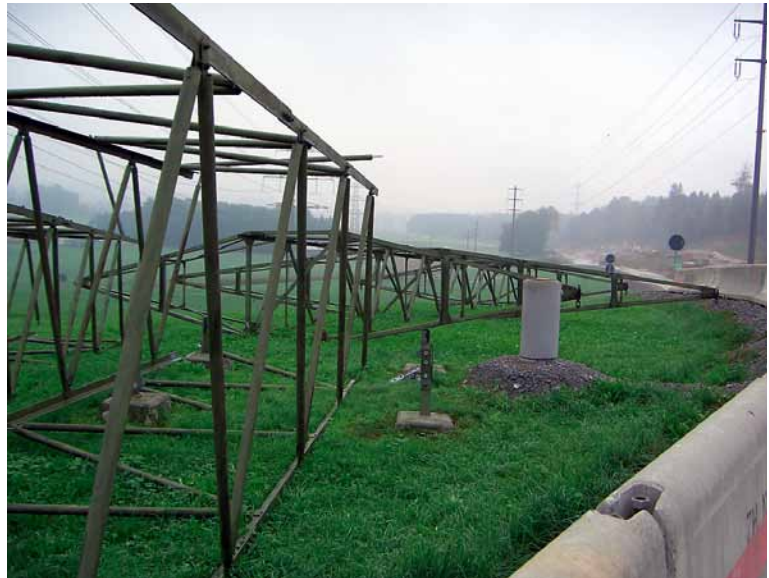
Demontierter Mast.
